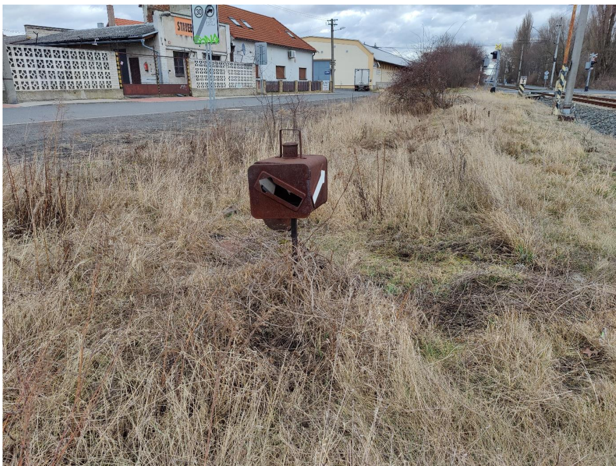
Obrázek 34 Pohled na výhybku B1 a kolej, která pod porostem není vidět, foto vlastní
