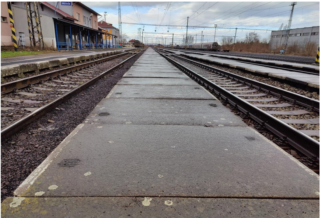
Obrázek 26 Pohled na II. nástupiště s konstrukcí SUDOP T, foto vlastní
