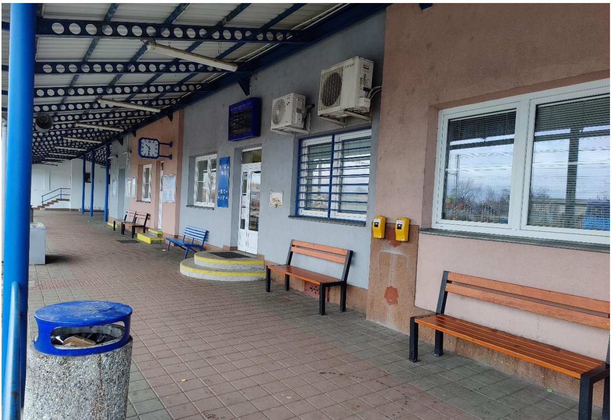
Obrázek 31 Pohled do venkovního zastřešeného prostoru výpravní budovy, foto vlastní
