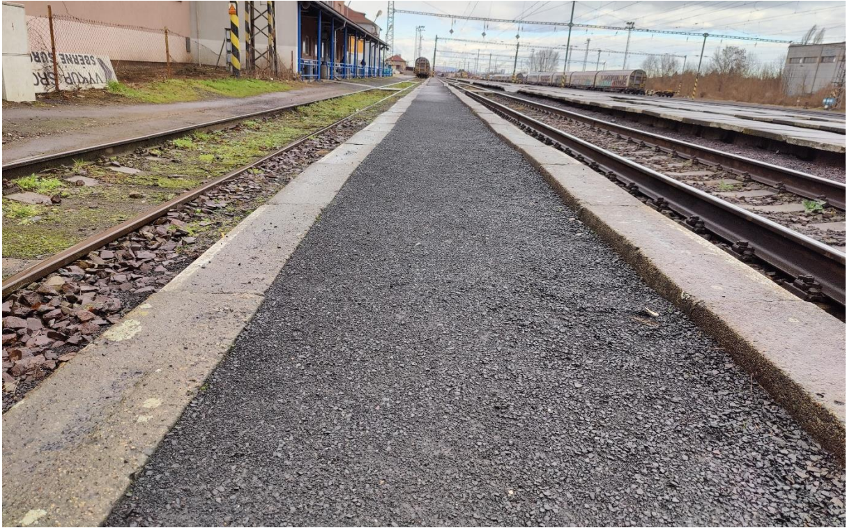
Obrázek 25 Pohled na I. nástupiště s konstrukcí Tisher, foto vlastní
