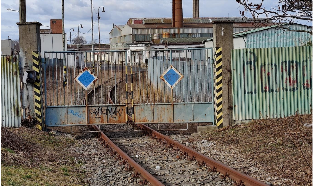
Obrázek 37 Zrezlé koleje vlečky při vjezdu do areálu společnosti Glazura s.r.o., foto vlastní
