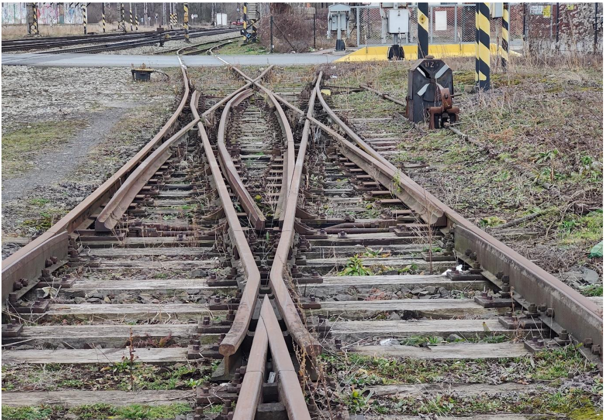
Obrázek 33 Výhybky a kusé koleje na vlečce, foto vlastní
