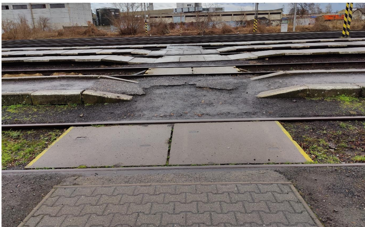
Obrázek 24 Pohled na úroňový přechod v km 371,686, foto vlastní
