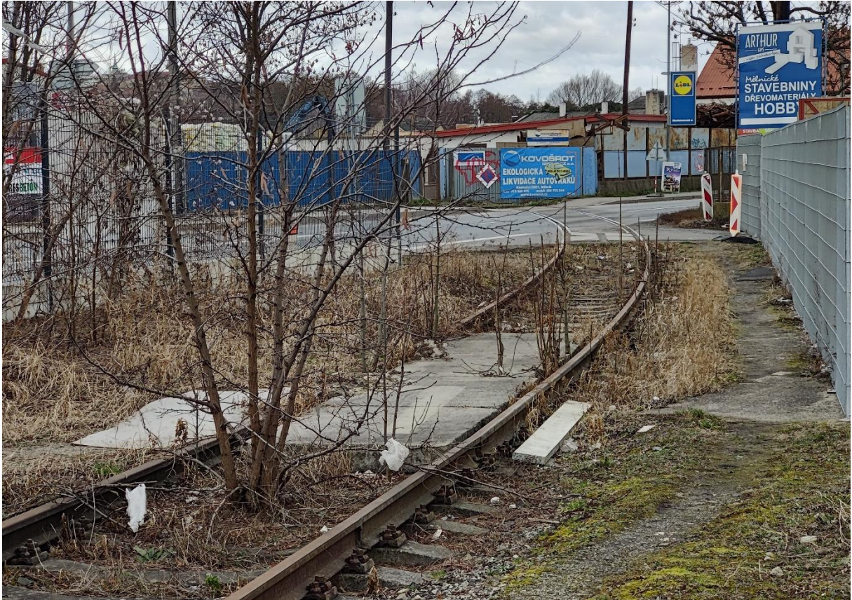
Obrázek 32 "Udržovaná" kolej vlečky V1102 před vjezdem do areálu, foto vlastní
