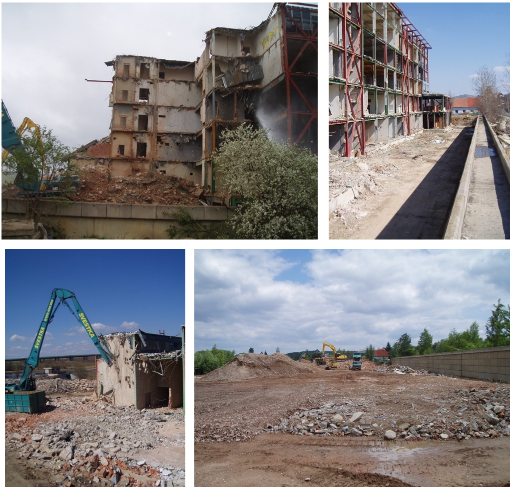
Obrázek 7 – Brownfield Jiviny – demolice (zdroj: archivní fotografie Bredo a.s.)
