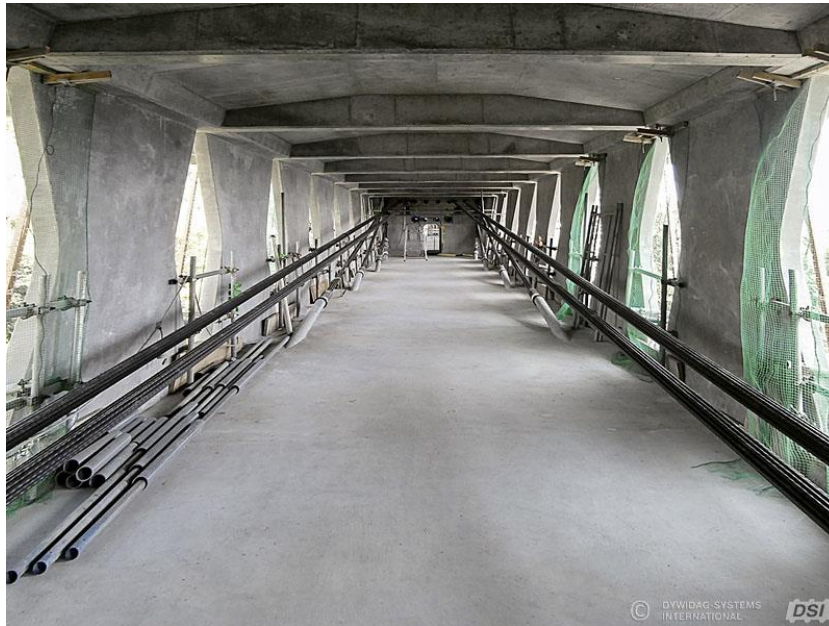
Obr. 2.7 – Pohled do komory mostu Takubogawa při výstavbě (Kasuga, 2010) [5] .
