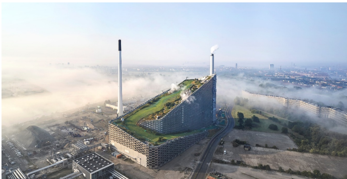
Obrázek 4. Spalovna v Dánsku Amager Bakke 14
