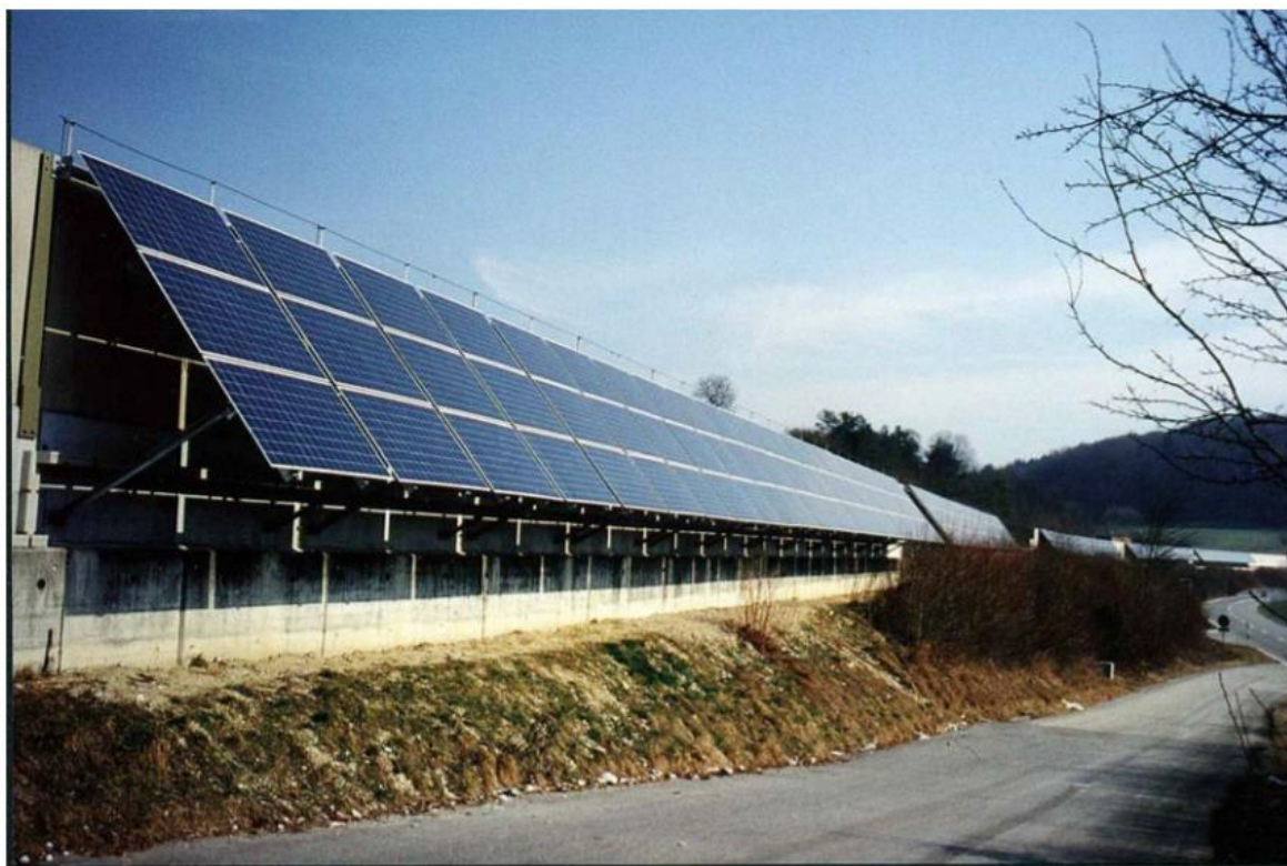
Obrázek 8 Příklad solární protihlukové stěny ve Švýcarsku na dálnici A2 [53]
