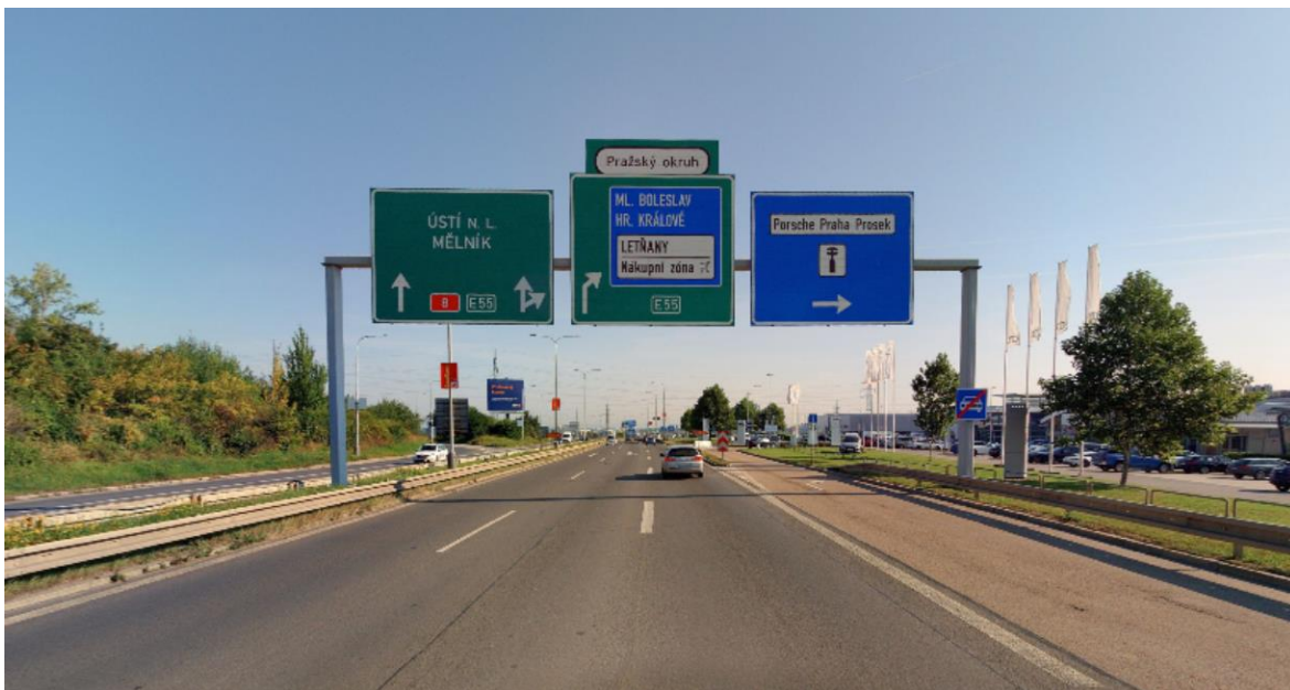
Obrázek 15 Ukázka portálu bez světelné signalizace na Pražském okruhu Zdroj: mapy.cz
