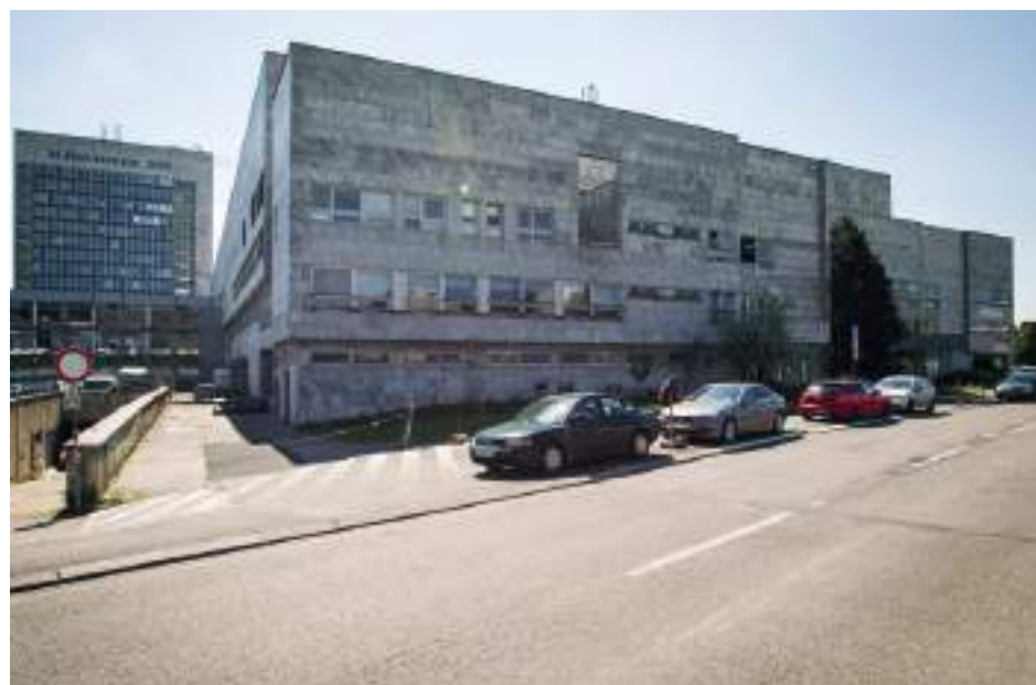
obr. 48 zadná fasáda - stav pred demoláciou
