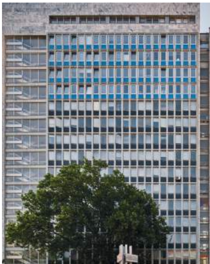
obr. 35 fasáda od dvora
