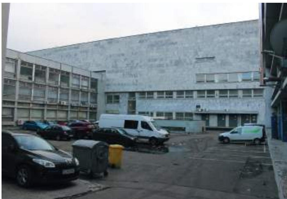
obr. 47 zadný dvor - stav pred demoláciou
