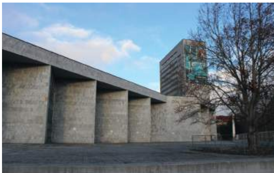
obr. 40 stav pred demoláciou
