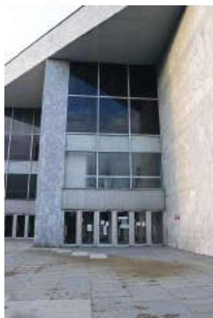
obr. 41 stav pred demoláciou
