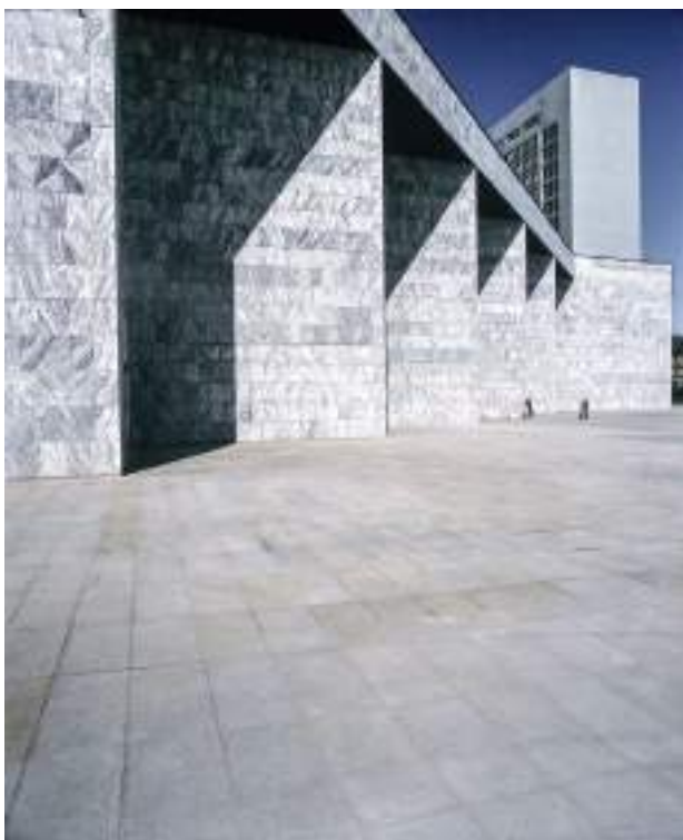
obr.148 stav pri dokončení
