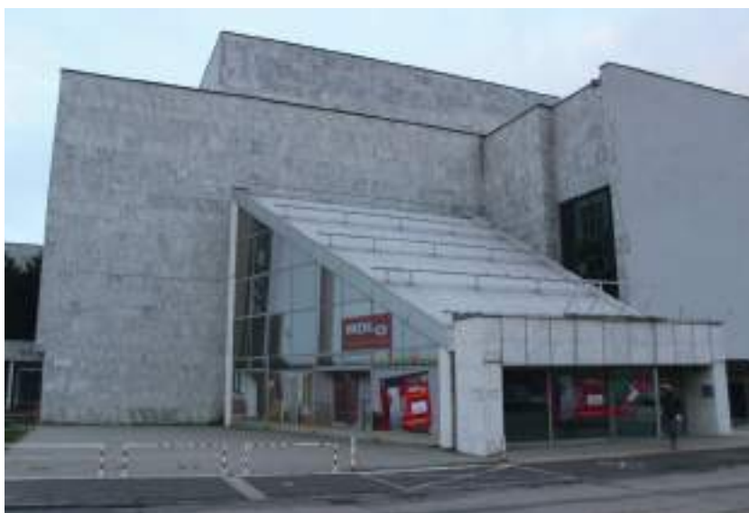
obr.144 stav pred demoláciou
