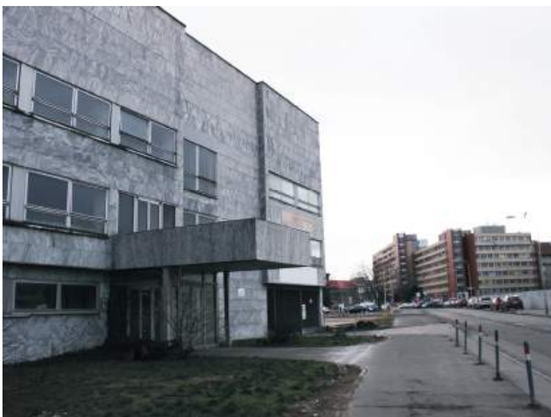
obr. 44 zamestnanecký vstup - stav pred demoláciou
