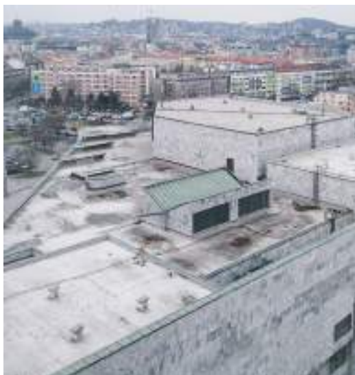
obr. 45 strešná krajina - stav pred demoláciou
