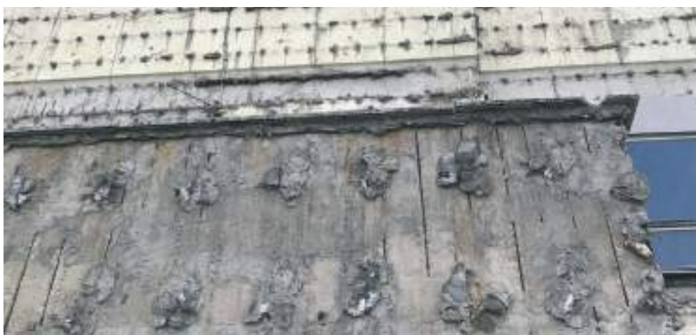
obr. 3.22 detail kotvenia mramoru na fasádu
