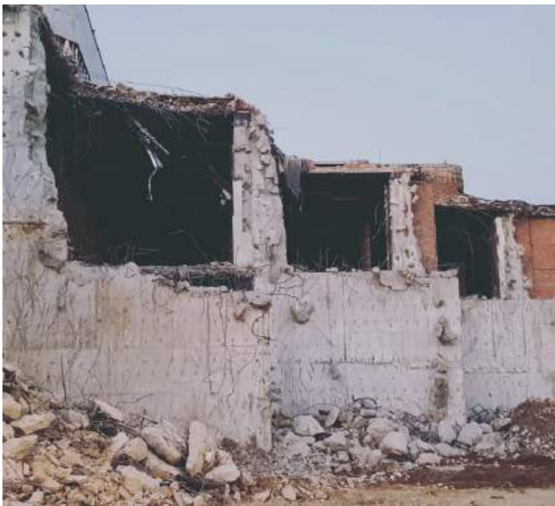
obr. 3.19 proces búrania píllovej fasády
