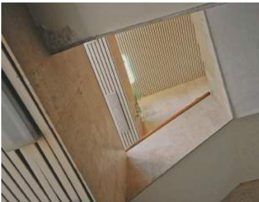
obr. 104 schodisko pri veľkej sále
