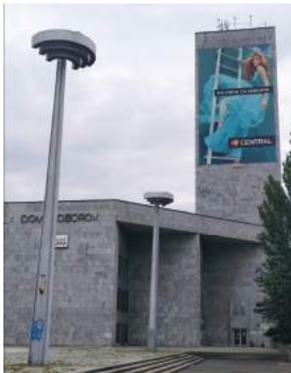
obr.149 stav pred demoláciou
