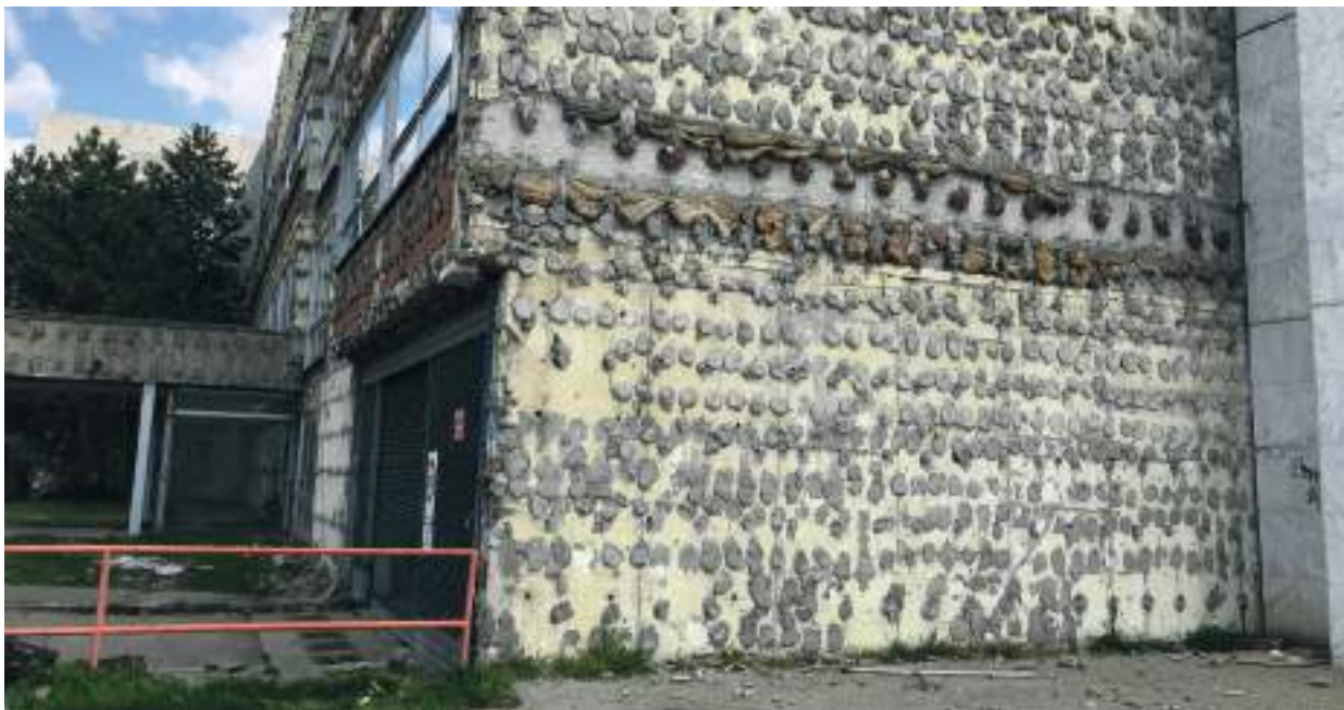
obr. 3.23 skladba fasády pod kamenným obkladom
