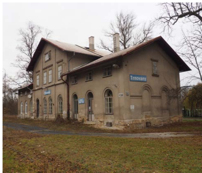
Budova bývalého nádraží, Trnovany zdroj: Petr Churáček, 2021
