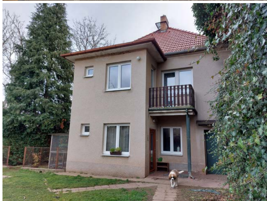
Přilehlá obytná vila, postavená ve 30. letech 20. st., Trnovany zdroj: Tomáš Efler, 2021
