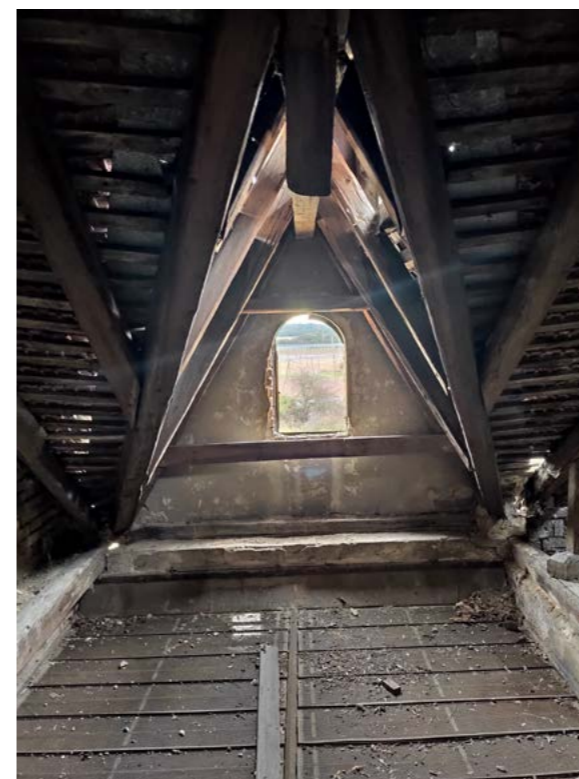
Podkroví sušárny se žaluziemi, č.p. 9, Trnovany zdroj: vlastní foto, 2021
