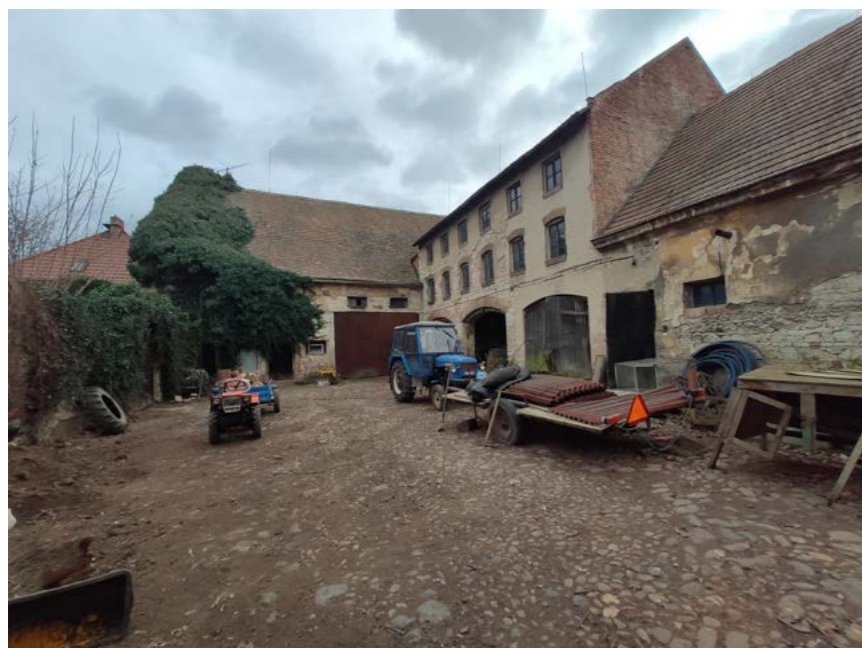
Severní dvorní průčelí usedlosti č.p. 9, Trnovany zdroj: vlastní foto, 2021
