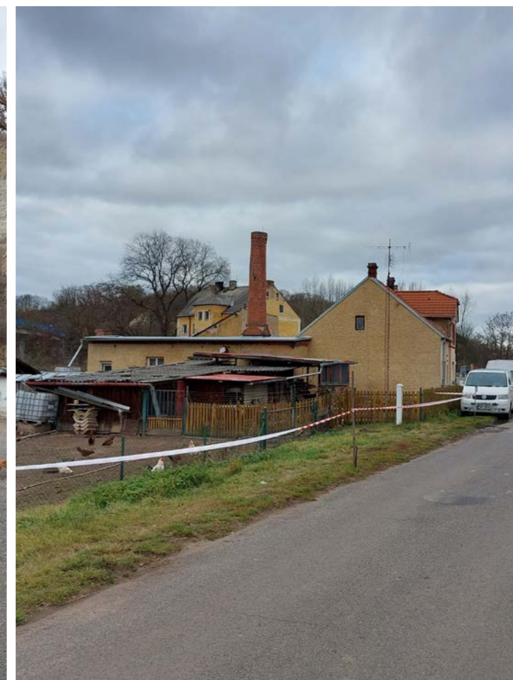
Bývalá sušárna chmele č.p.23, Trnovany zdroj: Tomáš Efler, 2021
