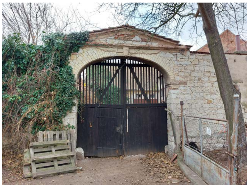
Vstupní brána, č.p. 9, Trnovany zdroj: vlastní foto, 2021
