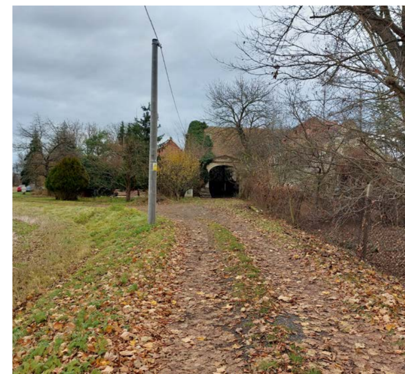
Příjezdová cesta, č.p. 9, Trnovany zdroj: vlastní foto, 2021
