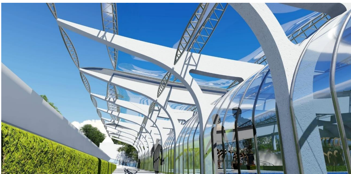
Obr. 85. Pohled na zaparkované pohyblivé membránové zastřešení z ETFE nad spojovacím koridorem.
