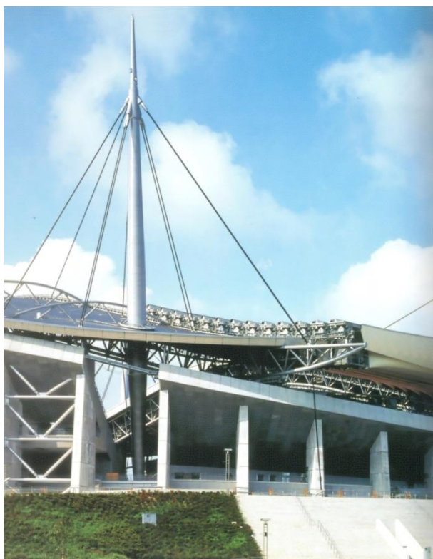
Obr. 94. Pohled na shrnuté zastřešení v dolní části stadionu [11]
