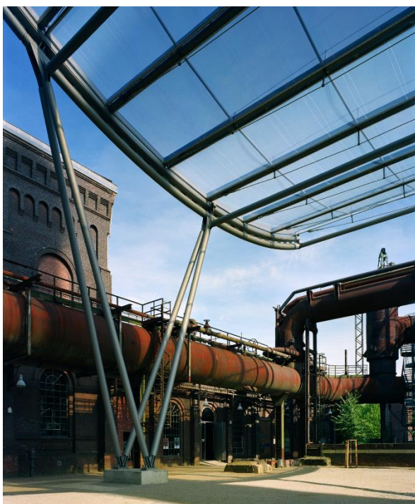
Obr. 45. Pohyblivé řetězová plocha z pneumatických ETFE polštářů. Landshaftparku – Duisburg Nord [21]
