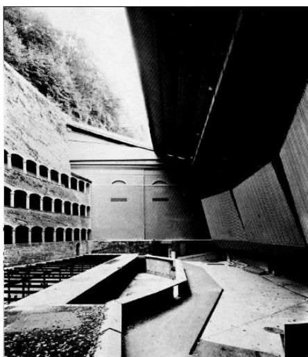
Obr. 103. Fotografie a řez pohyblivým zastřešením skalního divadla [1]
