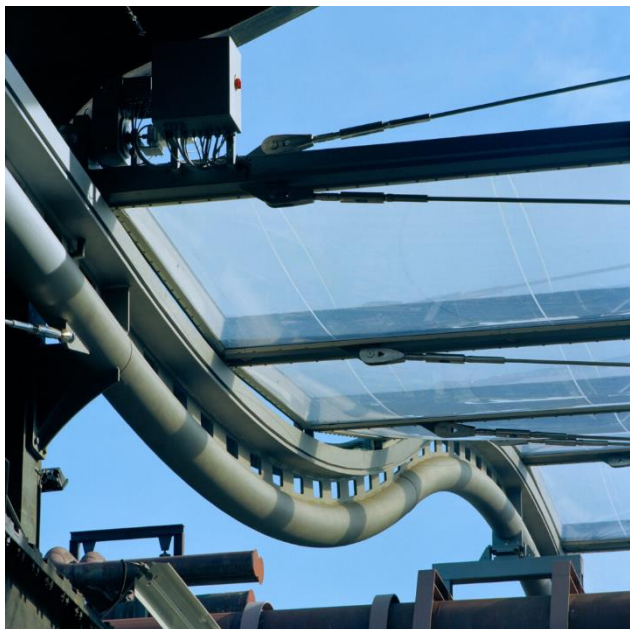
Obr. 33a Detail jeřábové dráhy Pneumatické řetězové lomenice Landshaft park [13]
