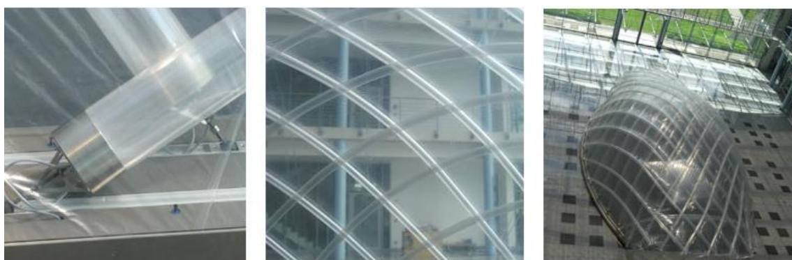
Obr. 46. Pohled na natlakovaný pneumatický gridshell + detail zakončení pneumatické trubice. [22]
