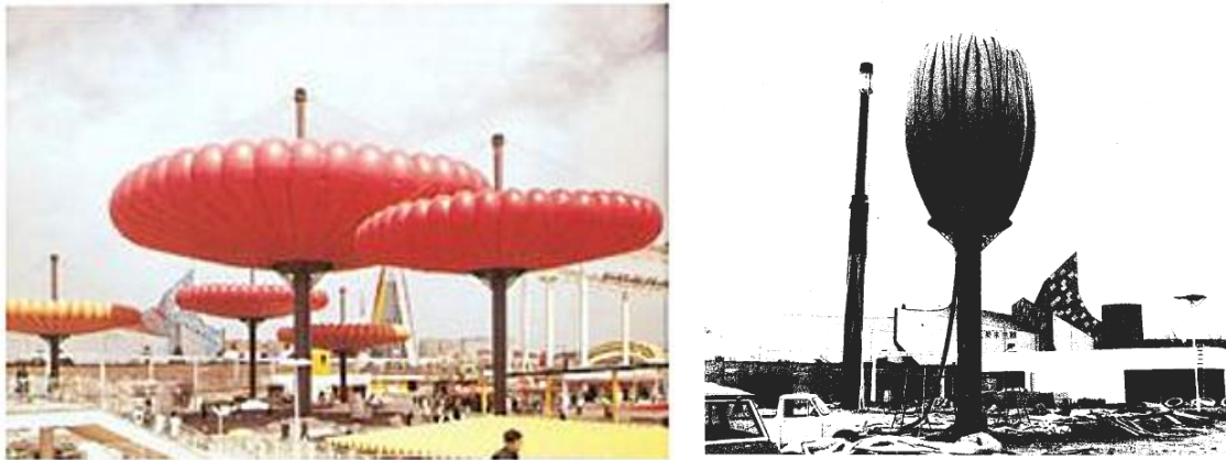
Obr. 43. Rozevřené a složené pneumatické zastřešení – EXPO Osaka. [19]
