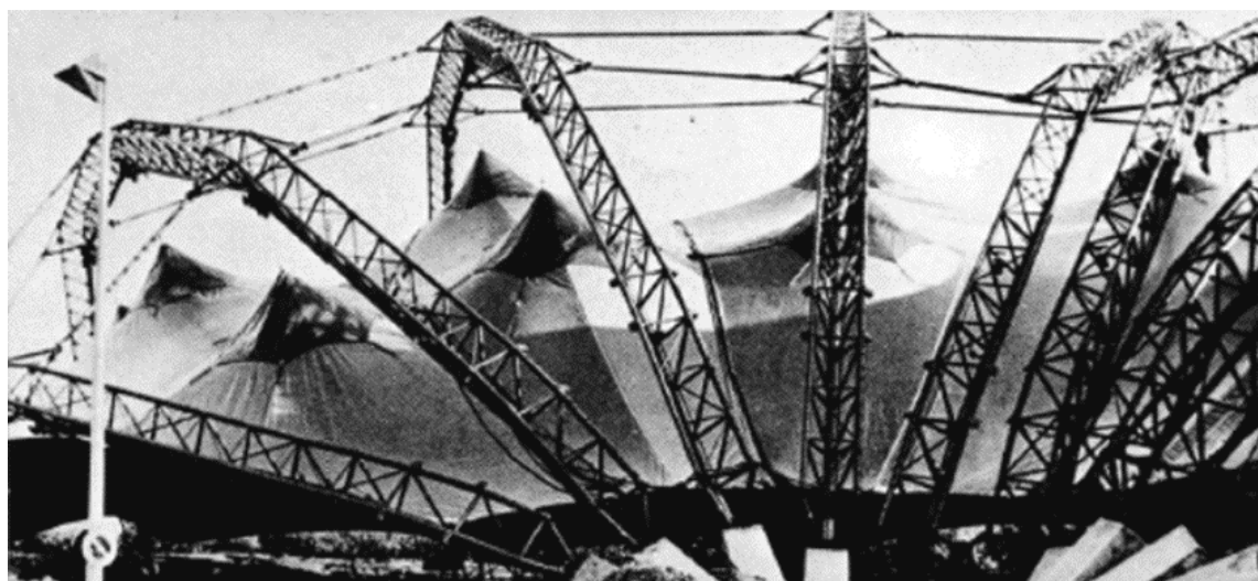
Obr. 108. fotografie realizovaného zastřešení [1]
