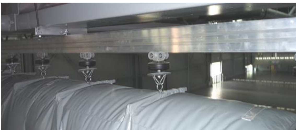
Obr. 33 b. Detail kladkového systému pohyblivé pneumatické příčky – výstaviště ČB. [14]
