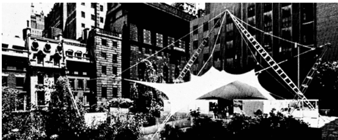
Obr. 110. Fotografie realizovaného membránového zastřešení [1]
