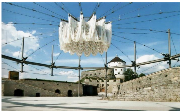
Obr. 39. Složené membránové zastřešení Kufstein [11]
