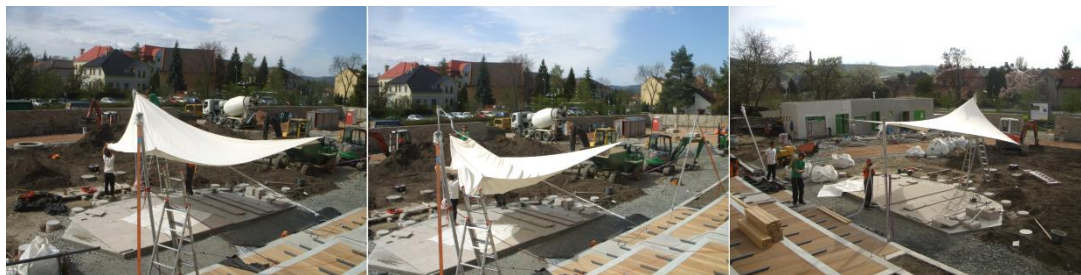
Obr. 25. Proces napínání mobilní stínící membrány v zámeckém parku Hranice na Moravě – foto autor
