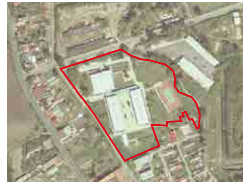
Letecký měřičský snímek 2005, vedle budovy školy postaveno atletické hřiště
