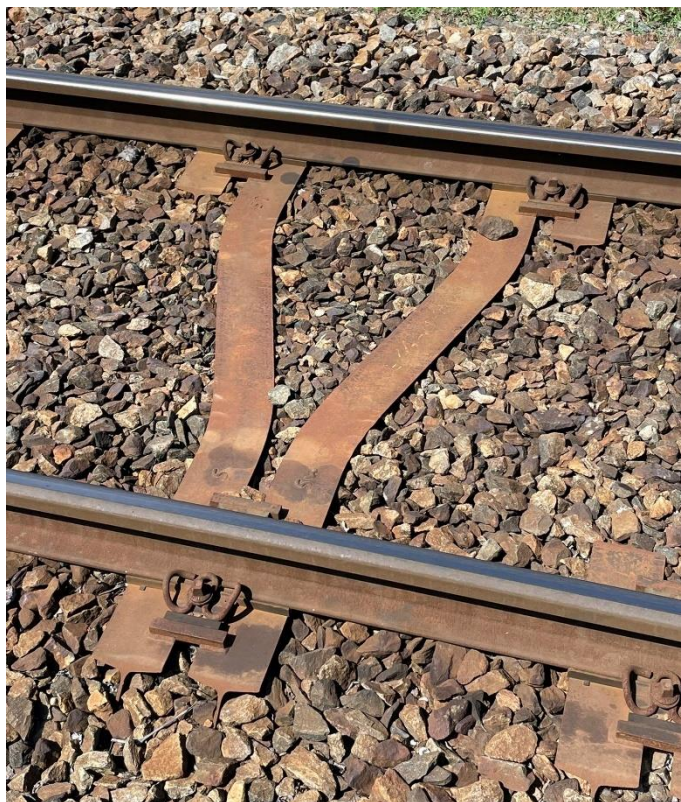
Obrázek 9 – Ocelový pražec tvaru Y v mezistaničním úseku Zruč nad Sázavou – Kácov [zdroj: archiv autora]
