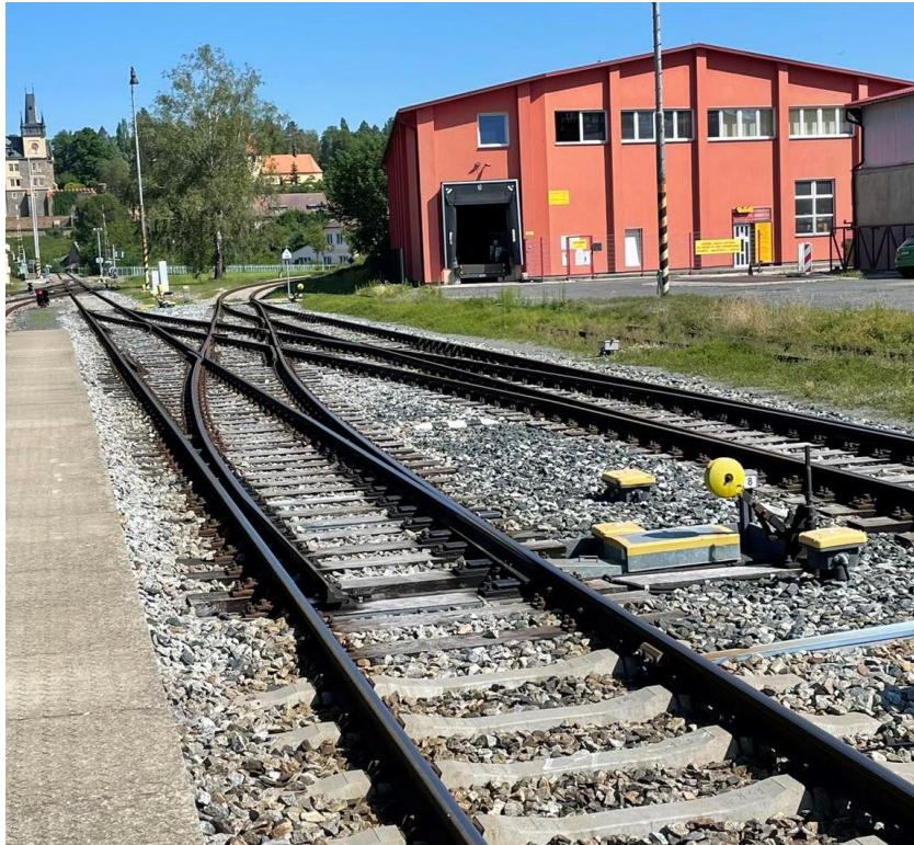
Obrázek 15 – Pohled na dvojitou kolejovou spojku směrem od nástupiště č. 3 [zdroj: archiv autora]
