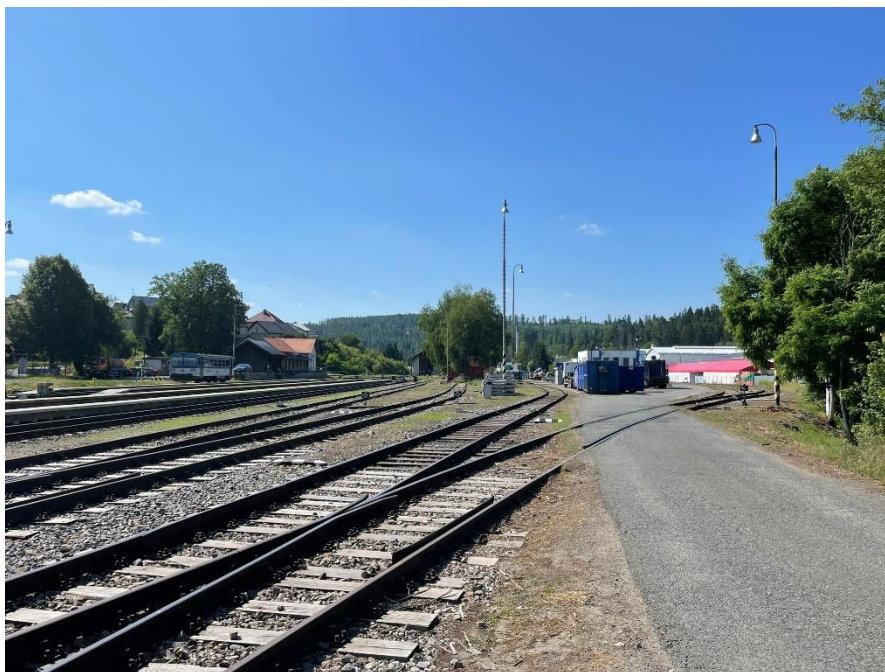
Obrázek 14 – Manipulační plocha rozdělující kolejiště na dvě části [zdroj: archiv autora]
