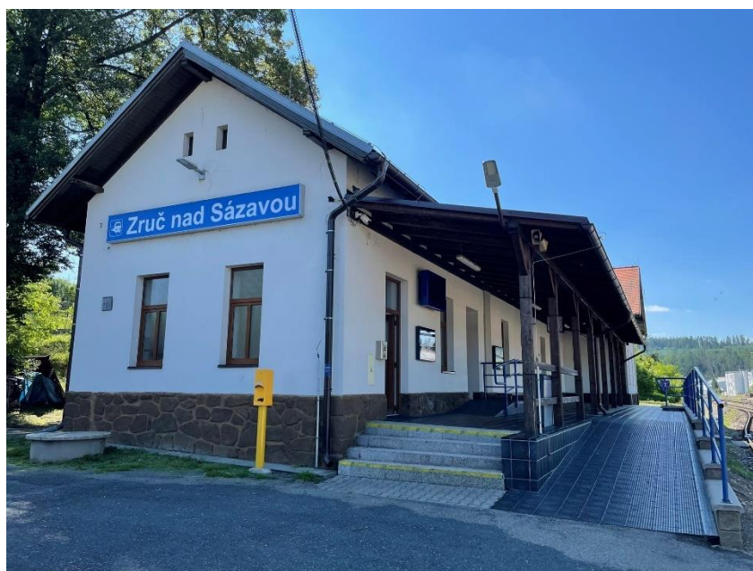
Obrázek 23 – Zrekonstruovaná výpravní budova s rampou pro bezbariérový přístup [zdroj: archiv autora]
