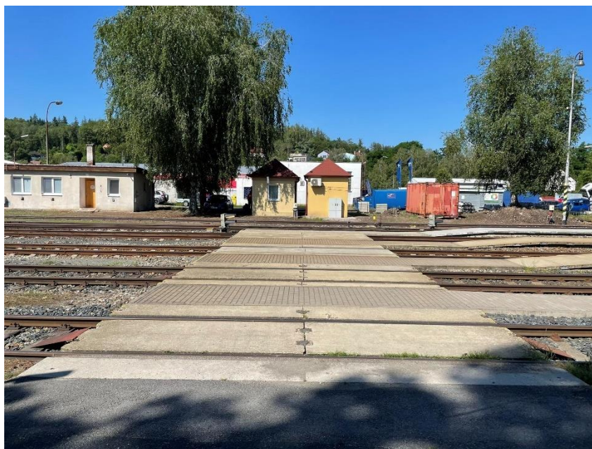
Obrázek 20 – Úrovňový přechod sloužící jako přístup k nástupištím [zdroj: archiv autora]
