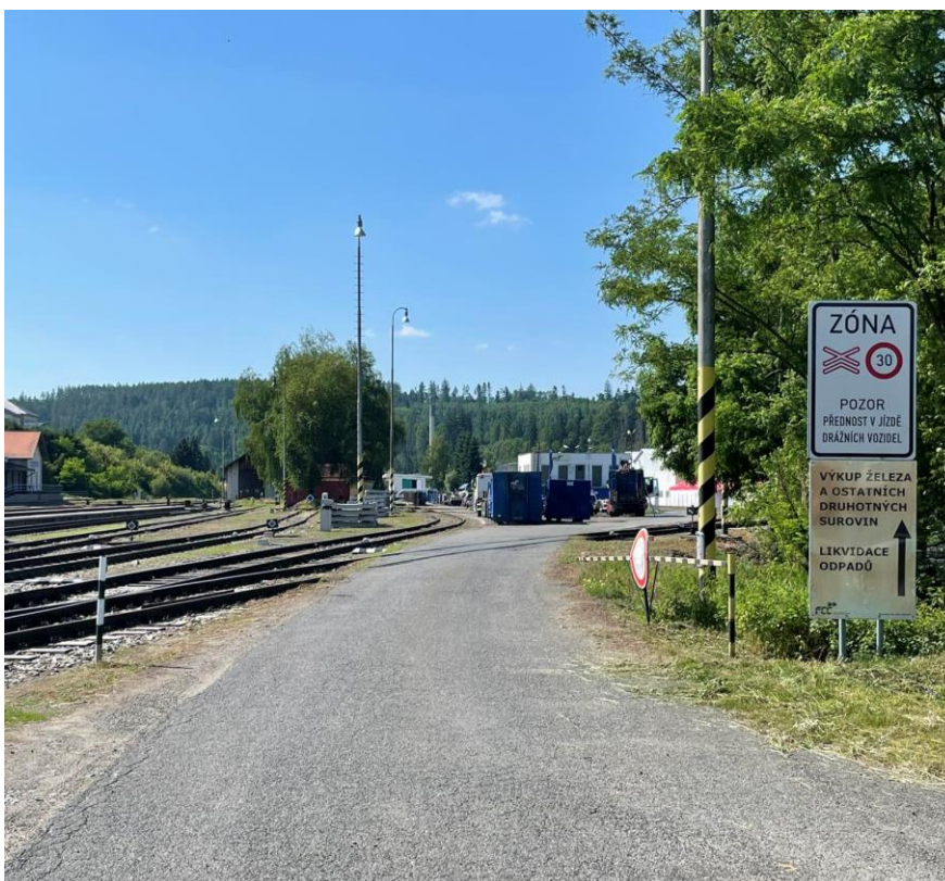
Obrázek 19 – Úrovňové křížení s účelovou PK s přilehlým SDZ IZ8a [zdroj: archiv autora]
