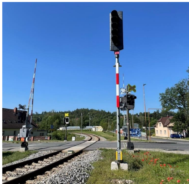
Obrázek 16 – Vjezdové návěstidlo od Zbraslavic [zdroj: archiv autora]
