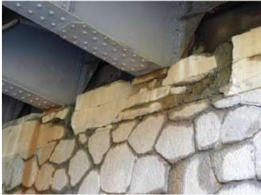
Obrázek 3.8: Degradace opěr
