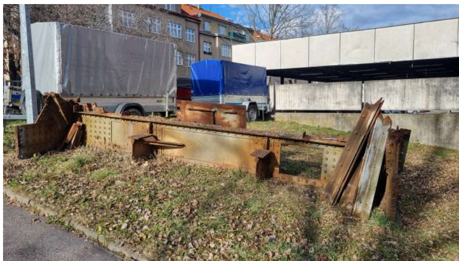
Obrázek 5.1: Dolní pásnice demontované příhradové konstrukce
