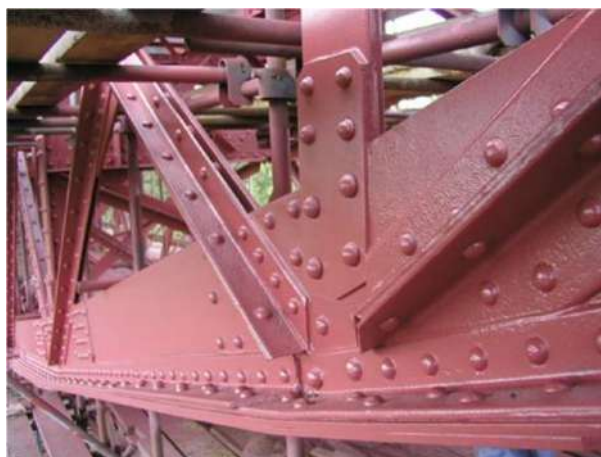
Obrázek 2.2: Příklad opraveného nýtovaného styčnicu[2]
