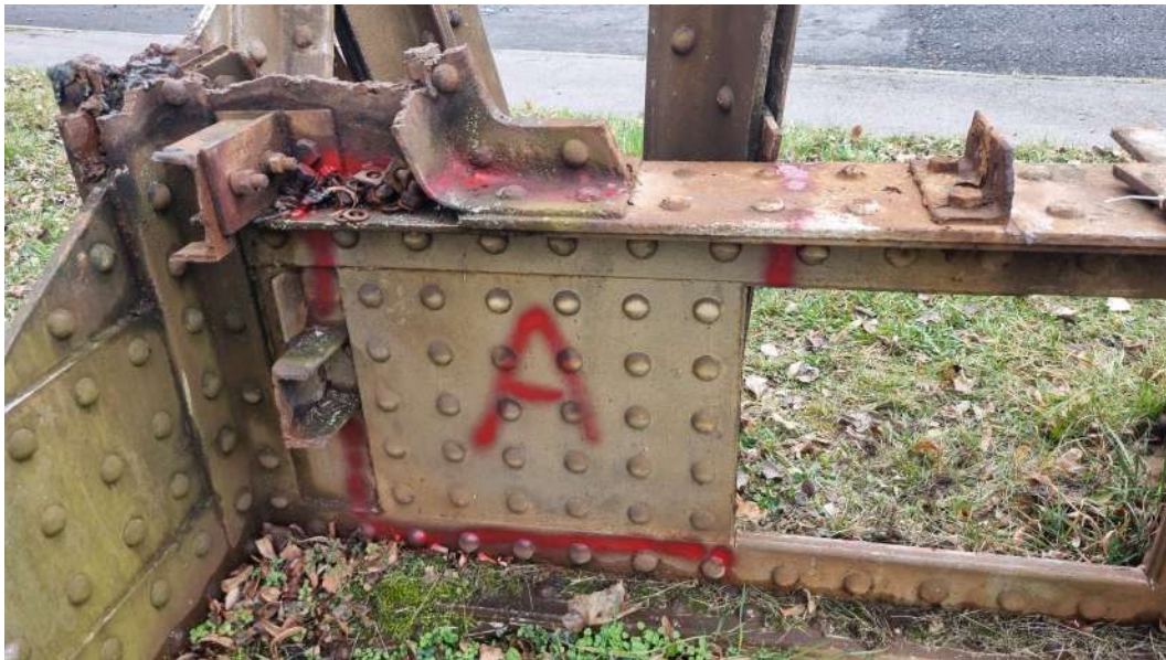
Obrázek 5.3: Část konstrukce zvolená pro vzorek typu A
