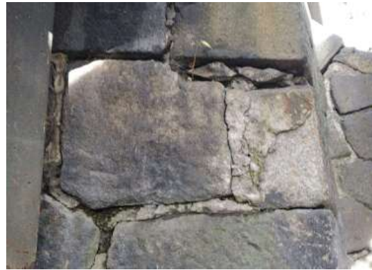
Obrázek 3.8: Degradace opěr
