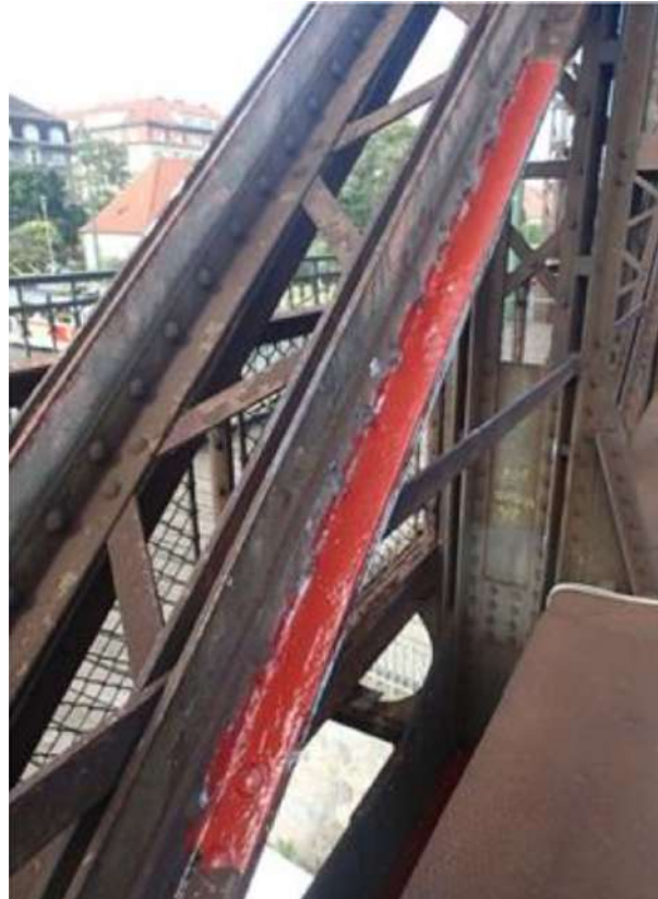
Obrázek 2.4: Detail zesílení lepenou lamelou CFRP[2]
