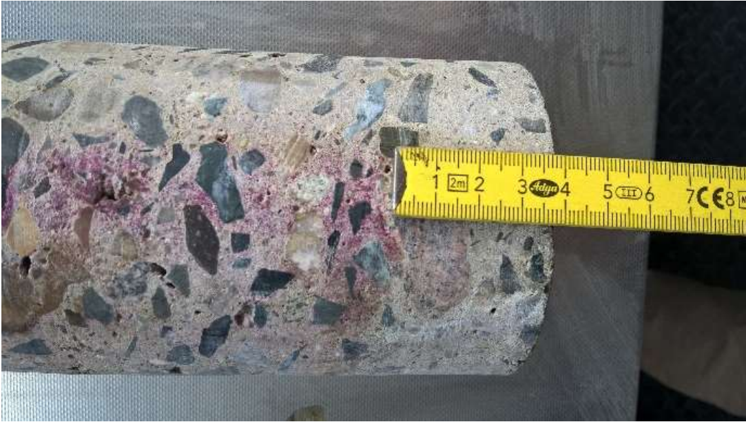
Obrázek 2.13: Výsledek experimentálního stanovení hloubky karbonatace
