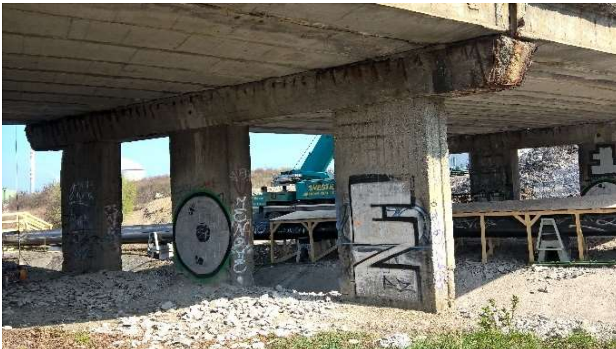
Obrázek 2.12: Mostní konstrukce, ze které byly odebrány vzorky
