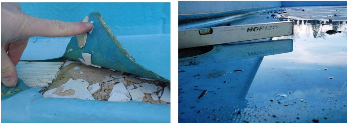
Obr. 192 - 193: Nekvalitní aplikace materiálu
