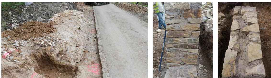
Obr. 13: Stav základů po odkrytí, Obr. 14 - 15: Ukázka zdění
