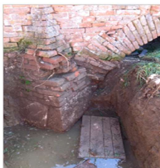
Obr. 51: Kopaná sonda S1 u pilíře č. 6, Obr. 52: Stávající stav mostu - zakreslení sondy
