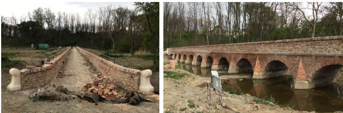
Obr. 68 - 72: Zaplavování stavební jámy v okolí mostu v průběhu stavebních prací, ukázka stávajícího odvodnění a stavu mostovky s nalezenou dlažbou, (stav březen - duben 2020)
