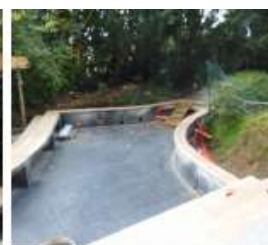
Obr. 202 - 204: Aplikace elastomerní polyurey na terase v Horkách nad Jizerou, objekt 2
