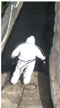
Obr. 140: Experimentální aplikace materiálu na mostě
