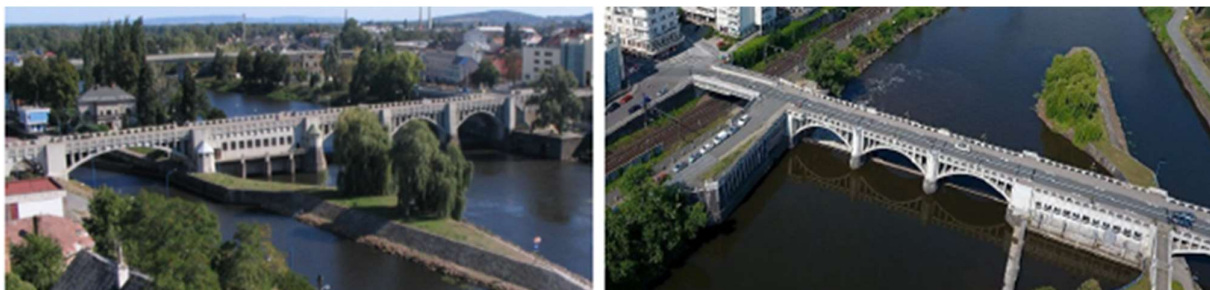
Obr. 144 – 145: Masarykův most v Kolíně - pohledy na stávající stav mostu
