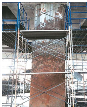
Obr. 207 - 211: Viadukt CINTA COSTERA III, původní stav, osazení lešení a provádění aplikace elastomerní polyurey, Obr. 204: Současný stav po aplikaci elastomerní polyurey [142]
