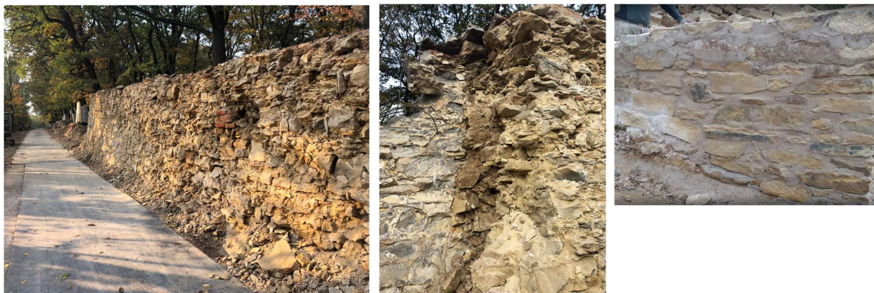
Obr. 19, 20: Původní stav zdiva, Obr. 21: Část zdiva po rekonstrukci (r.2019)
