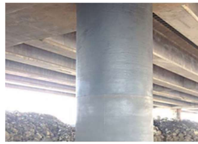
Obr. 207 - 211: Viadukt CINTA COSTERA III, původní stav, osazení lešení a provádění aplikace elastomerní polyurey, Obr. 204: Současný stav po aplikaci elastomerní polyurey [142]
