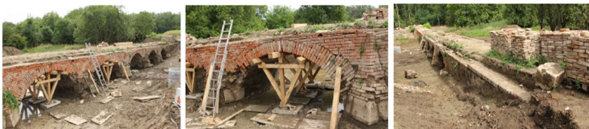
Obr. 65 - 67: Průběh rekonstrukce mostu (podepření kleneb, zajištění cihel)
