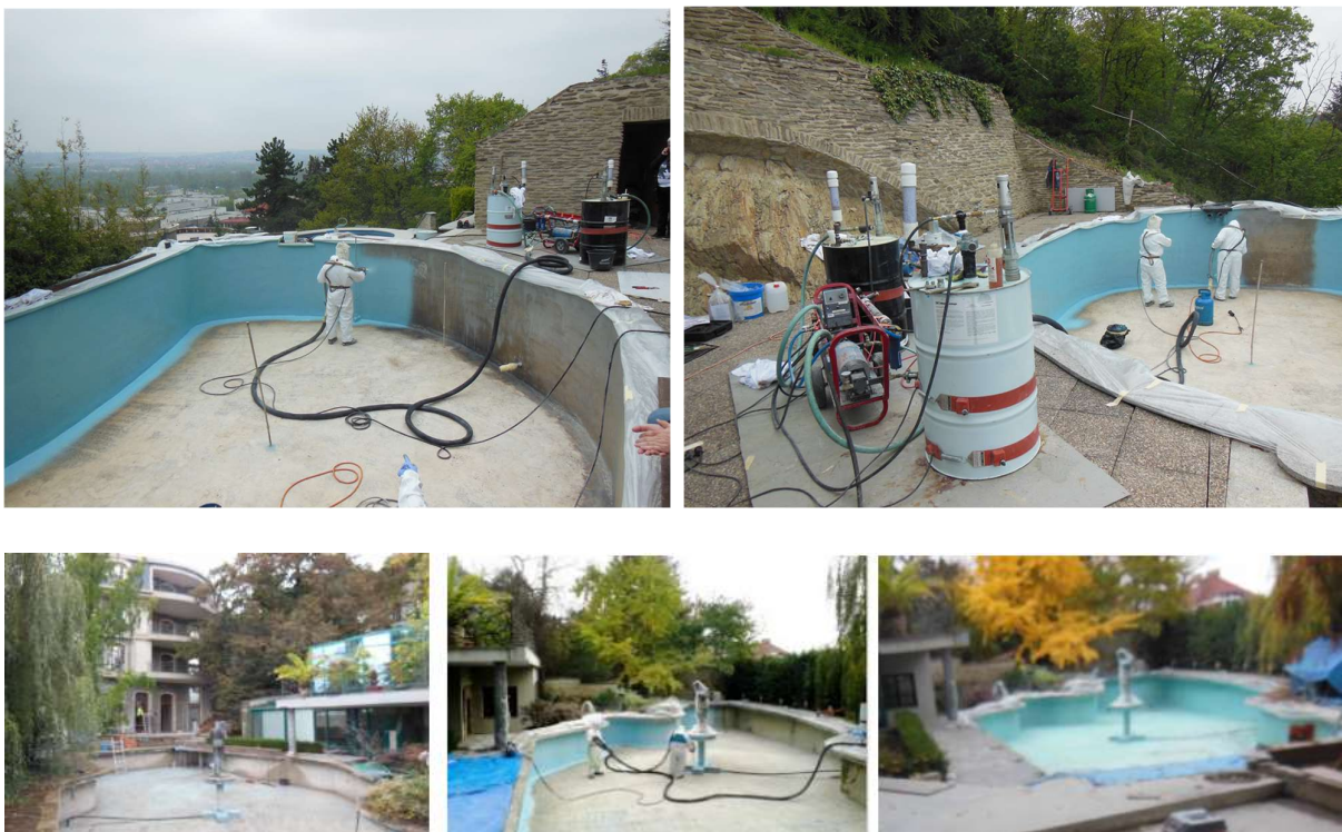
Obr. 185 – 189: Aplikace elastomerní polyurey v nádržích, r. 2015
