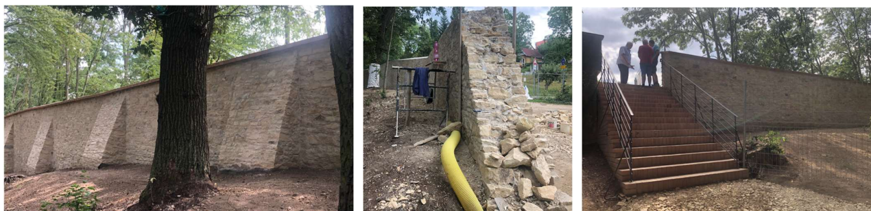
Obr. 16: Nový stav zdi, pohled ze strany obory, Obr. 17: Příčný řez zdi s drenáží, Obr. 18: Schodiště, (léto 2019)
