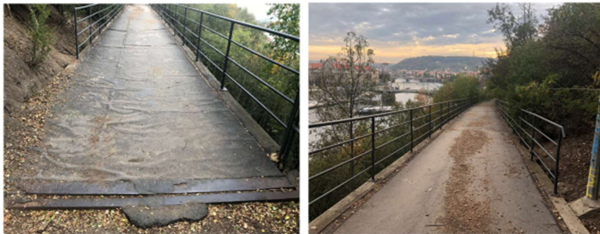
Obr. 123 -124: Estakády na Letné - stávající stav, estakáda č.4
