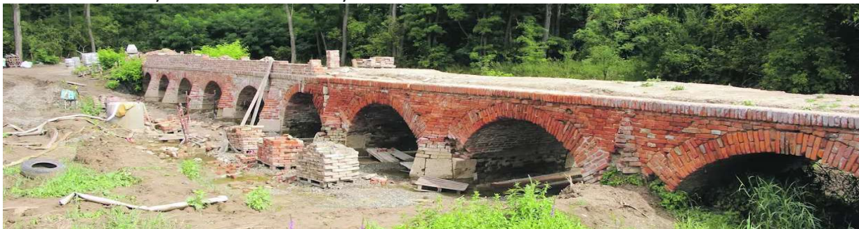
Obr. 64: Stav během rekonstrukce, léto 2019 (odkrytí mostu)
