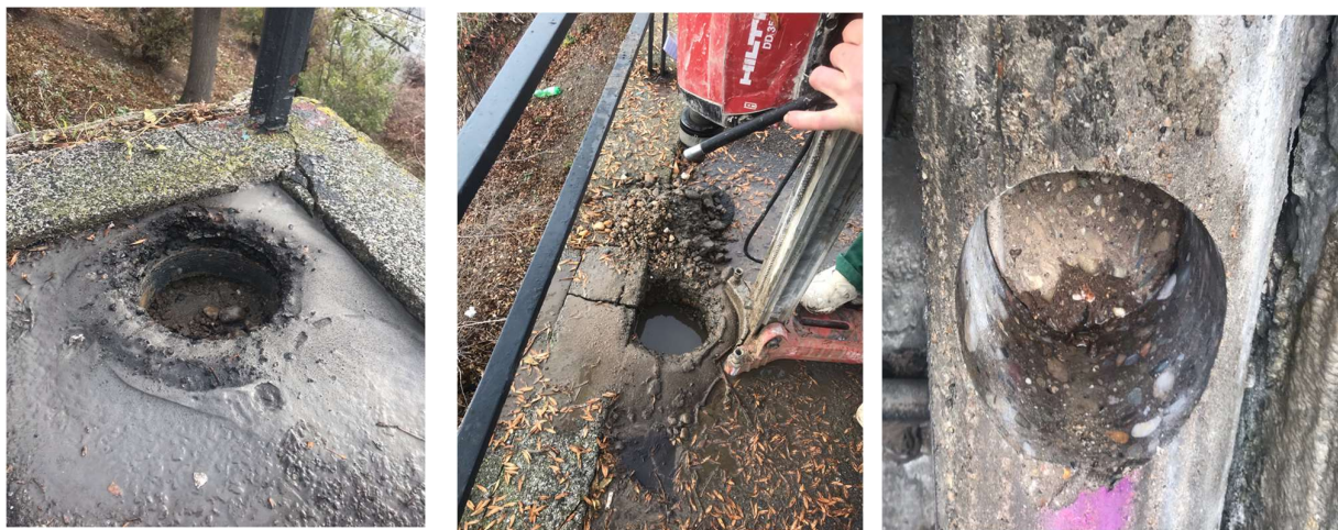
Obr. 125 - 127: Diagnostika estakád - jádrové vrtání
