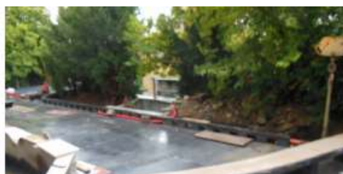
Obr. 202 - 204: Aplikace elastomerní polyurey na terase v Horkách nad Jizerou, objekt 2
