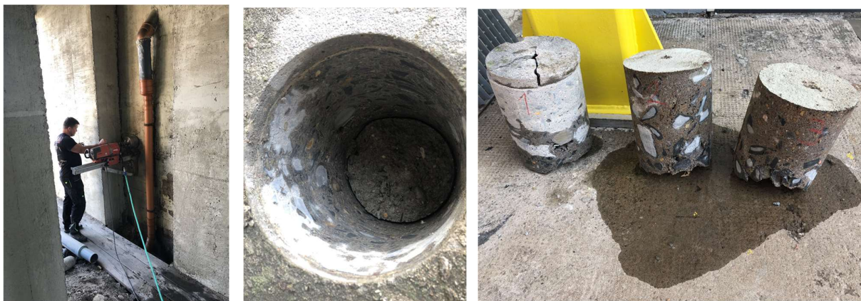
Obr. 158 – 160: Jádrové vrtání (chlazení vodou, obj. D, výtvy)
