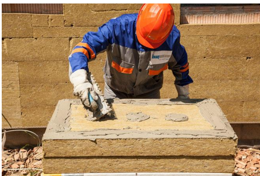
Obr. 3: Nanášení lepidla na izolační desku [5]
