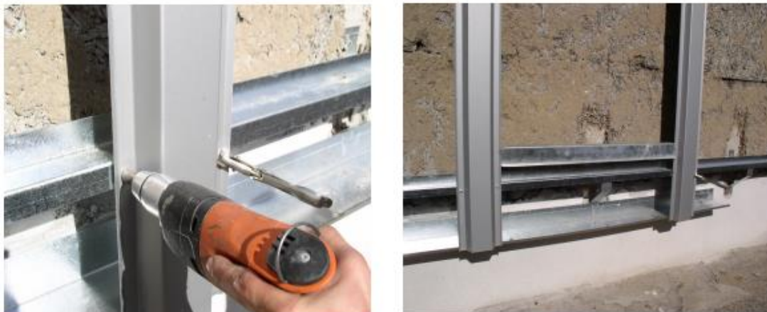
Obr. 7: Montáž svislých OM-profilů [5]
