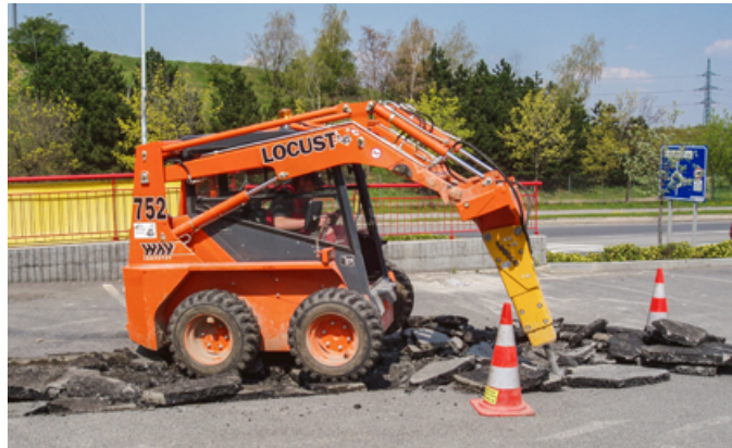
Obrázek 37: Demolice asfaltové vozovky pomocí bouracího kladiva [65]
