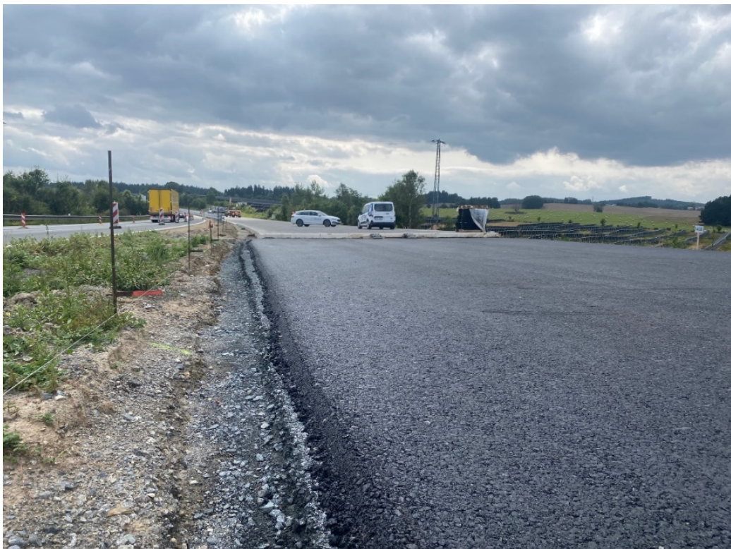
Obrázek 25: Položená první vrstva VMT v předpolí mostu na dálnici (vlastní foto)
