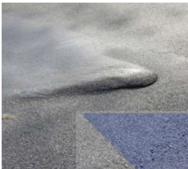
Obrázek 52: Nepravidelné hrboly [18]
