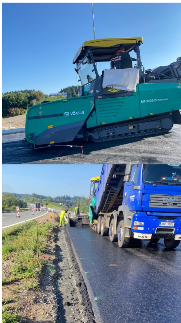
Obrázek 29: Pokládka hutněné asfaltové směsi (vlastní foto)
