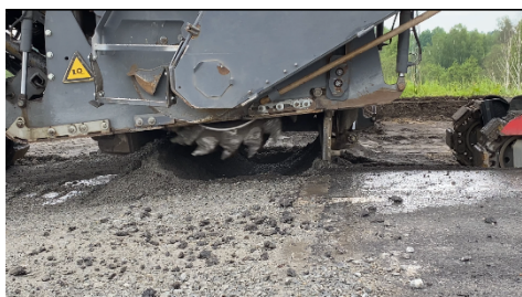
Obrázek 36: Buben silniční asfaltové frézy (vlastní foto)
