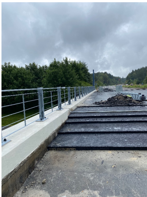
Obrázek 23: Ukázka pokládky litého asfaltu (vlastní foto)
