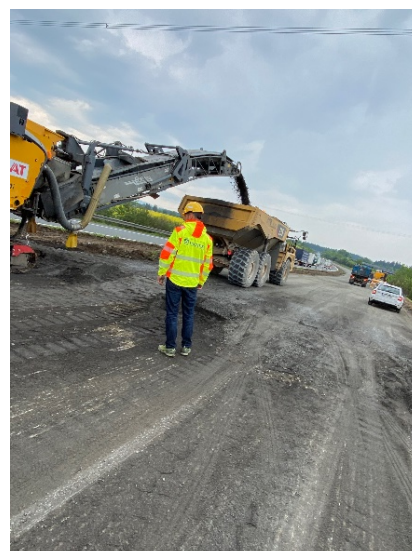
Obrázek 35: Silniční asfaltová fréza (vlastní foto)
