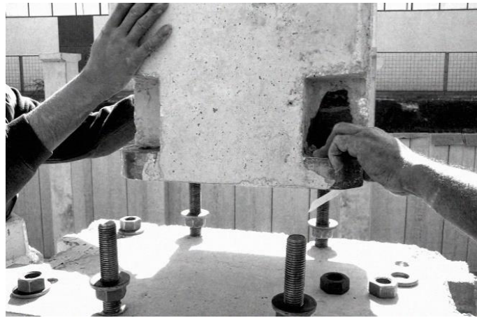
Obr. 14 - Montáž prefabrikovaných betonových sloupů demonstrátoru[26]
