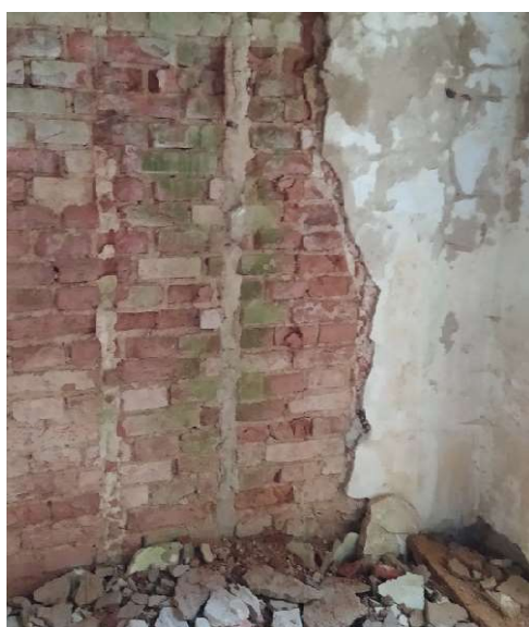
Obrázek číslo 1.13- Nosná stěna z CPP
