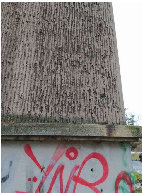
Obrázek číslo 1.48 – Strukturovaná omítka a soklová římsa
