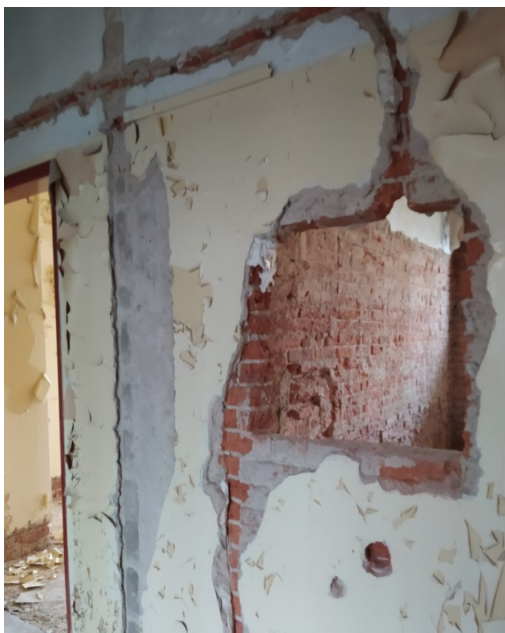
Obrázek číslo 1.53 – Otvor v příčce
