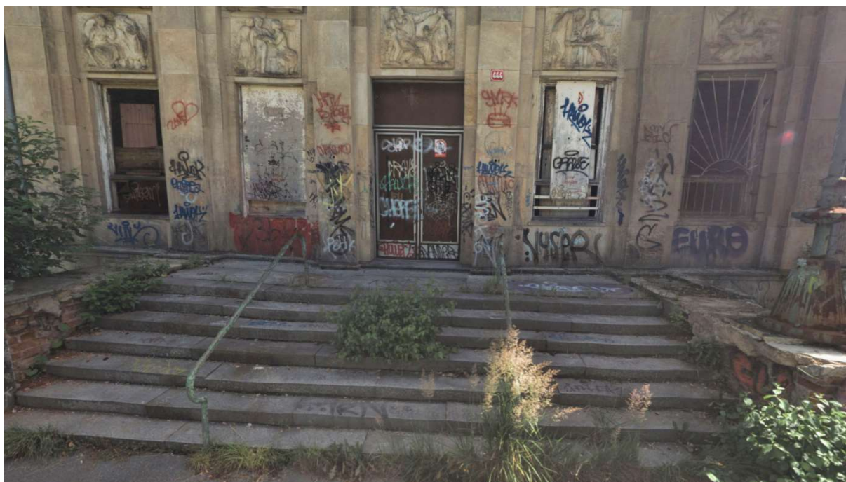
Obrázek číslo 1.32- Předsazené venkovní schodiště u hlavního vstupu
