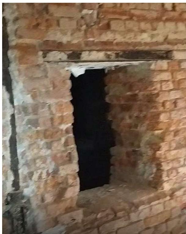
Obrázek číslo 1.25 – Ocelový překlad nad otvorem v 1.PP ve starší části objektu
