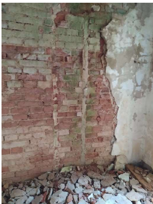
Obrázek číslo 1.9- Cihelné nosné zdivo
