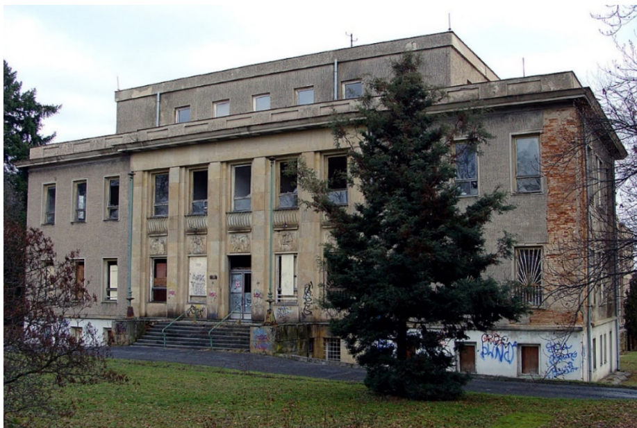
Obrázek číslo 1.7- Hlavní vstup do objektu (jihozápadní průčelí) [6]
