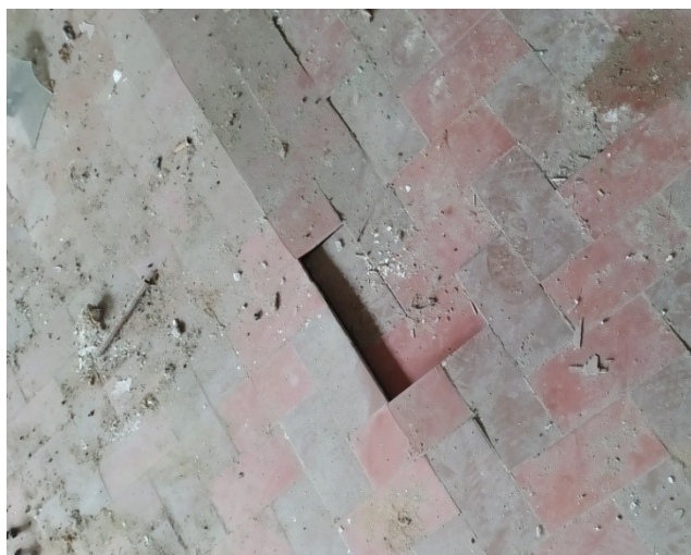
Obrázek číslo 1.40 – Dlažba odlepená od podkladu vlivem vlhkosti
