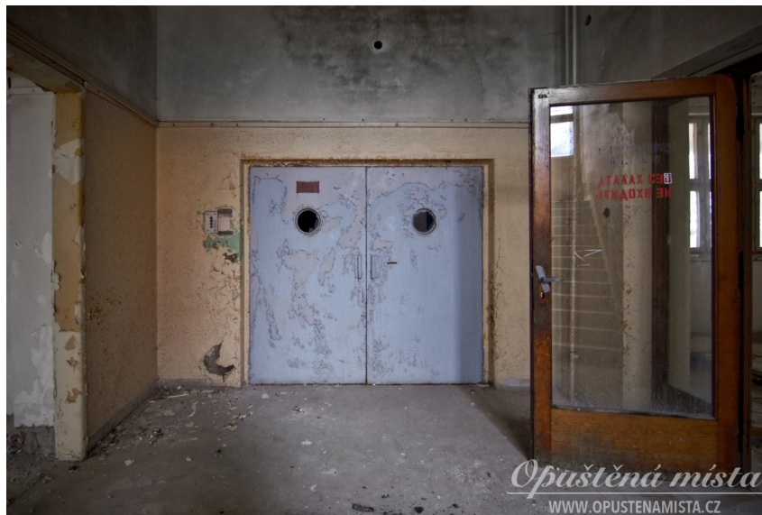
Obrázek číslo 1.34- Dveře do výtahové šachty [10]
