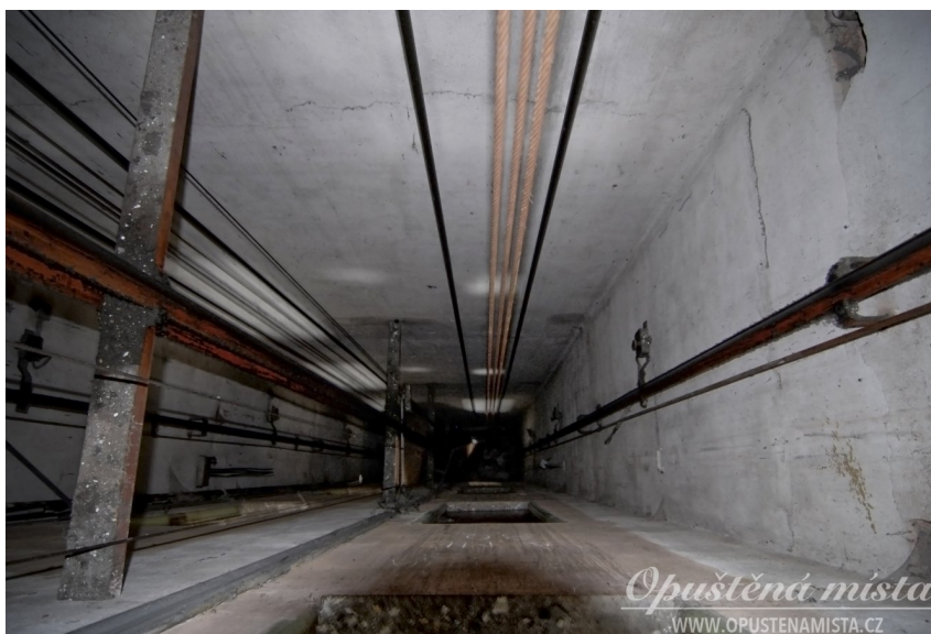
Obrázek číslo 1.35- Výtahová šachta [10]
