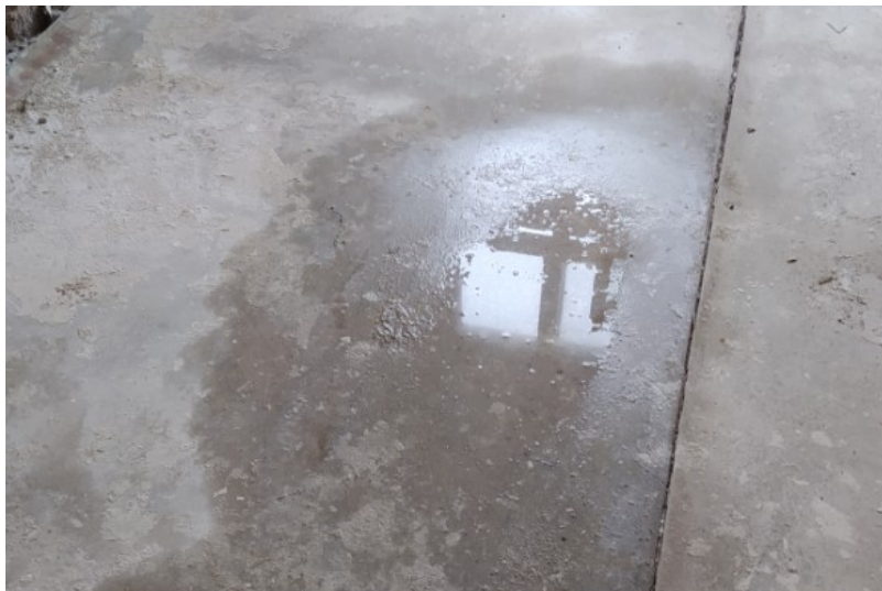
Obrázek číslo 1.69 – Louže vytvořená ve 4.NP hnanou srážkovou vodou
