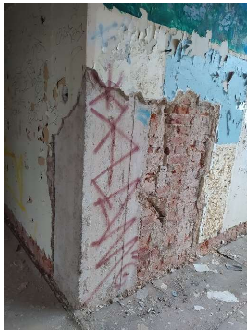
Obrázek číslo 1.10 – ŽB sloup a výplňové zdivo z CPP
