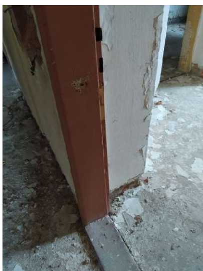
Obrázek číslo 1.41 – Ocel. Lisovaná zárubeň
