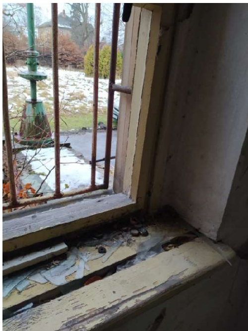
Obrázek číslo 1.43 – Okna ve starší části objektu
