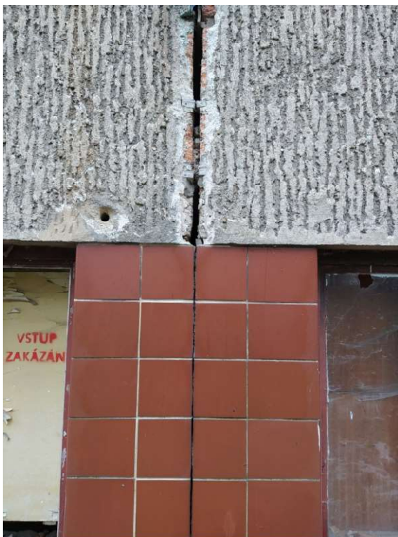
Obrázek číslo 1.47 – Přechod mezi strukturovanou omítkou a obkladem u dilatační spáry objektu
