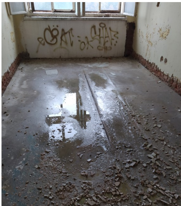
Obrázek číslo 1.64 – Louže tvořící se na podlaze při dešti
