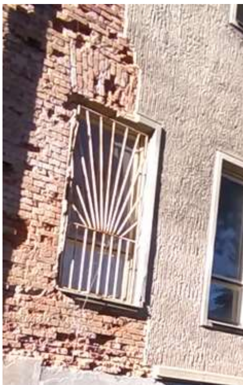
Obrázek číslo 1.24 – Cihelný překlad nad oknem ve starší části objektu
