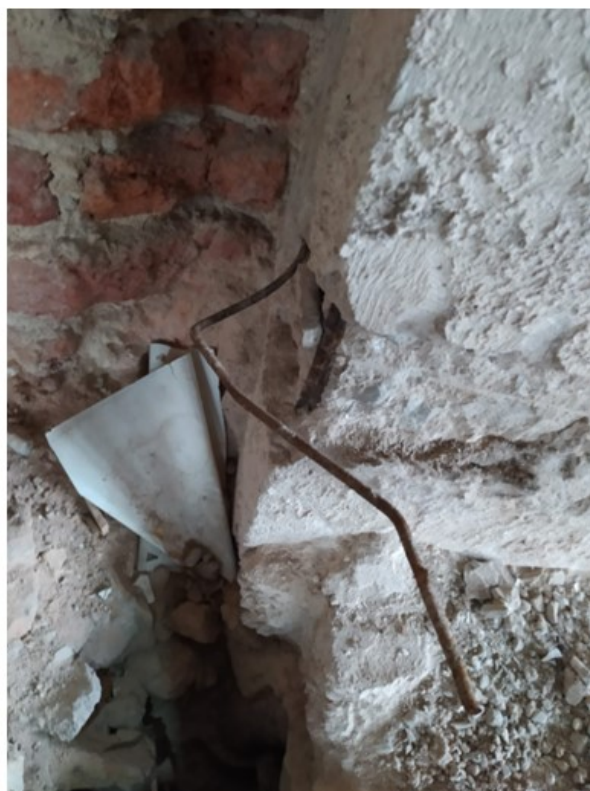
Obrázek číslo 1.63 – Odhalená výztuž u sloupu E18 v 1.PP
