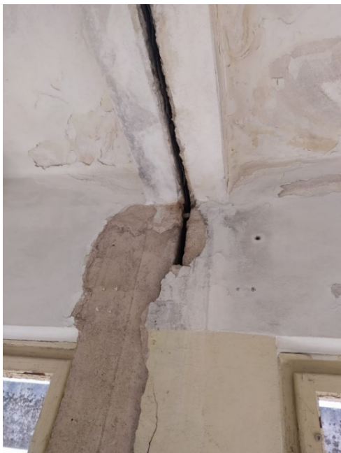
Obrázek číslo 1.36 – Dilatační spára (strop)
