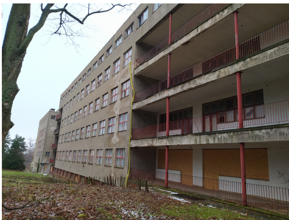
Obrázek číslo 1.8- Novější část objektu
