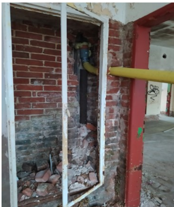
Obrázek číslo 1.66 – dočasné PVC potrubí odvádějící srážkovou vodu
