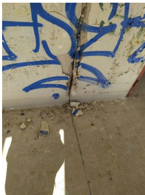
Obrázek číslo 1.37 – Dilatační spára
