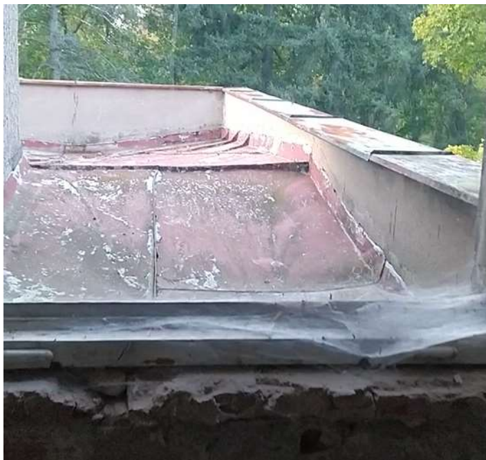
Obrázek číslo 1.26- Pohled na plechovou krytinu skrze okno ve 3.NP
