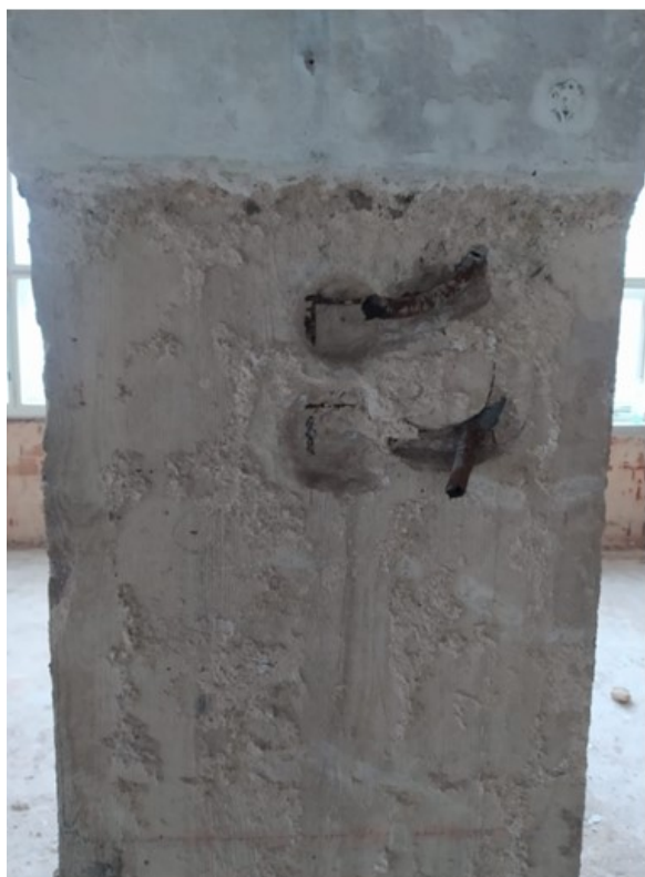
Obrázek číslo 1.62 – Odhalená výztuž u sloupu B17 v 1.PP
