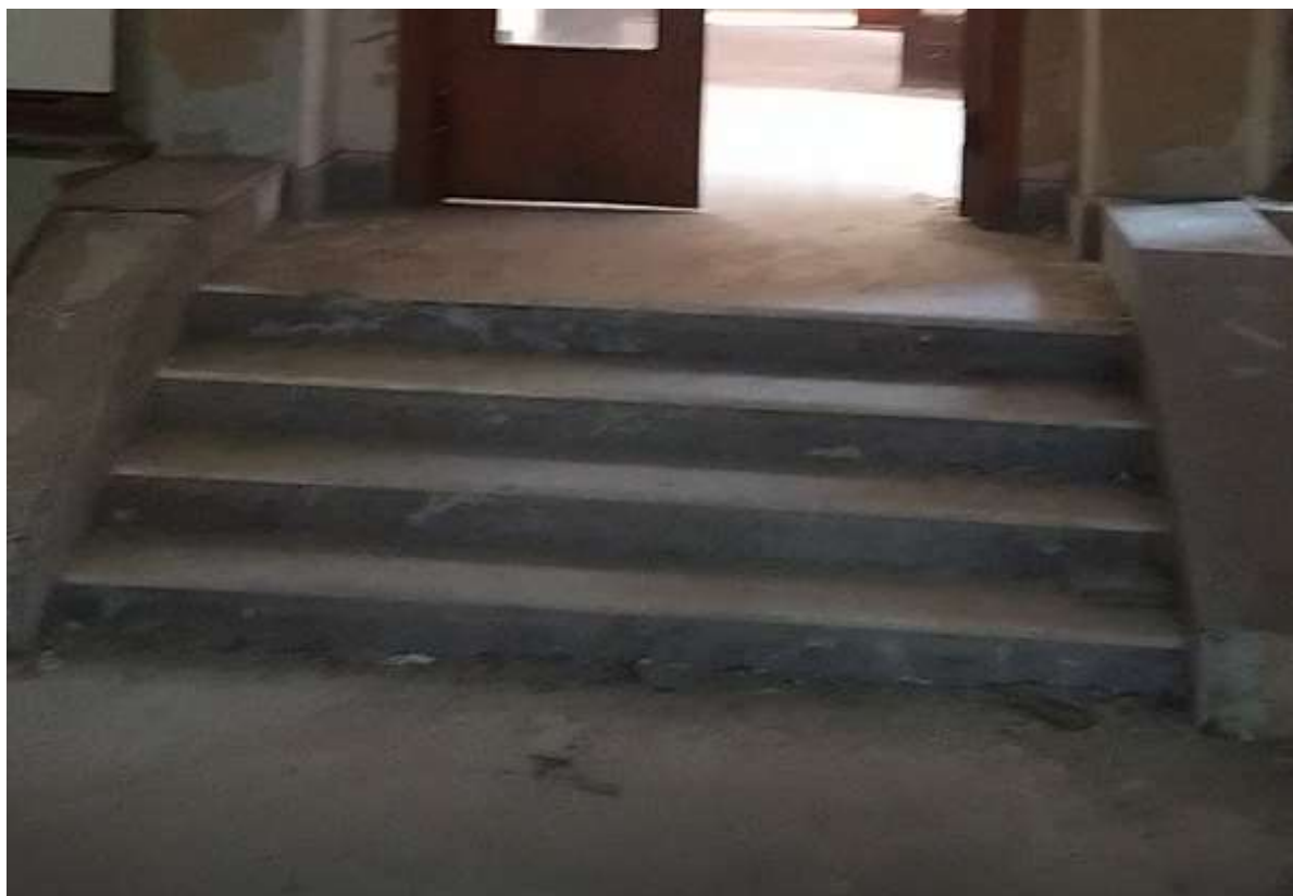
Obrázek číslo 1.33- Vyrovnávací vnitřní schodiště v 1.NP
