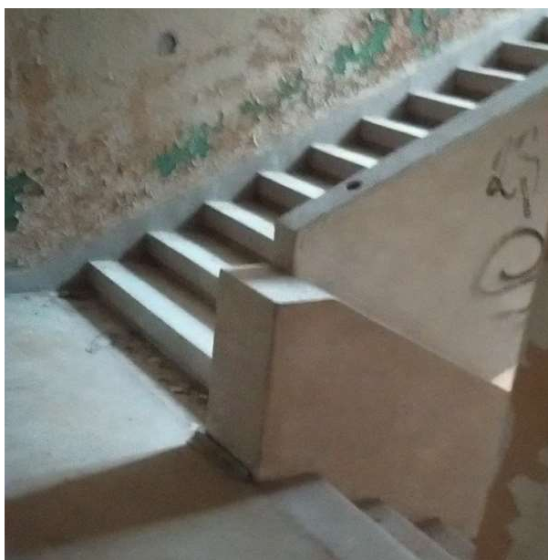
Obrázek číslo 1.30 – Hlavní schodiště v objektu
