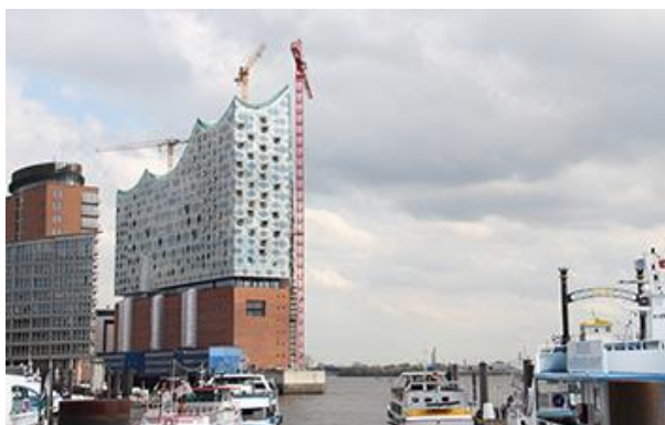
obr. /21/ Instalace kapilárních rohoží v Labské opeře v Hamburku [19]
