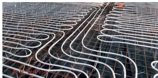
obr. /9/ Schéma stropního vytápění trubky zalité v betonu [15] obr. /10/ Montáž stropního vytápění [16]
