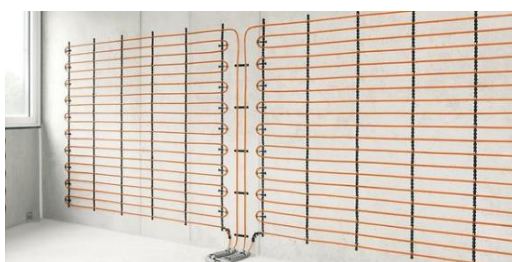
obr. /7/ Mokrý systém stěnového vytápění [13]
