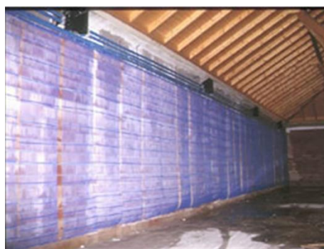
obr. /20/ Instalace kapilárních rohoží ve vinárně ve Španělsku [19]
