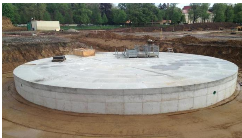
obr. 12: Podzemní nádrž SHZ [7]
