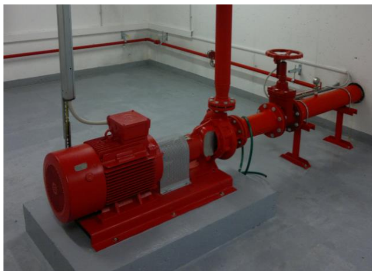
obr. 14: Sprinklerové čerpadlo s elektromotorem [6]
