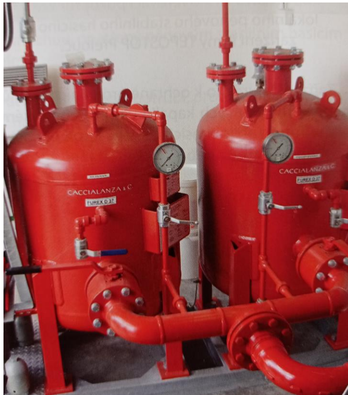
obr. 10: Zásobníky hasicího prášku ve strojovně práškového SHZ [4]
