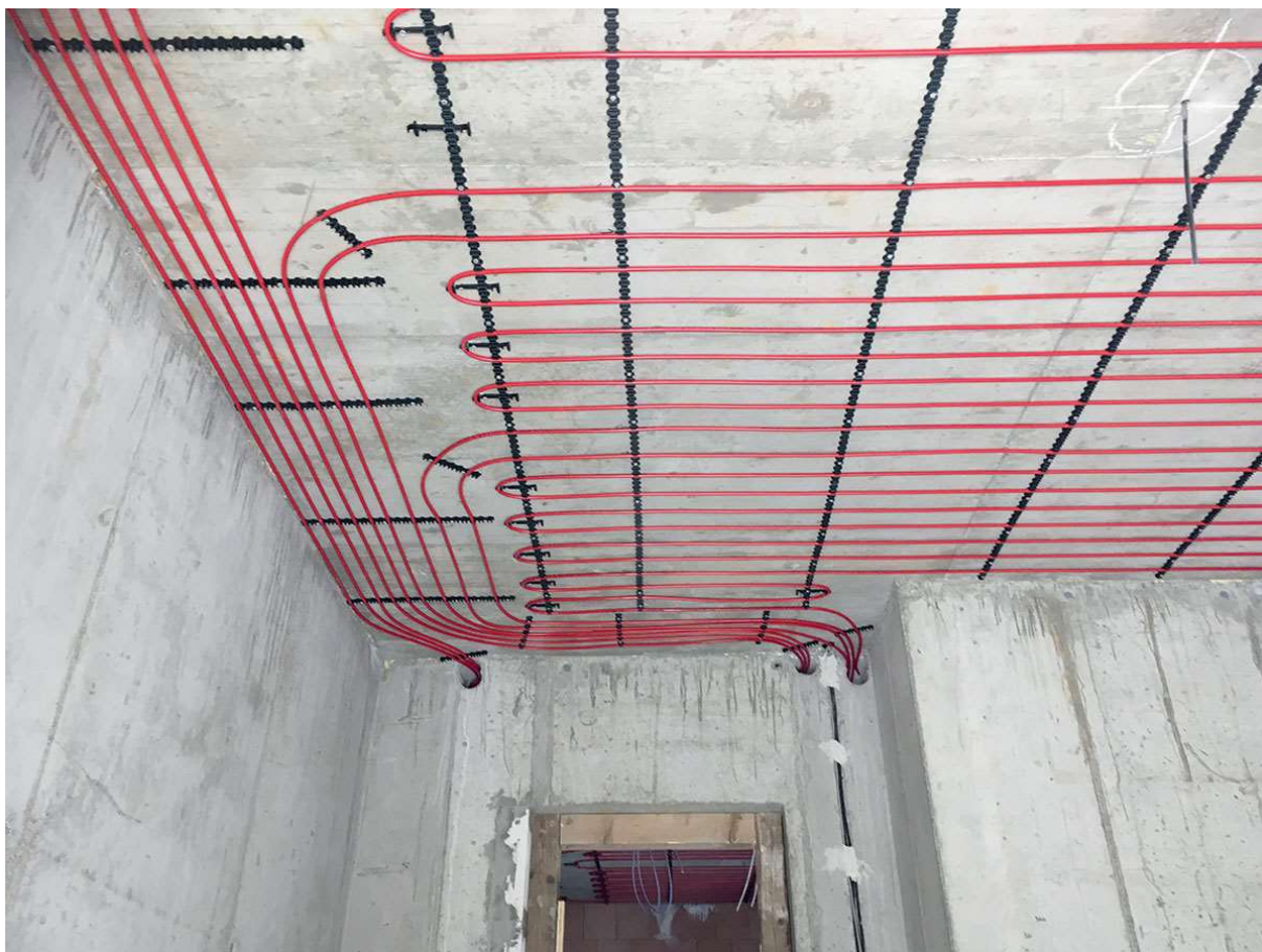
Obrázek 4 – Stropní vytápění (11)
