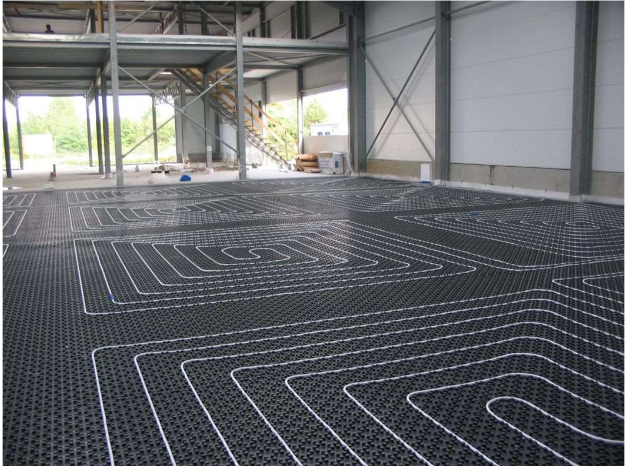
Obrázek 2 - Podlahové topení pro vyšší zatížení (9)
