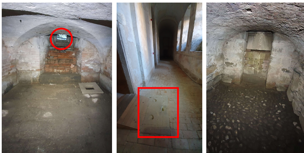
Obr. 10: Filtrační místnost s napouštěcím otvorem ve stěně (Jakub Řehák)
