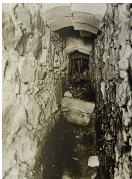
Obr. 17: Zborcené prampouchy ve vzdušníku (1972), (archiv kláštera Plasy)
