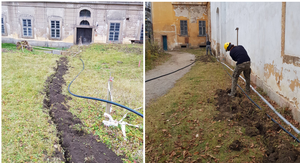
Obr. 22: Výkop provizorní rýhy pro uložení vodního potrubí (Josef Řehák)
