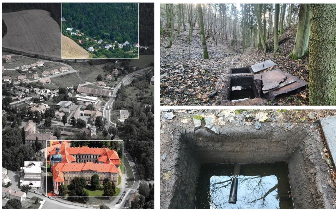
Obr. 06: Lokalizace místa jímání vody z potoka u Cihelny (foto: I. Kornatovský, Vyznačení: P. Duchoň)
