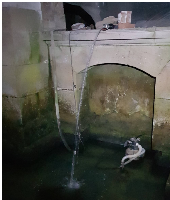
Obr. 24: Obnova přetlakového systému – nový provizorní přívod vody do severního kontrolního zrcadla (Josef Řehák)
