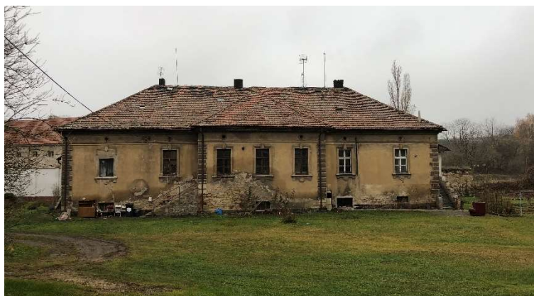
Obr. 6 – Východní pohled na řešený objekt z areálu statku
