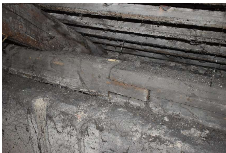
Obr. 21 – Prodloužení pozednice pomocí dvojitého rovného plátu
