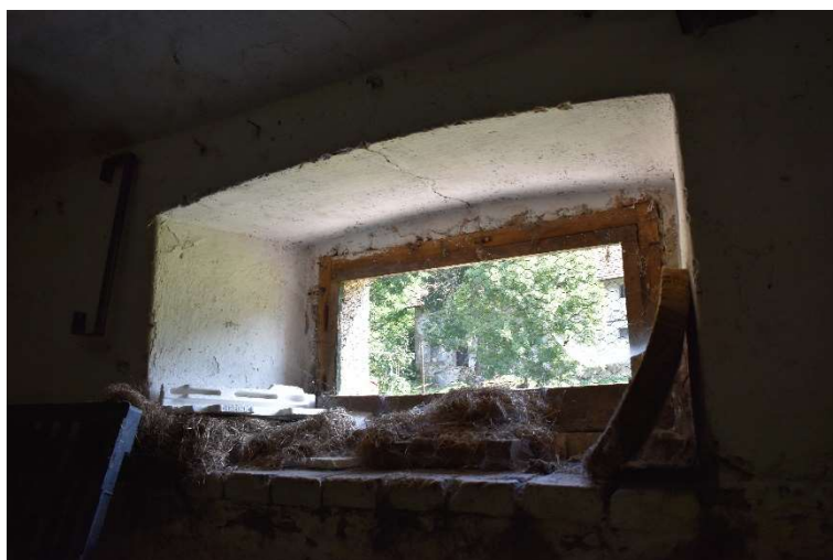
Obr. 26 – Výplň otvoru tvořená dřevěným rámem s pletivem
