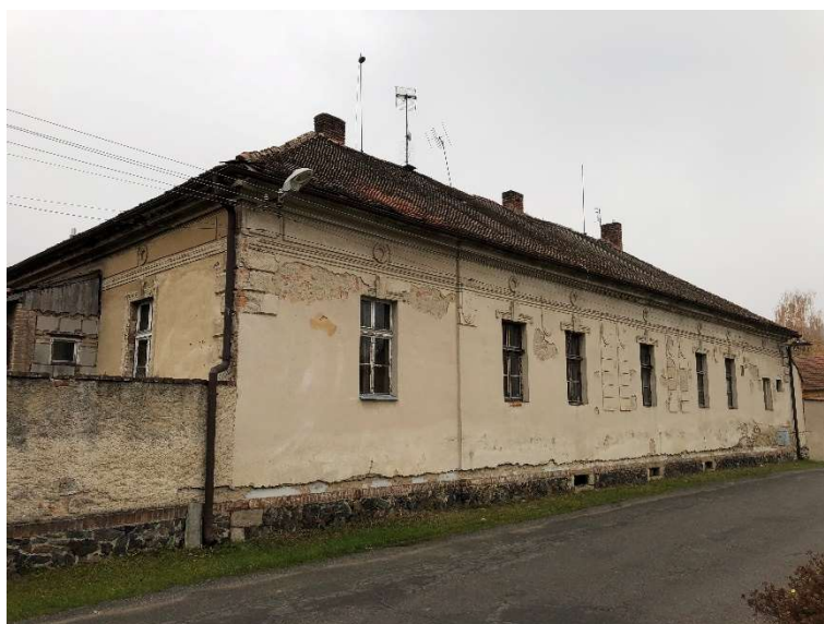
Obr. 4 – Severozápadní pohled na řešený objekt z přilehlé komunikace
