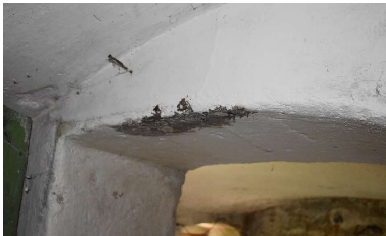
Obr. 38 – Místo napadené dřevokaznou houbou
