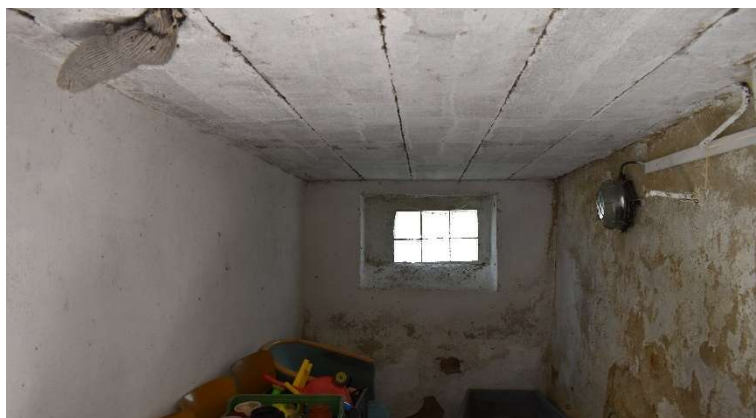
Obr. 15 – Stropní konstrukce sklepu jižního přístavku tvořená PZD panely
