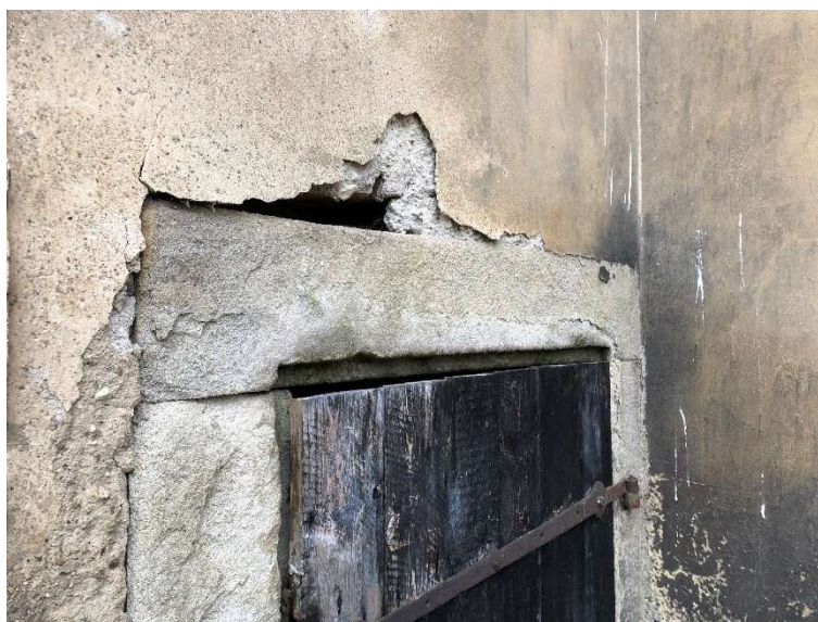
Obr. 54 – Degradace fasádní omítky nad dveřmi do sklepního prostoru
