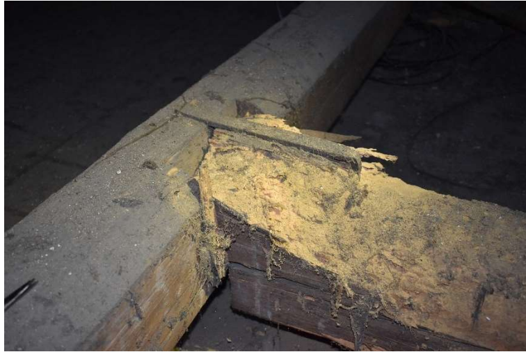
Obr. 43 – Poškození tesařského spoje vlivem působení biologických činitelů
