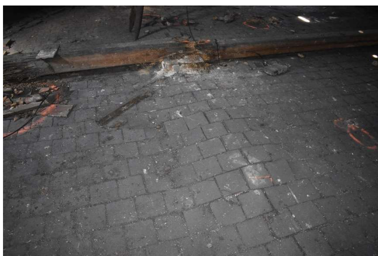
Obr. 50 – Vyboulená podlaha v půdním prostoru
