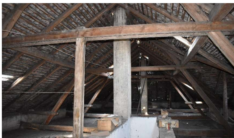
Obr. 19 – Pohled do půdního prostoru a na schodišťové stěny
