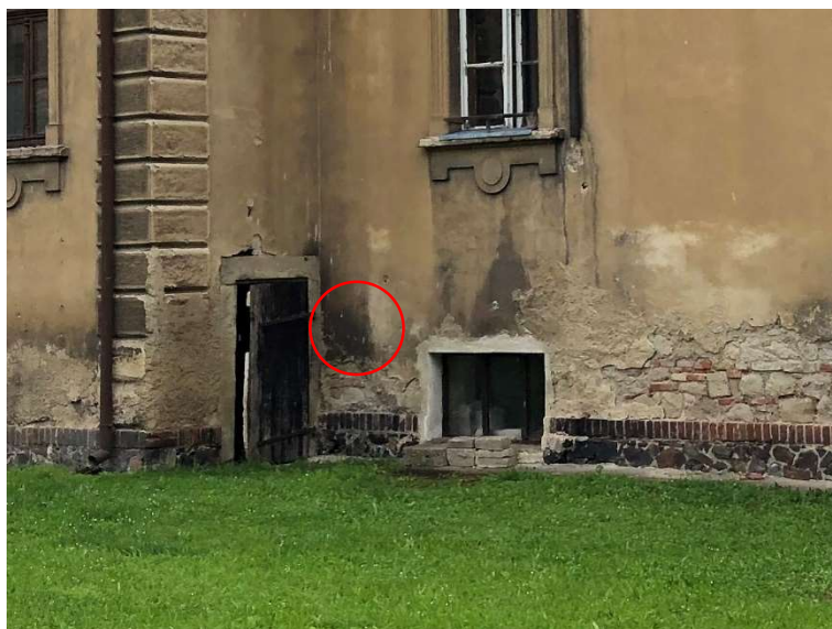
Obr. 66 – Označené místo odběru vzorku V3 na východní fasádě
