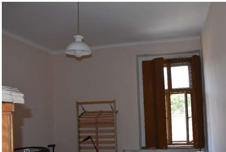
Obr. 16 – Pohled na stropní konstrukci v dětském pokoji v bytě č. 2
