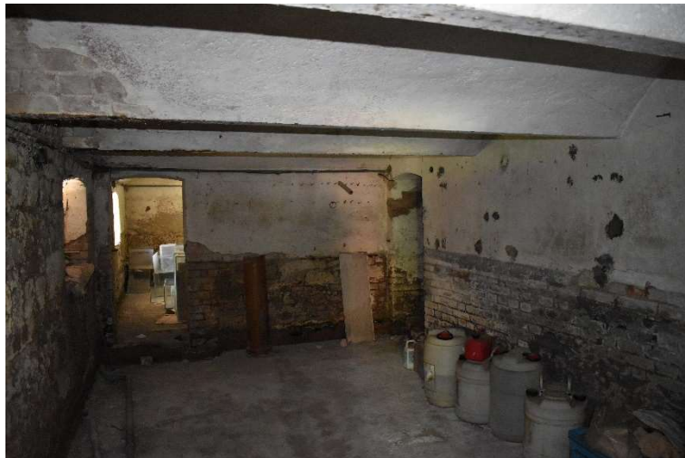
Obr. 14 – Valená klenba do ocelových nosníků ve sklepním prostoru
