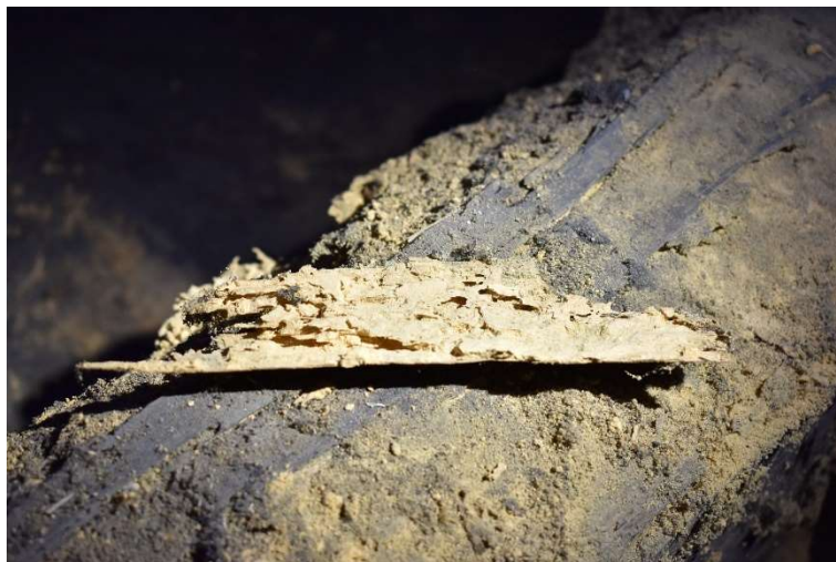
Obr. 87 – Úplný rozpad dřevní struktury značící výskyt tesaříka krovového
