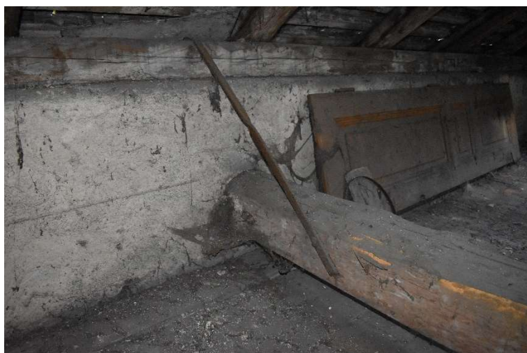
Obr. 22 – Ukotvení pozednice k vaznému trámu pomocí pásových kotev
