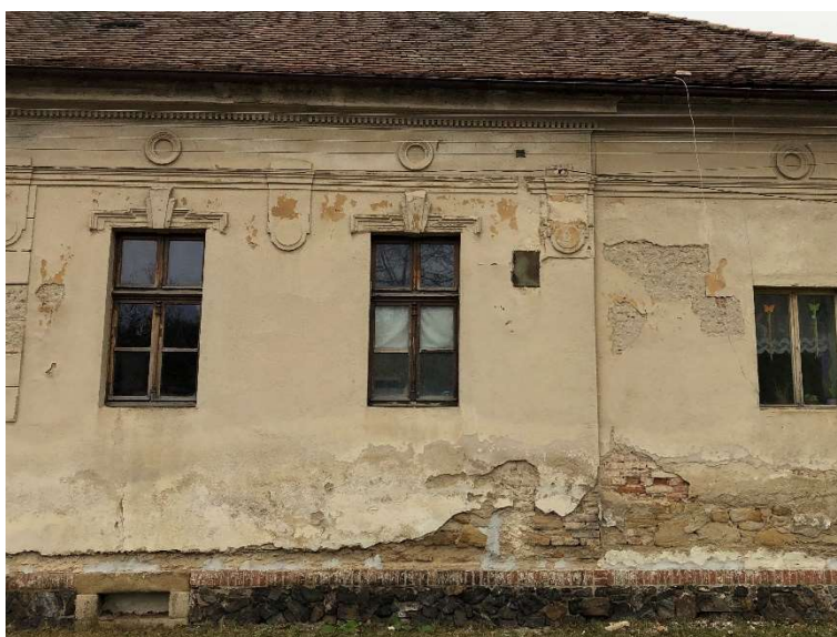
Obr. 28 – Pohled na část západní fasády se zdobnými plastickými prvky
