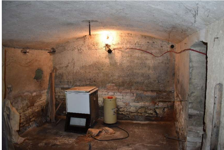
Obr. 13 – Valená klenba do nosných zdí ve sklepním prostoru
