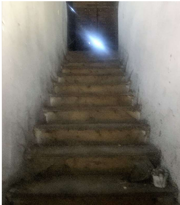
Obr. 18 – Pohled na část dřevěného schodiště sloužícího pro vstup do podkroví
