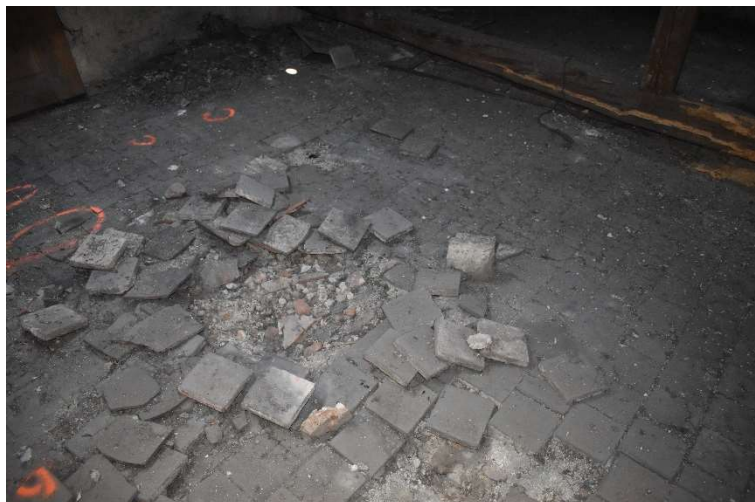
Obr. 25 – Část rozebrané podlahy v půdním prostoru
