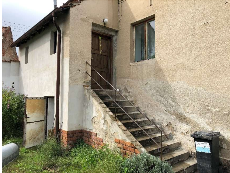
Obr. 17 – Venkovní schodiště sloužící pro vstup do bytu č. 1
