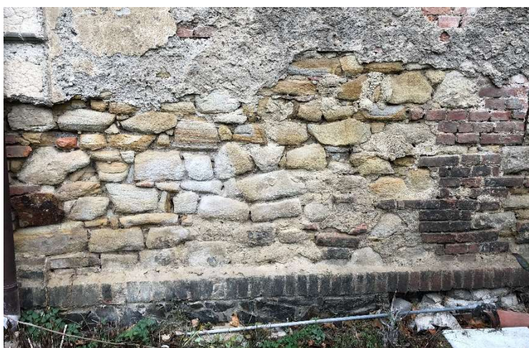
Obr. 12 – Obnažené smíšené zdivo východní fasády objektu
