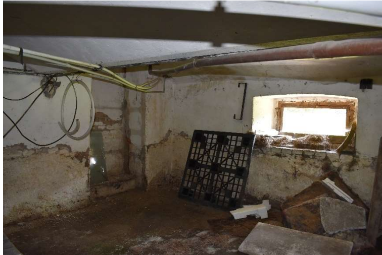
Obr. 29 – Obnažené povrchy stěn ve sklepích do výšky parapetu cca 800 mm
