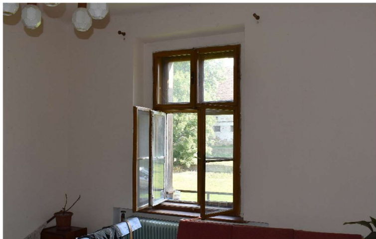
Obr. 27 – Špaletové okno v obývacím pokoji bytu č. 3
