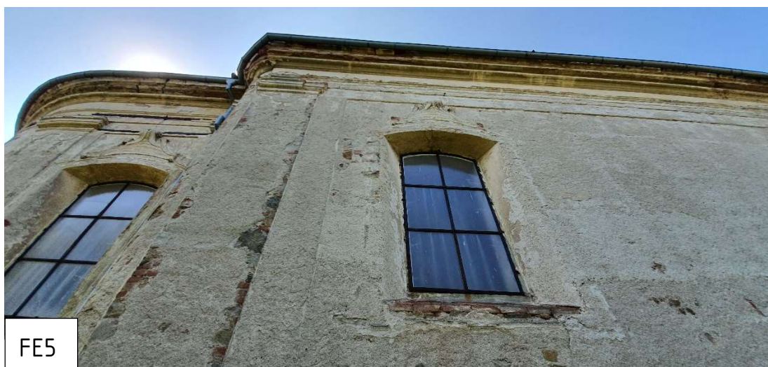
F.5 - Pohled na okno podélné stěny (levé - blíže k presbytáři)
