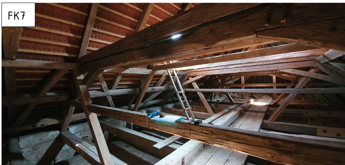
F.47 - Hlavní vazba s viditelným podélným ztužením
