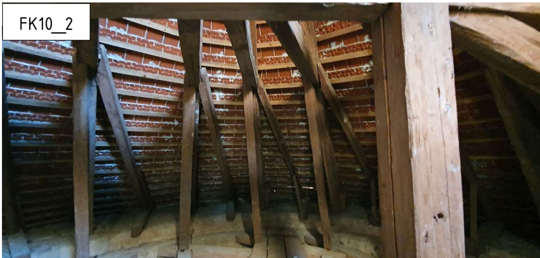
F.53 - Obloukově přeplátované krokve a vzpěry začepované do vzpěry hlavní vazby vynášející klenby presbytáře
