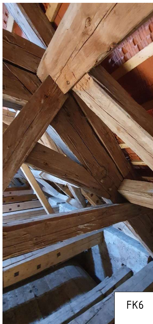
F.44, F.45 - Uložení stropních trámů, Styčnick hlavní vazby ležaté stolice
