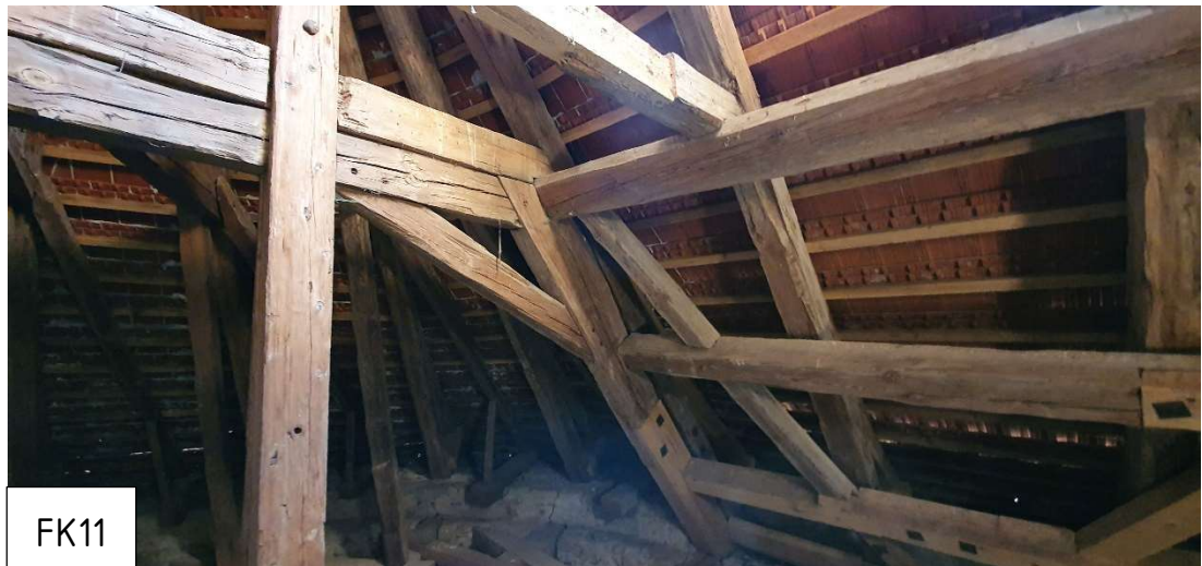
F.54 - Styčník hlavní vazby vynášející klenby presbytáře s věšadlovými sloupky
