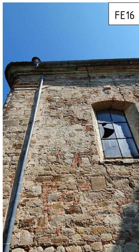
F.17, F.18 - Pohled na zadržný vstup v podélné pravé stěně, pohled na pravou podélnou stěnu (nefunkční okapový svod)
