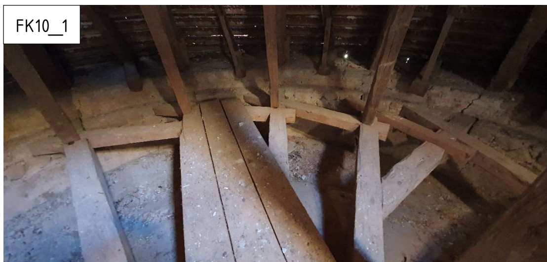
F.52 - Obloukově začepované vazné trámky a vazného trámku hlavní vazby vynášející klenby presbytáře
