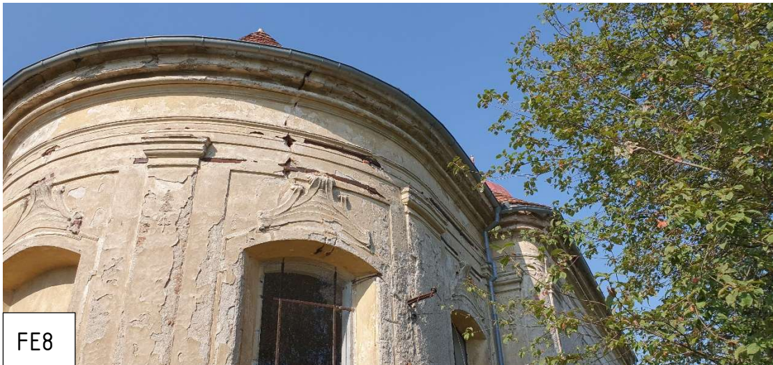
F.8 - Bližší pohled na vnější část presbytáře, viditelné ocelové opásání
