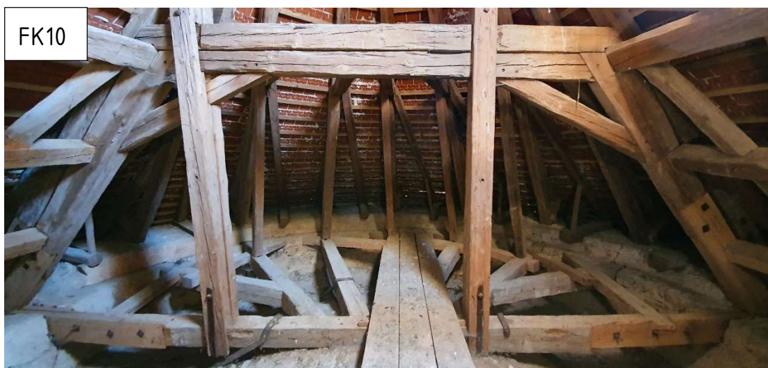
F.49 - Hlavní vazba vynášející klenbu v presbytáři
