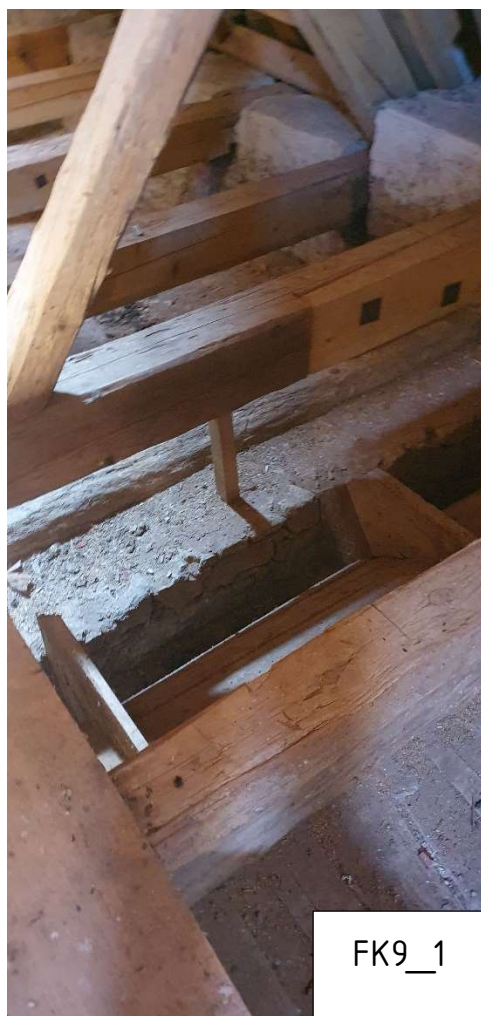
F.50, 51 - Podepření vazných trámů nad vítězným obloukem
