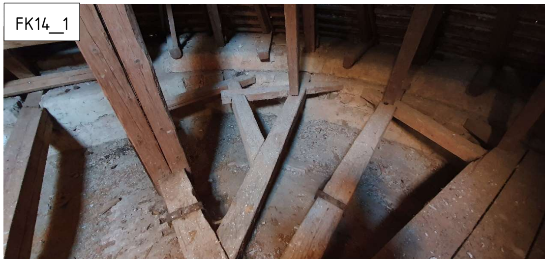
F.60 - Táhla v půlkruhové části vynášející klenbu půl-vrchlíku nad presbytářem
