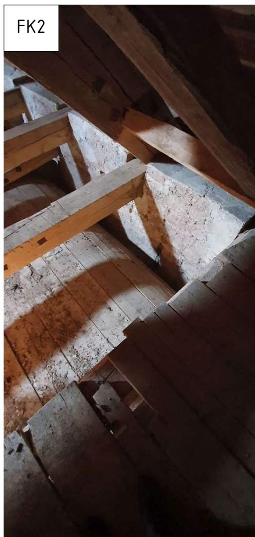
F.44, F.45 - Uložení stropních trámů, Styčnick hlavní vazby ležaté stolice
