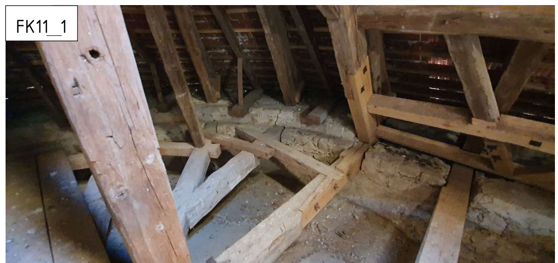
F.55 - Obloukově začepované vazné trámky a vazného trámku hlavní vazby vynášející klenby presbytáře
