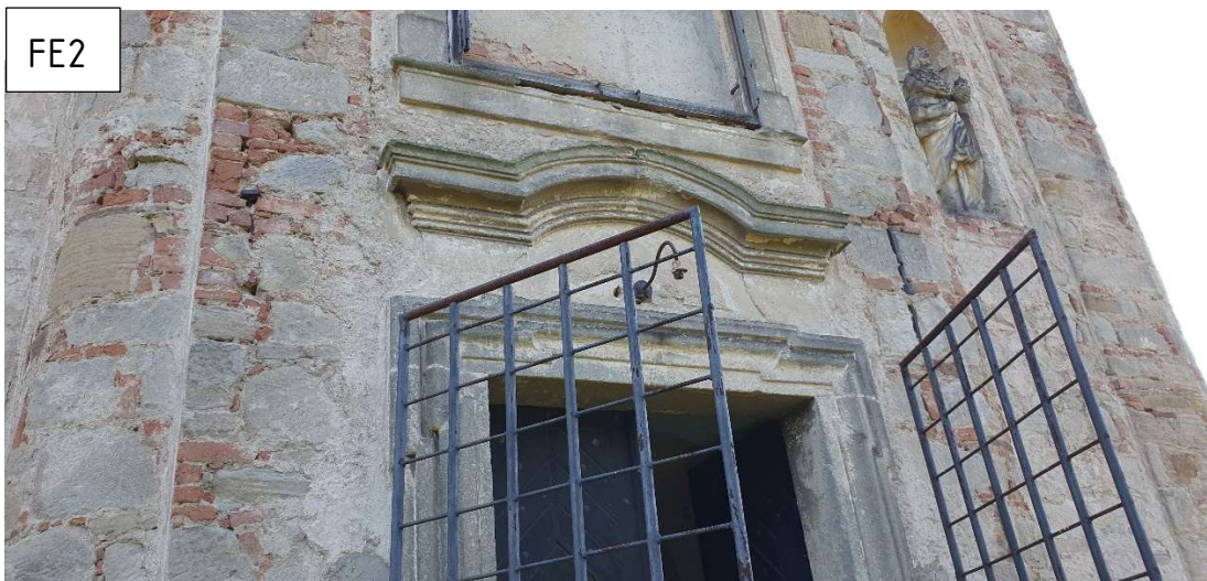
F.4 - Detail ozdobné římsy nad hlavním vstupem, detail zedních kleští
