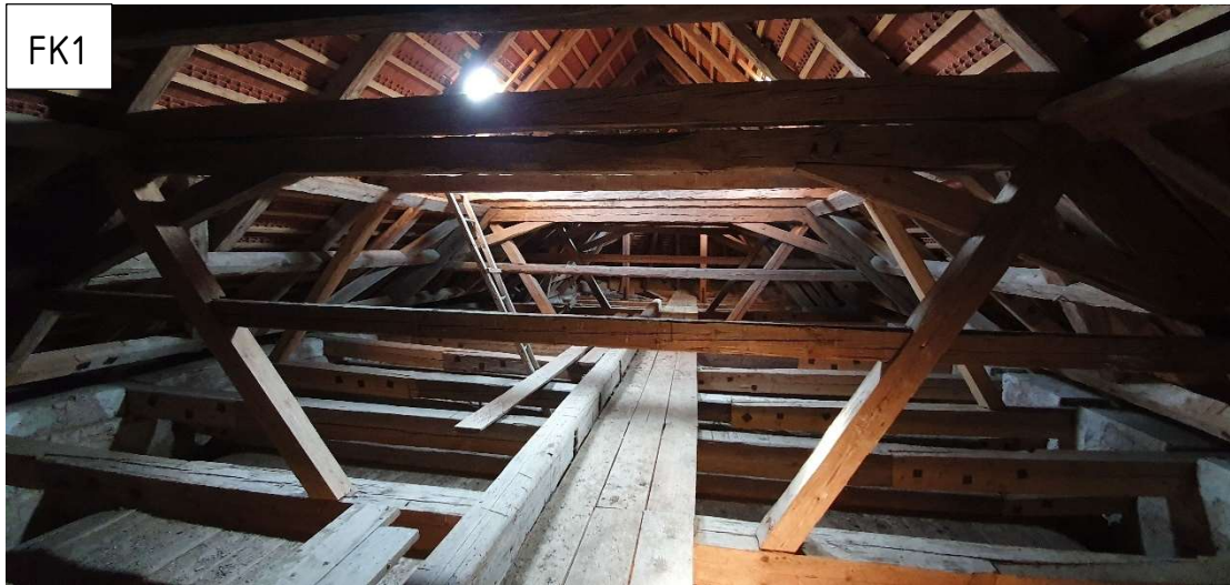
F.41 - Pohled na hlavní vazbu - směr od vstupu k presbytáři
