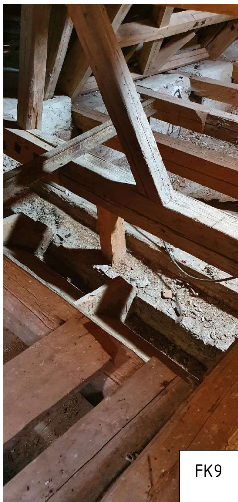
F.50, 51 - Podepření vazných trámů nad vítězným obloukem
