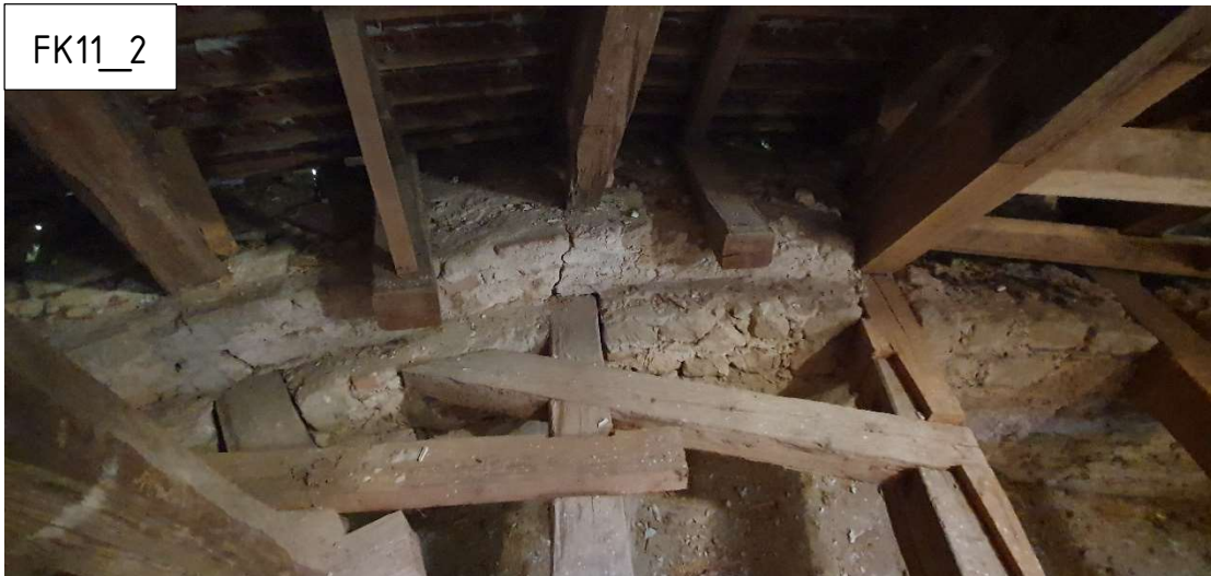
F.56 - Ztužení radiálních trámů pomocí přeplátovaných trámečků
