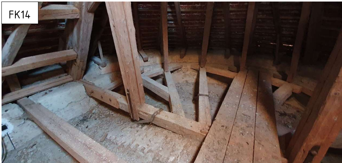
F.59 - Detail vynášecího táhla klenby a tahový spoj věšadel, které vynášejí vazný trám
