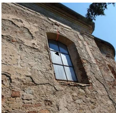
Obrázek 65 - Trhlina na pravém oknem při vstupu do kněžiště - vlastní foto
