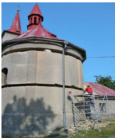
Obrázek 189 - Spínání presbytáře kabely MONOSTRAND - kostel sv. Petra a Pavla v Horních Dubňanech [37]
