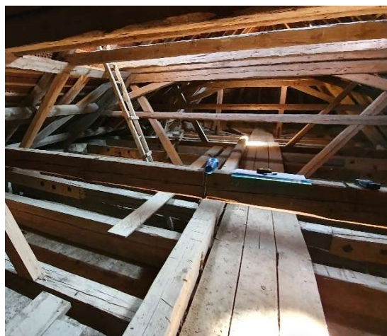
Obrázek 34 - Podélný vazný trám vynášející rákosníky - vlastní foto
