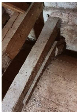
Obrázek 35 - Detail ramenátu tvořící zrcadlový přechod - vlastní foto
