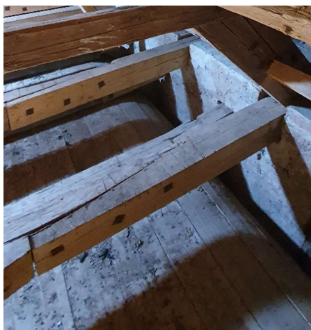
Obrázek 33 - Dřevěné bednění tvořící stropní zrcadlo - vlastní foto
