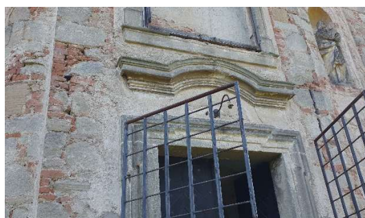
Obrázek 45 - Zední kleště na přední fasádě (levé chybí závlače) - vlastní foto
