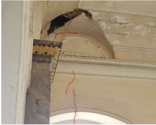
Obrázek 56 - Trhliny nad levým oknem od vstupu a odtržená falešná luneta - vlastní foto
