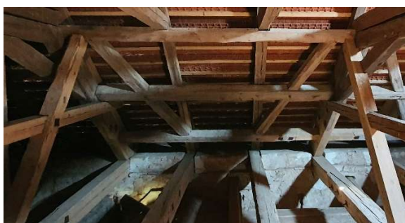
Obrázek 44 - Podélné ztužení střešní konstrukce - vlastní foto
