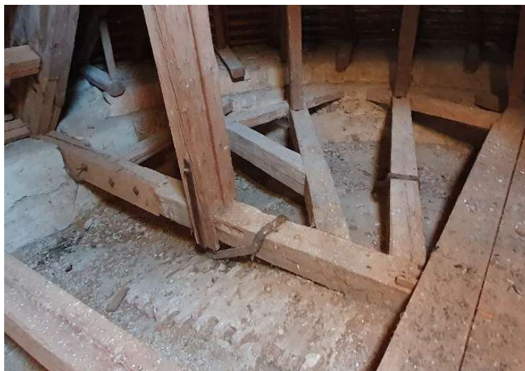
Obrázek 85 - Systém táhel vynášející zděné klenby - vlastní foto
