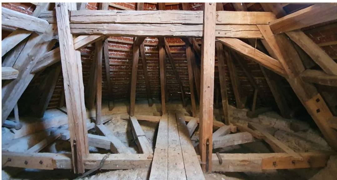
Obrázek 42 - Hlavní vazba přílbovité části - vlastní foto
