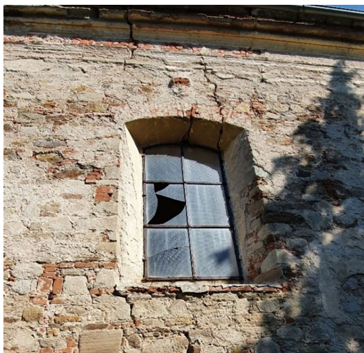
Obrázek 50 - Klenební překlád - vlastní foto
