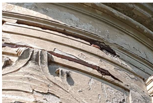
Obrázek 47 - Ocelové opásání - římsa kněžiště - detail - vlastní foto
