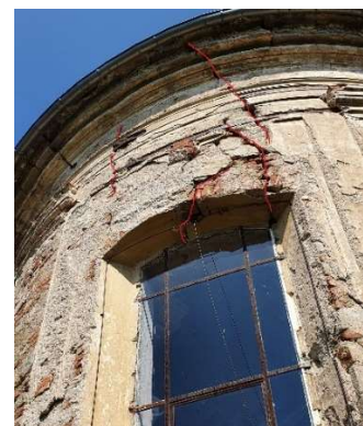
Obrázek 71 - Vnější část utržené lunety - vlastní foto
