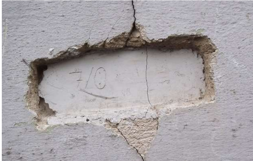
Obrázek 188 - Příklad sádrového pásku pro kontrolu trhliny [33]
