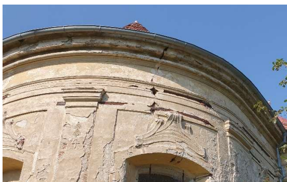
Obrázek 46 - Ocelové opásání - římsa kněžiště - pohled - vlastní foto
