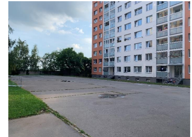
Obrázek 61 - vybetonované rezidenční VP
