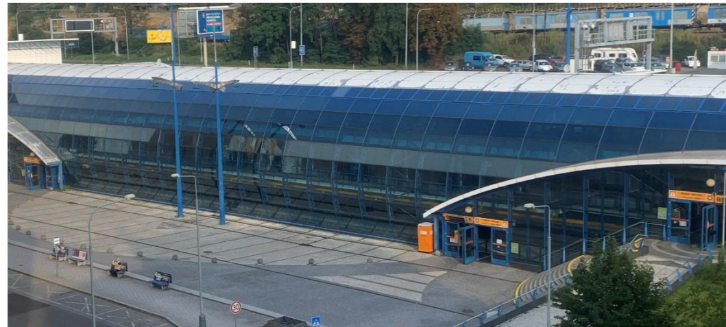
Obrázek 42 - stanice metra Rajská zahrada
