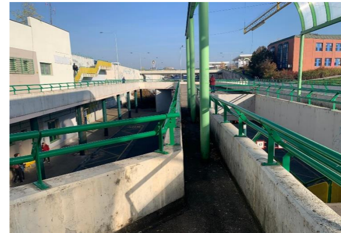
Obrázek 43 - terminál Černý Most současný stav I
