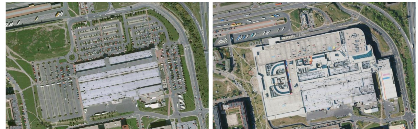
Obrázek 16 – OC Černý Most před rekonstrukcí [13]
