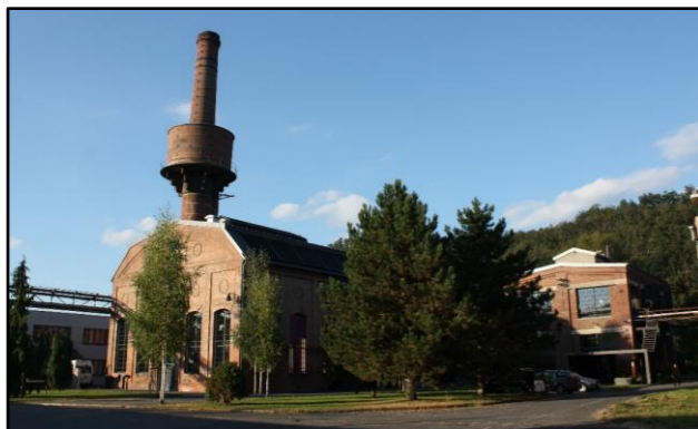
Obr. 43: Kotelna a Uhelny mlýn
