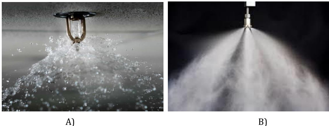
Obrázek 22: Aktivovaná hlavice: A) sprinkler; B) vodní mlha [21]
