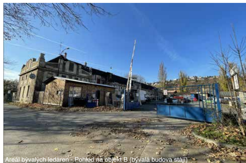
Areál bývalých ledáren - Pohled na objekt B (bývalá budova stájí)
