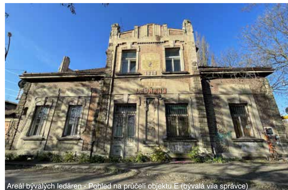
Areál bývalých ledáren - Pohled na průčelí objektu E (bývalá vila správce)
