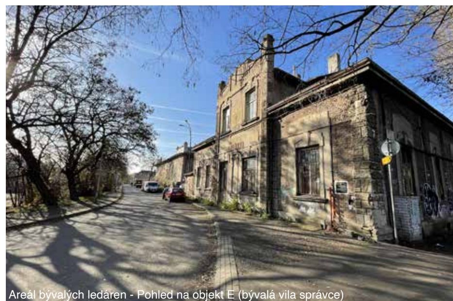
Areál bývalých ledáren - Pohled na objekt E (bývalá vila správce)
