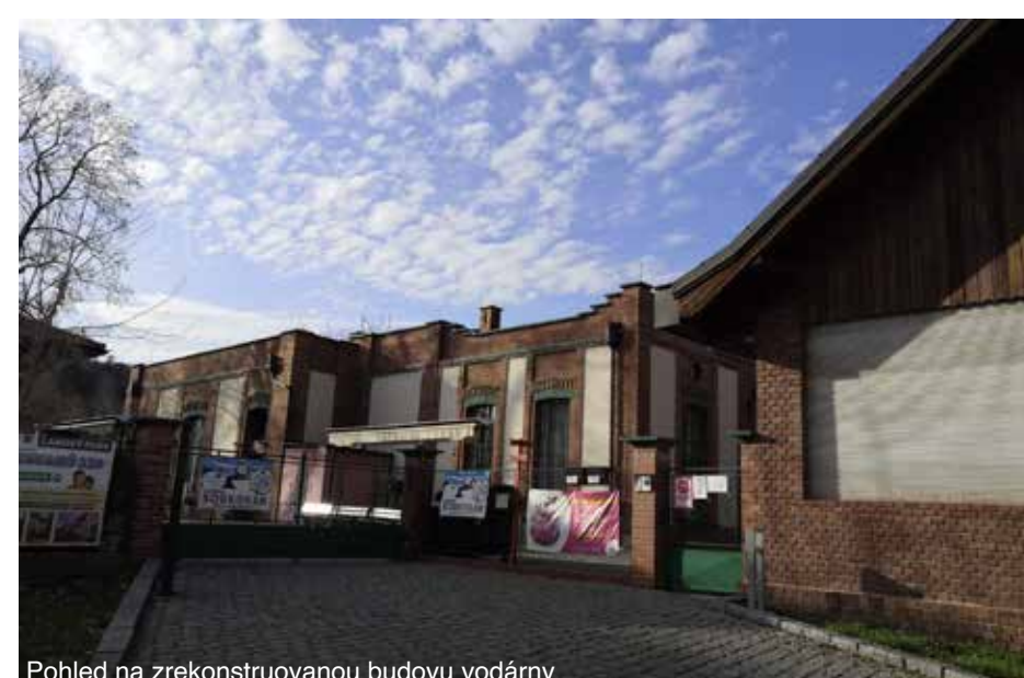
Pohled na zrekonstruovanou budovu vodárny
