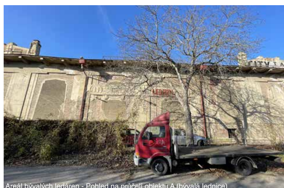
Areál bývalých ledáren - Pohled na průčelí objektu A (bývalá lednice)
