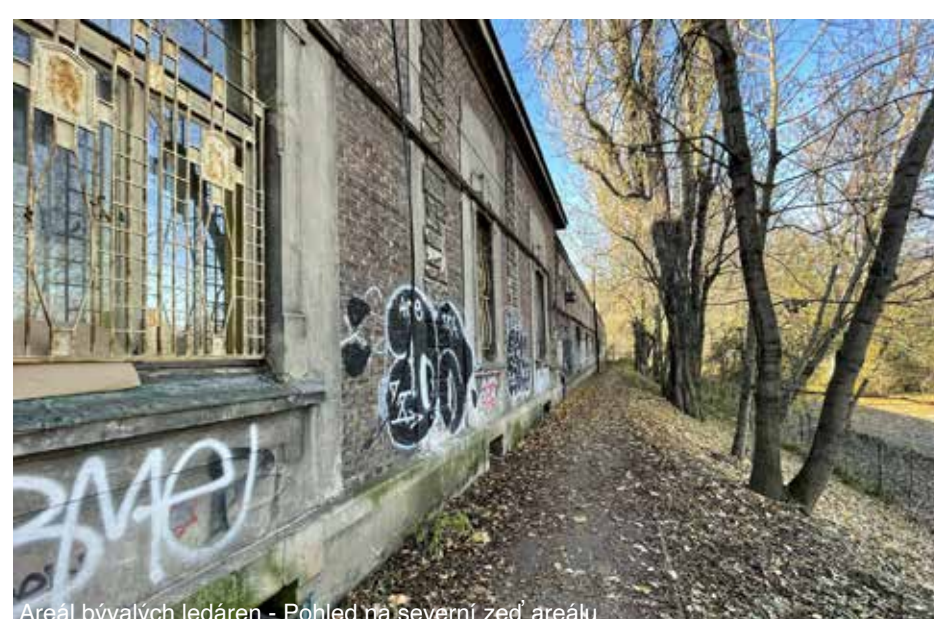
Areál bývalých ledáren - Pohled na severní zeď areálu
