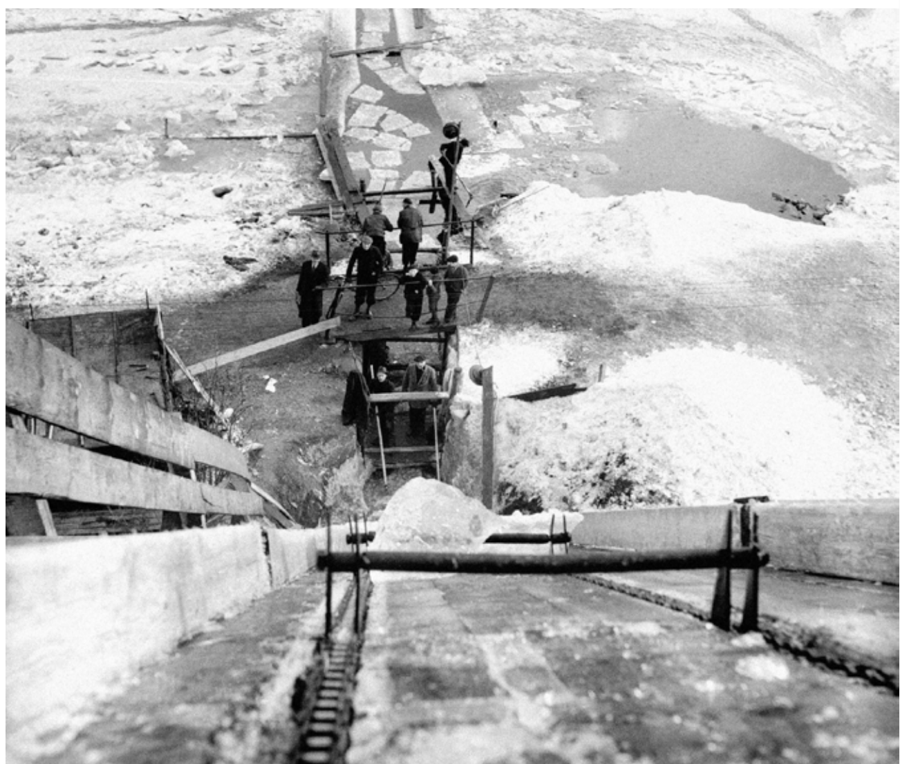
[obráz. 7] Fragments ledu byly přiváženy speciálními dopravníky až do útrobu budovy ledárny. Fotografie z roku 1937.
