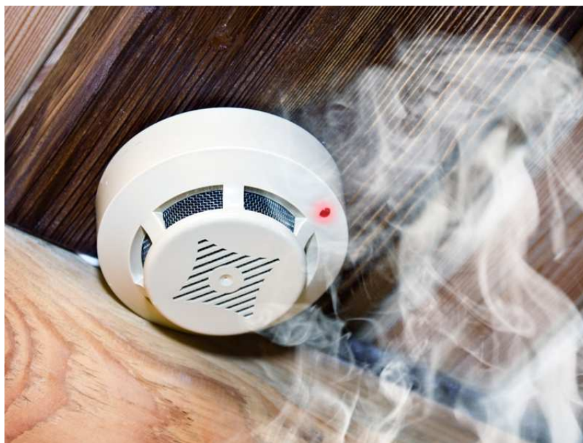
Obr. 4: Samočinný hlásič na dřevěném stropě [7]
