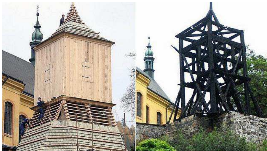
Obr. 33: Železnobrodská zvonice během rekonstrukce a po požáru [43]
