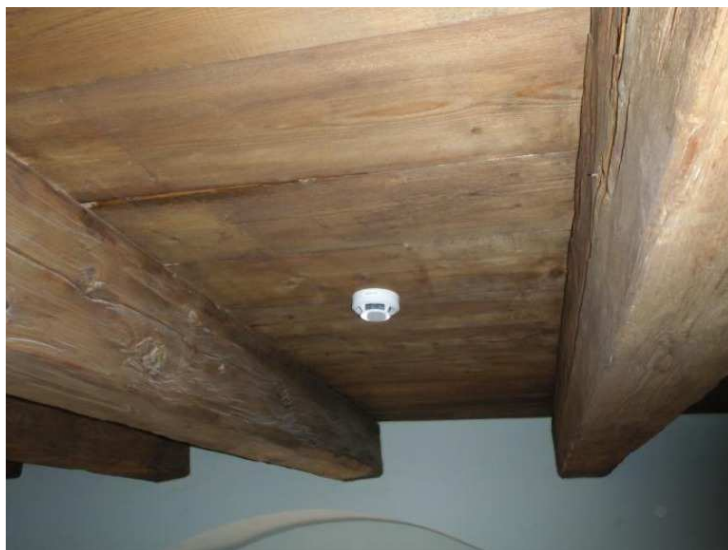
Obr. 11: Samočinný hlásič na dřevěném stropě [14]
