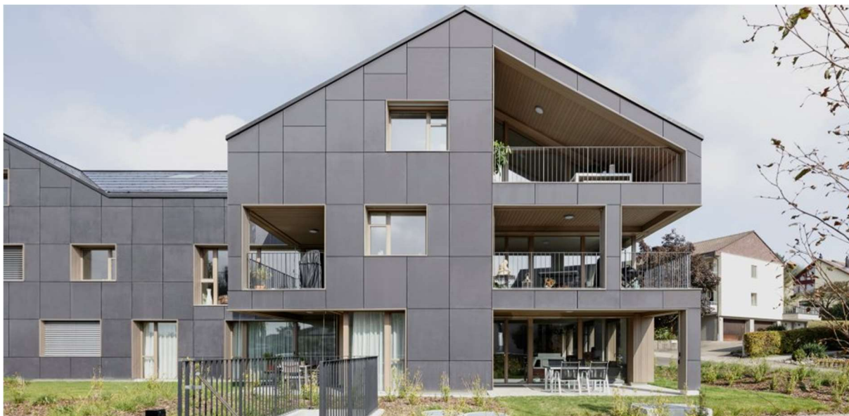
Obrázek 33: Pohled na fasádu ze solárních panelů na soběstačném domě [6]
