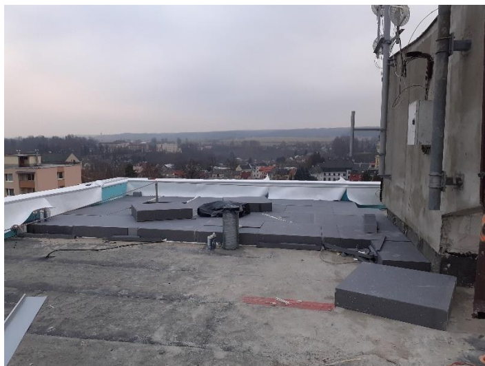
OBRÁZEK Č. 51 – POKLÁDKA TEPELNÉ IZOLACE
