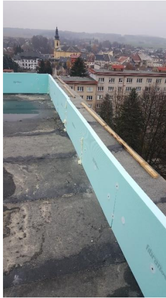
OBRÁZEK Č. 49 – ZATEPLENÍ ATIKY
