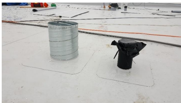
OBRÁZEK Č. 56 - NAPOJENÍ FOLIE U PROSTUPŮ
