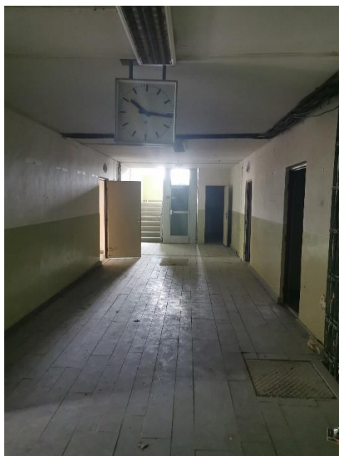
OBRÁZEK Č. 11 – PŮVODNÍ PODLAHA PŘILEHLÁ K ZEMINĚ
