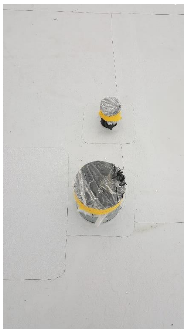
OBRÁZEK Č. 55 – NAPOJENÍ FOLIE U PROSTUPŮ
