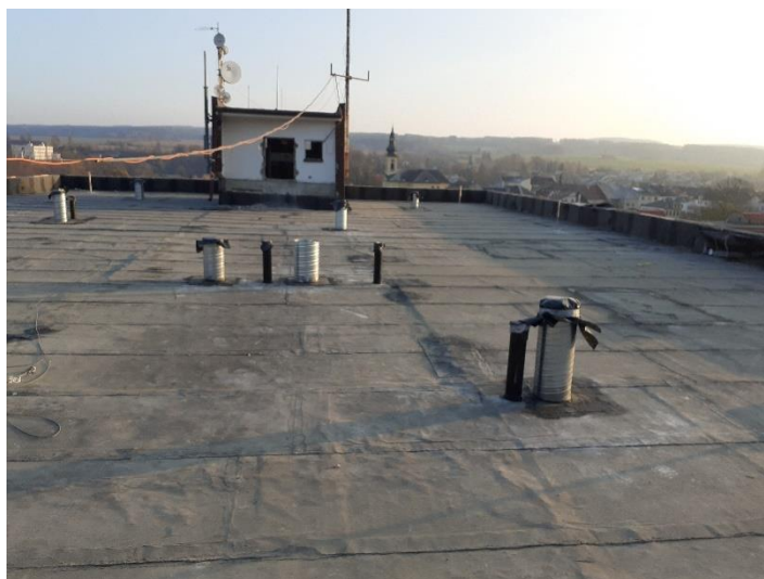
OBRÁZEK Č. 46 – BOURACÍ PRÁCE
