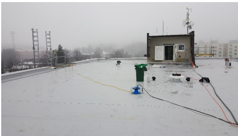
OBRÁZEK Č. 54 – HLAVNÍ HYDROIZOLACE
