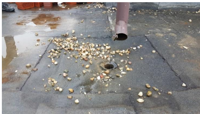
OBRÁZEK Č. 14 – STÁVAJÍCÍ STŘEŠNÍ VPUŠŤ
