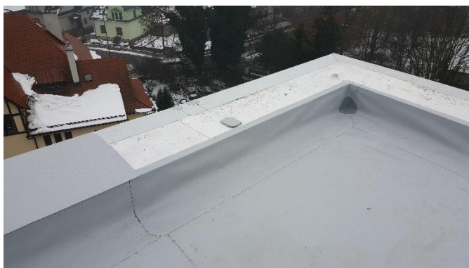
OBRÁZEK Č. 59 – NAPOJENÍ FOLIE NA ATIKU
