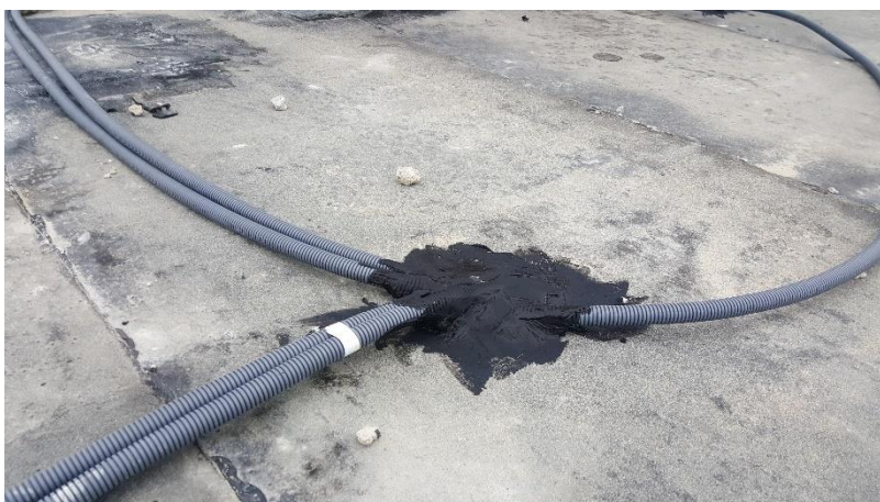
OBRÁZEK Č. 48 – UTĚSNĚNÍ PROSTUPŮ VEDENÍ
