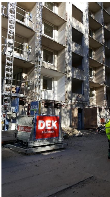
OBRÁZEK Č. 39 - STAVEBNÍ VÝTAH GEDA 1500 Z/ZP
