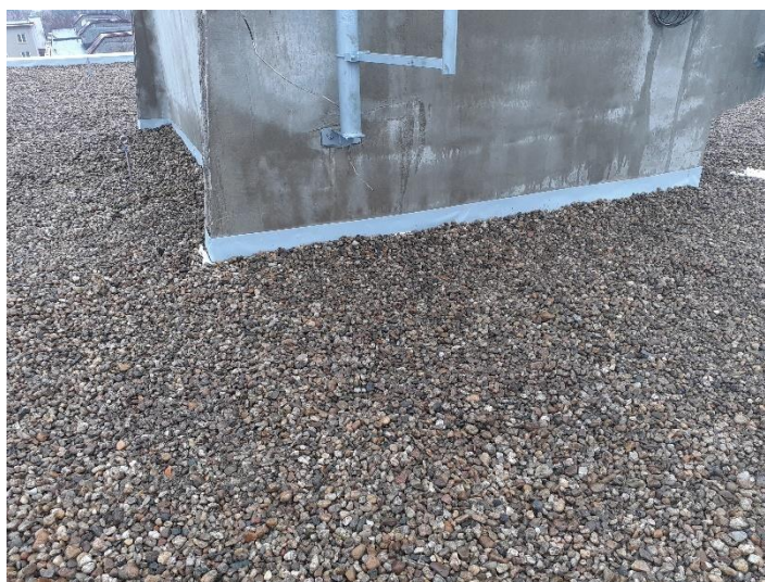
OBRÁZEK Č. 60 – STABILIZAČNÍ VRSTVA KAČÍRKU
