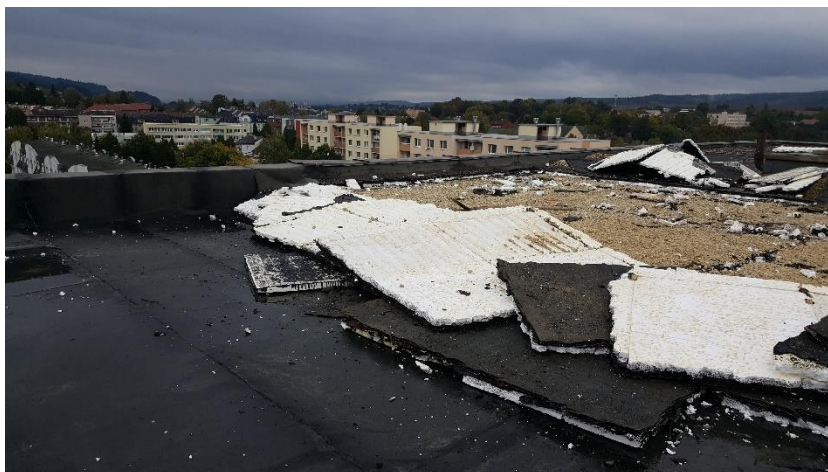
OBRÁZEK Č. 45 – BOURACÍ PRÁCE
