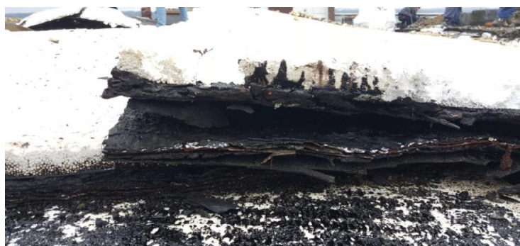
OBRÁZEK Č. 12 – DETAIL STÁVAJÍCÍ STŘEŠNÍ SKLADBY
