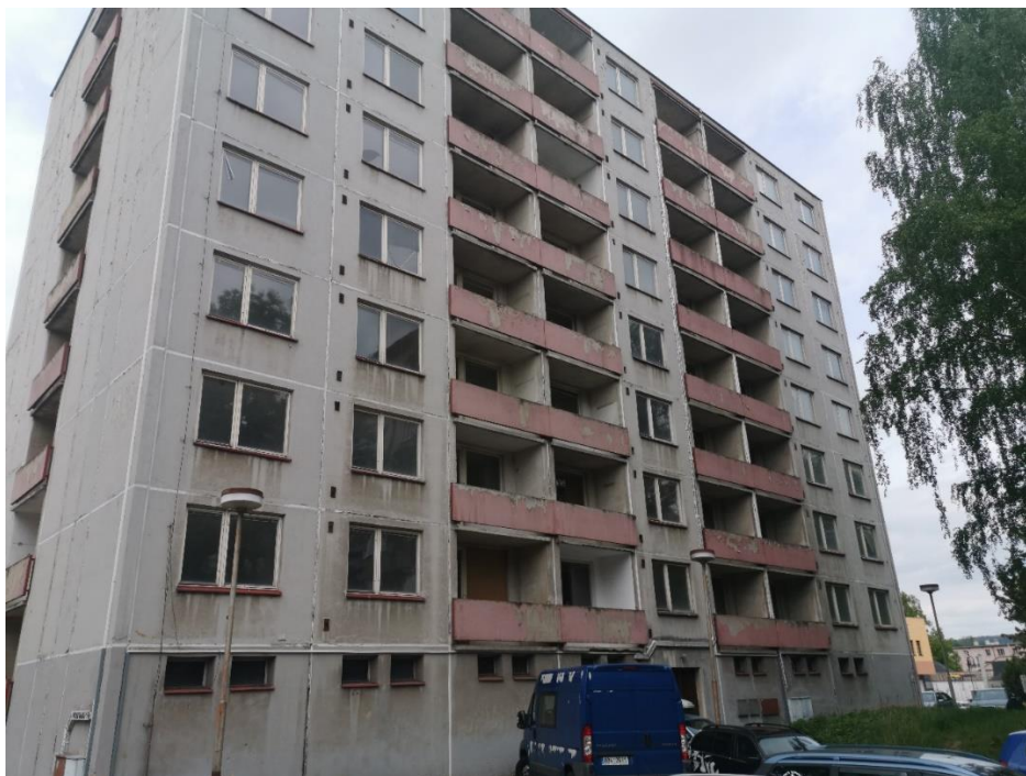
OBRÁZEK Č. 5 – PŮVODNÍ STAV BUDOVA
