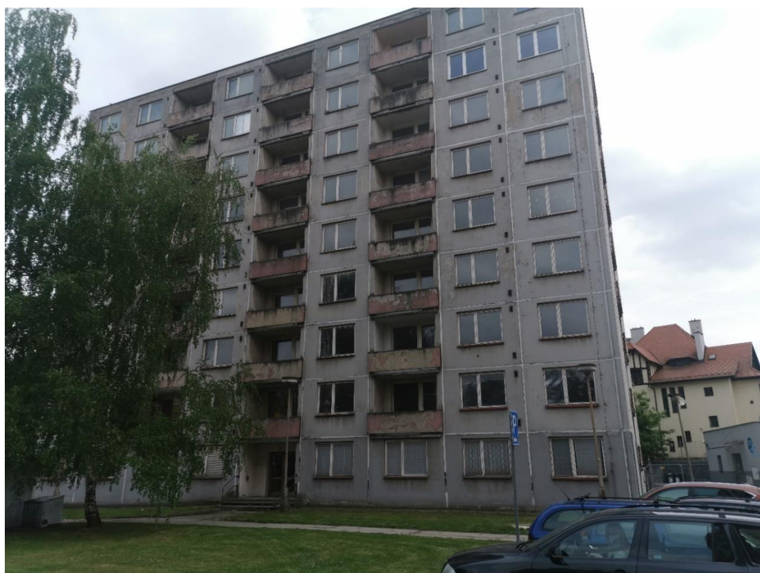
OBRÁZEK Č. 6 – PŮVODNÍ STAV BUDOVA
