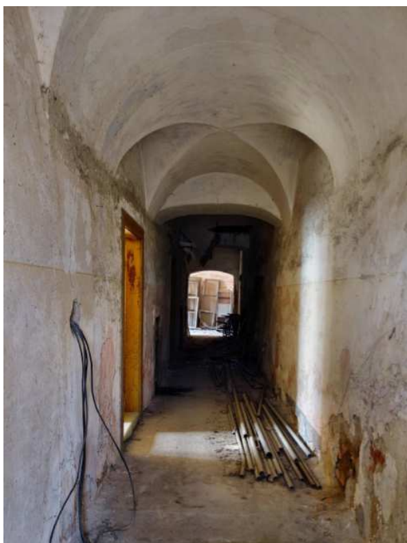
Obr. 11 (vlevo) – Pohled do chodby č. 1.02 směrem k západu – valená klenba s výsečemi [5]
