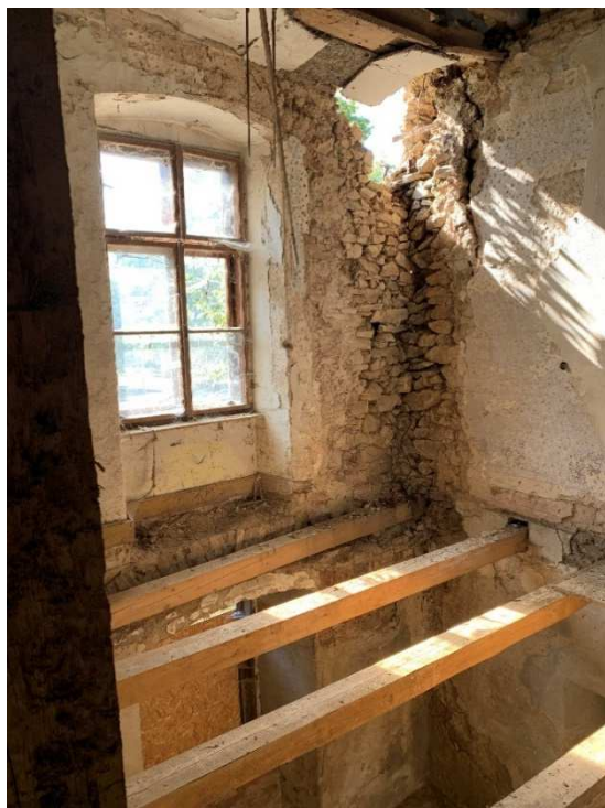
Obr. 22 (vlevo) – Pohled na degradované zdivo jižní odvodové stěny z místnosti č. 2.09
