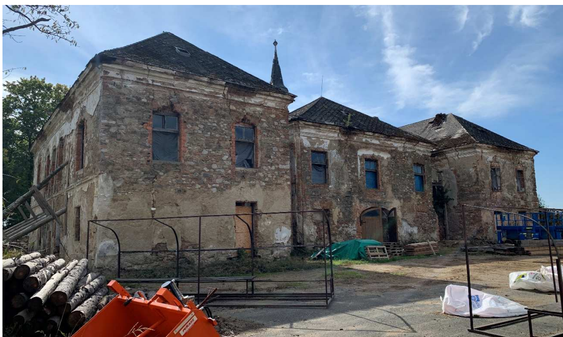
Obr. 2 – Pohled z hospodářského dvora na severní průčelí
