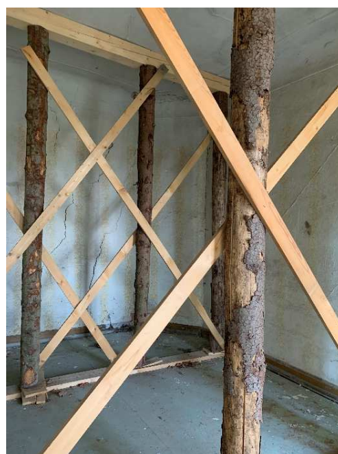
Obr. 39 (vlevo) – Pohled na porušenou stěnu napravo od vstupního portálu
