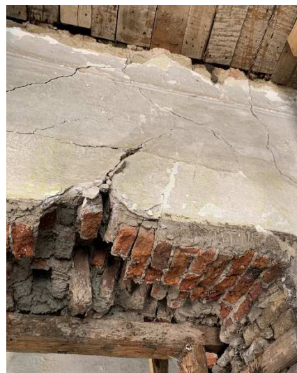
Obr. 28 (vlevo) – Místnost č. 1.24 – poškozená vodorovná i svislá nosná konstrukce [5] Obr. 29 (vpravo) – Dveřní nadpraží – pohled z místnosti č. 2.05 do místnosti č. 2.06
