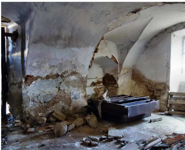
Obr. 26 (vlevo) – Místnost č. 1.09 – poškozené zdivo od vlhkosti [5]
