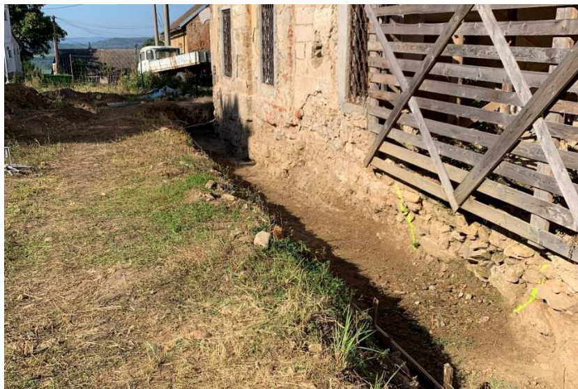
Obr. 21 – Pohled na základy jižního průčelí
