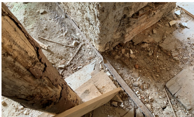
Obr. 20 – Ocelové kleštiny v podlaze v místnosti č. 2.10
