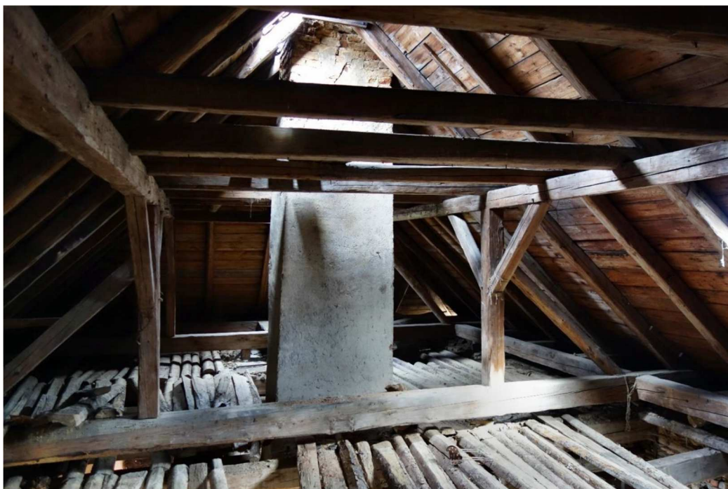
Obr. 13 – Krov – severní úsek východního křídla [5]
