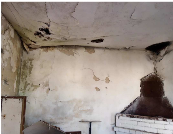
Obr. 28 (vlevo) – Místnost č. 1.24 – poškozená vodorovná i svislá nosná konstrukce [5] Obr. 29 (vpravo) – Dveřní nadpraží – pohled z místnosti č. 2.05 do místnosti č. 2.06
