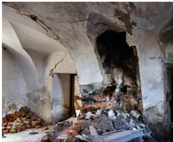
Obr. 26 (vlevo) – Místnost č. 1.09 – poškozené zdivo od vlhkosti [5]
