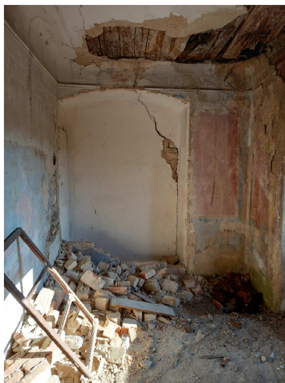
Obr.3.40 – Trhlina CV.3.10
