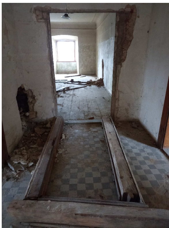
Obr. 3.56 – Vypadlá zárubeň
