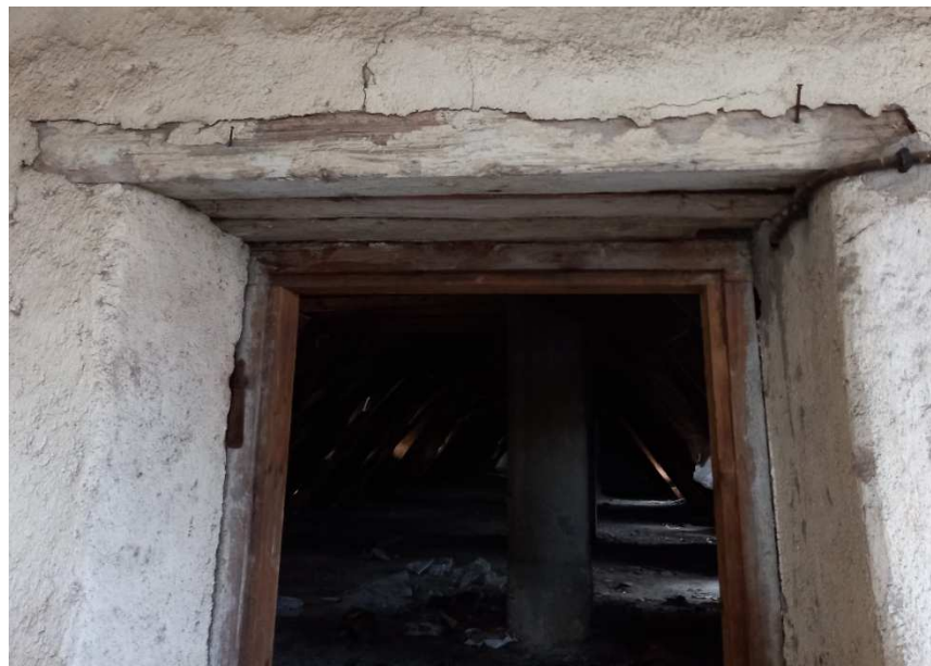
Obr. 3.9 – Překlad z dřevěných trámů
