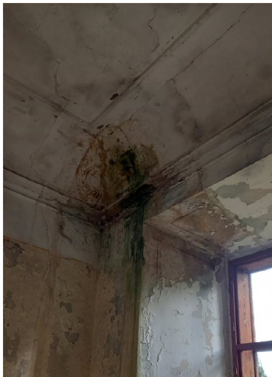
Obr. 3.48 – Začínající degradace trámového stropu nad 2.NP
