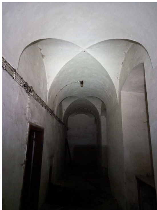
Obr. 3.1 - Křížová klenba ve valené klenbě
