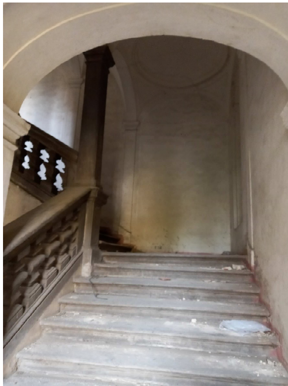
Obr. 3.18 – Nástupní rameno hl. schodiště
