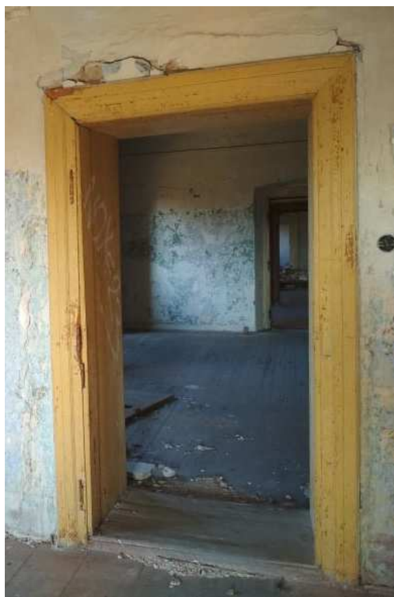
Obr. 3.25 – Kazetová obložková zárubeň
