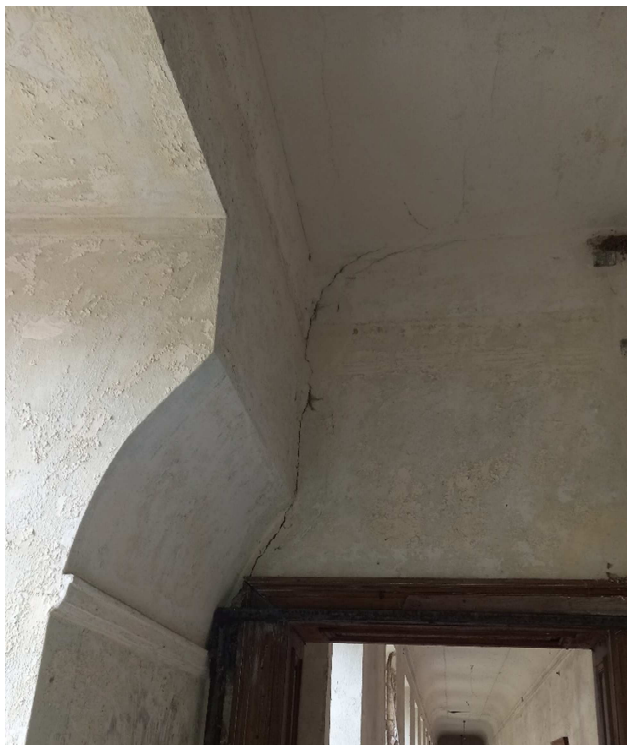
Obr. 3.41 – Trhlina CV2.1
