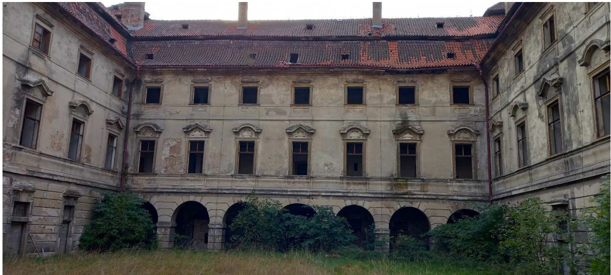
Obr. 3.22 – Pohled na jižní křídlo z nádvoří
