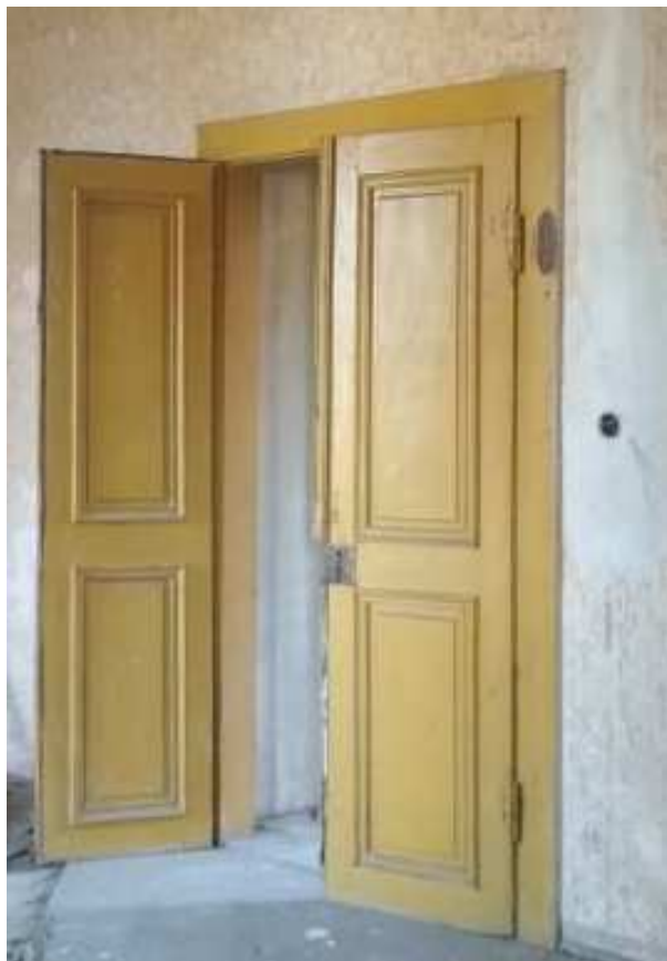
Obr. 3.24 – Dveře v obložkové zárubni
