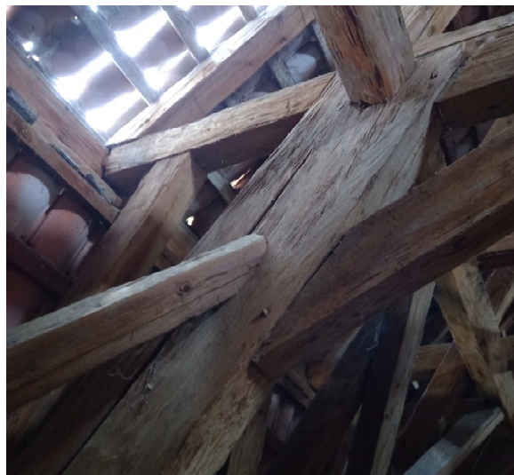
Obr. 3.12 – Detail okapní vaznice
