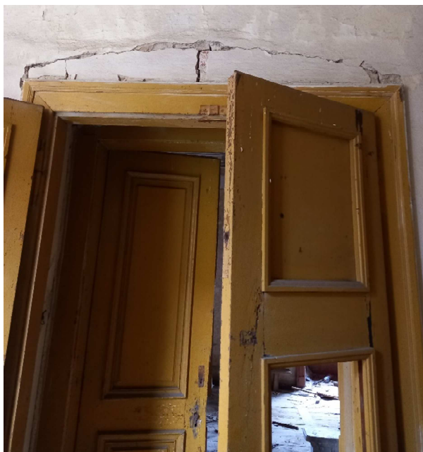
Obr. 3.26 – Kazetová obložková zárubeň s dvojitými křídly na obě strany
