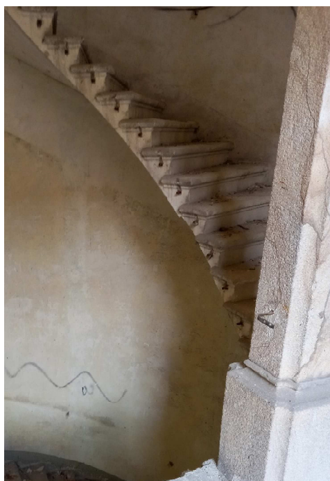
Obr. 3.53 – Kotvení zábradlí
