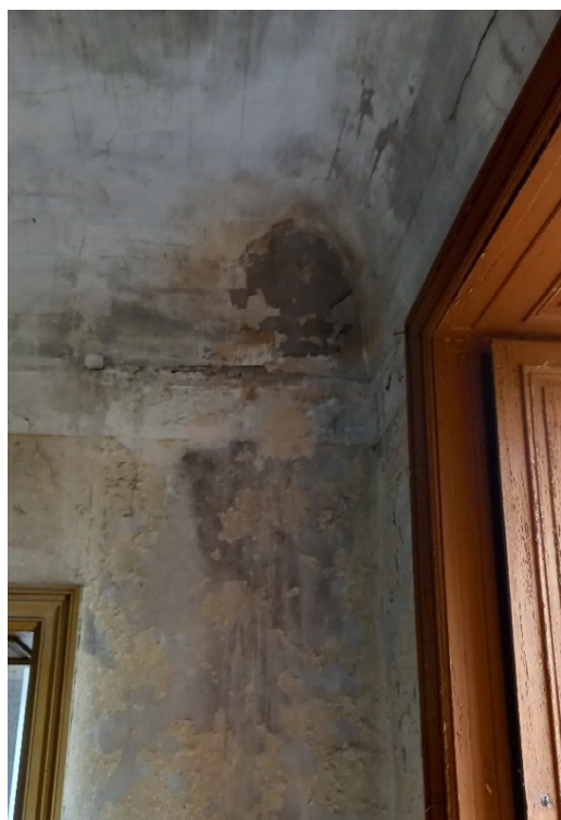
Obr. 3.48 – Začínající degradace trámového stropu nad 2.NP
