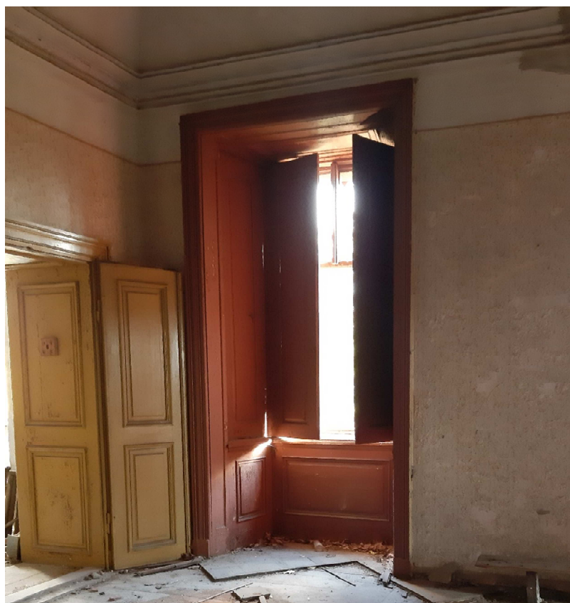
Obr. 3.21 – Dřevěný kazetový obklad ostění
