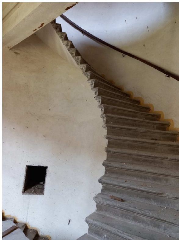
Obr. 3.20 – Východní Vedlejší schodiště
