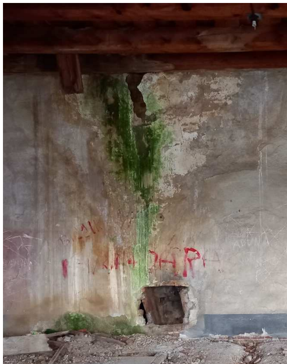
Obr. 3.67 – Výskyt zeleně vlivem zatékání
