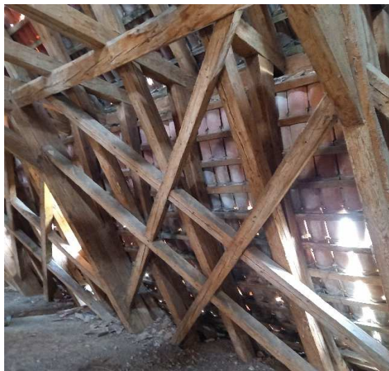
Obr. 3.11 – Zavětrování
