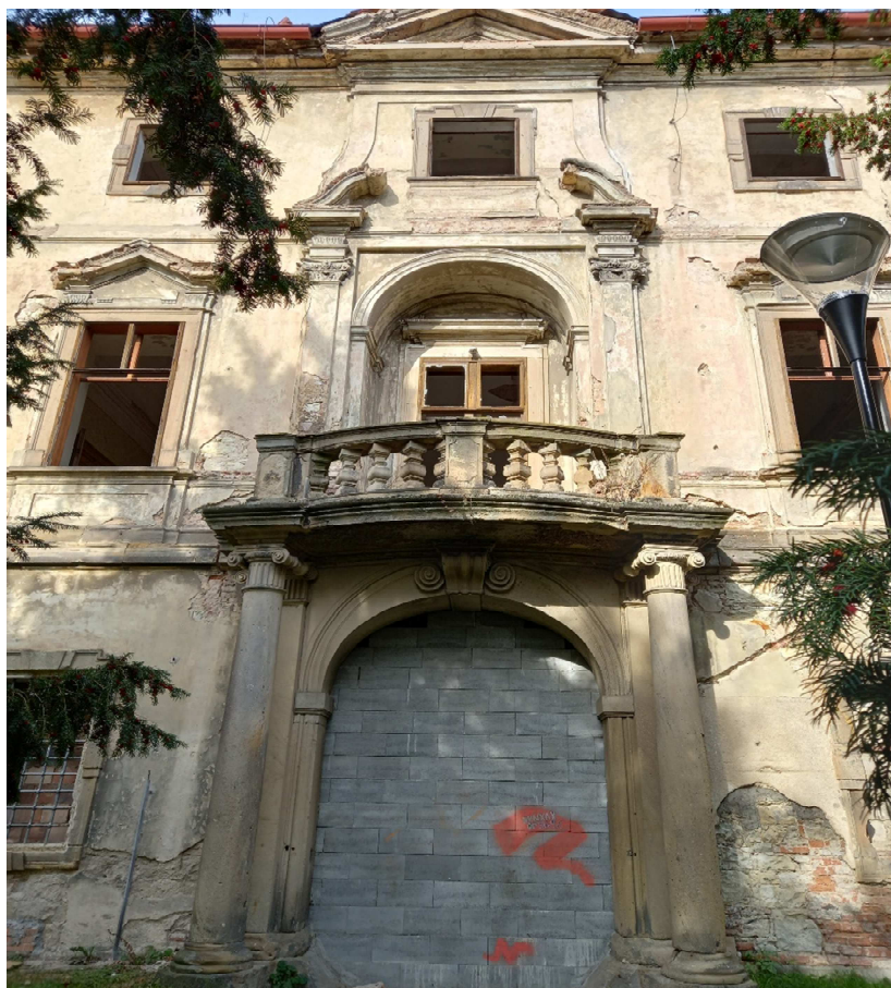
Obr. 2.4 – Zazděný vstup skrze jižní křídlo
