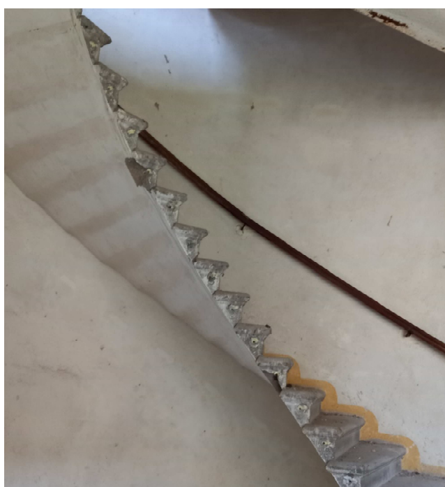
Obr. 3.54 – Uražené stupně
