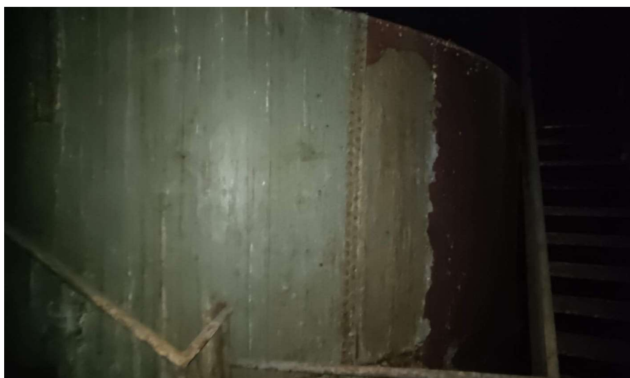
Obrázek 5 - Suterén budovy A2
