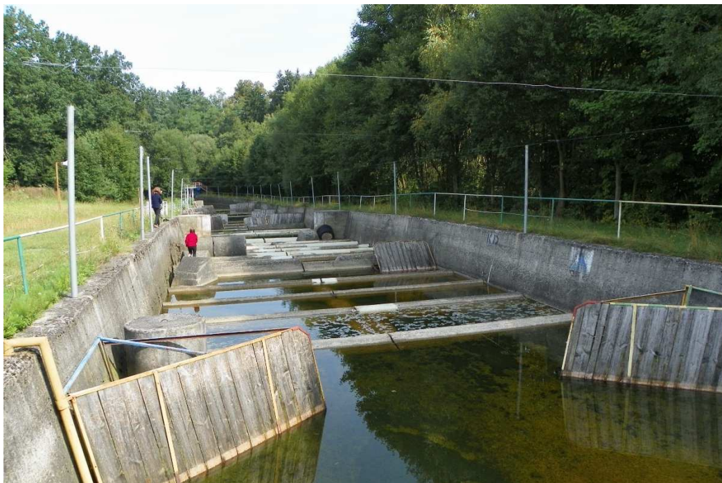
Obrázek 8 Překážky z dřevěných vrat na USD Trnávka. (dostupné z https://www.turistika.cz/mista/umely-slalomovy-kanal-na-trnavce/detail )
