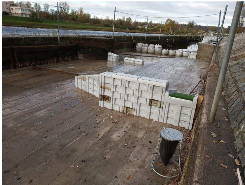
Obrázek 12: Konstrukce stavebnicových dílů Rapidblocs v modernizované části umělé slalomové dráhy v Troje. (dostupné z https://www.padler.cz/wp-content/uploads/sites/5/import/502/vodacky-slalomovy-kanal-praha-troja-zehlicka-rekonstrukce-1.jpg )
