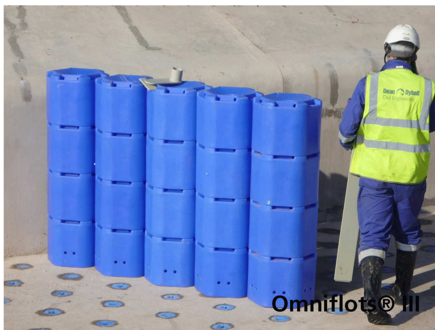
Obrázek 11: Instalace systému Omniflots do dnových panelů slalomové dráhy (dostupné z https://www.hydrostadium.com/en/catalogue/produit/omniflotsr-mobile-obstacles )
