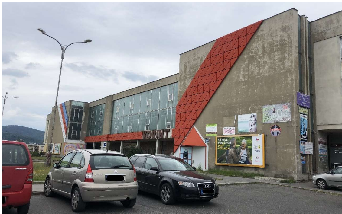
Obr. 3 Západní fasáda řešeného objektu
