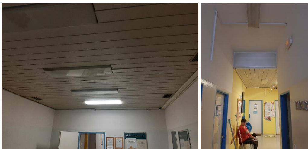
Obr. 13 Vývody VZT rozvodů (větrací mřížky) [3]
