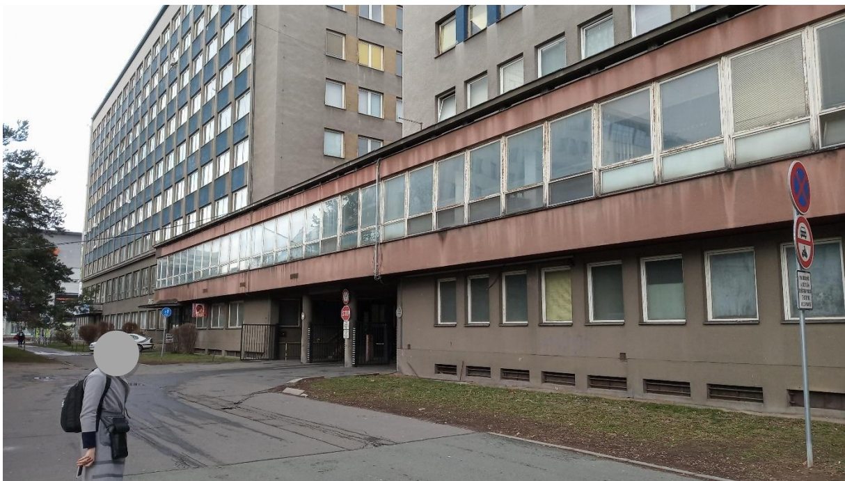
Obr. č. 2: Jižní strana objektu – Hlavní budova propojena krčkem s vedlejším objektem. (zdroj: vlastní fotodokumentace)
