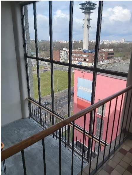
Obr. č. 12 - Zasklení schodišťových oken (zdroj: vlastní fotodokumentace)
