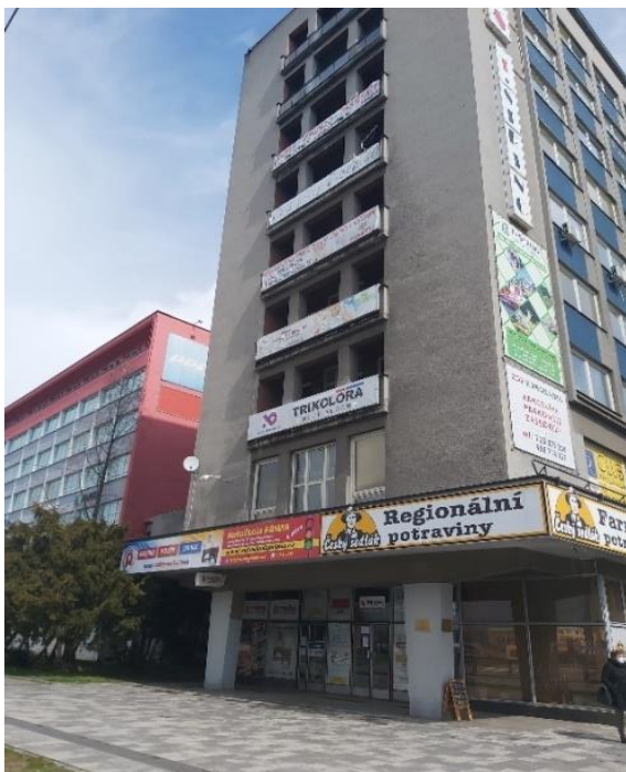
Obr. č. 13 - Prostor před objektem (zdroj: vlastní fotodokumentace)
