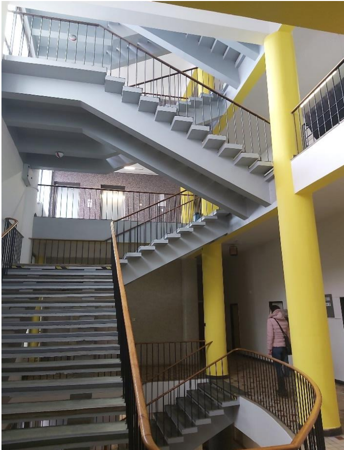
Obr. č. 6 - Hlavní schodiště budovy (zdroj: vlastní fotodokumentace)
