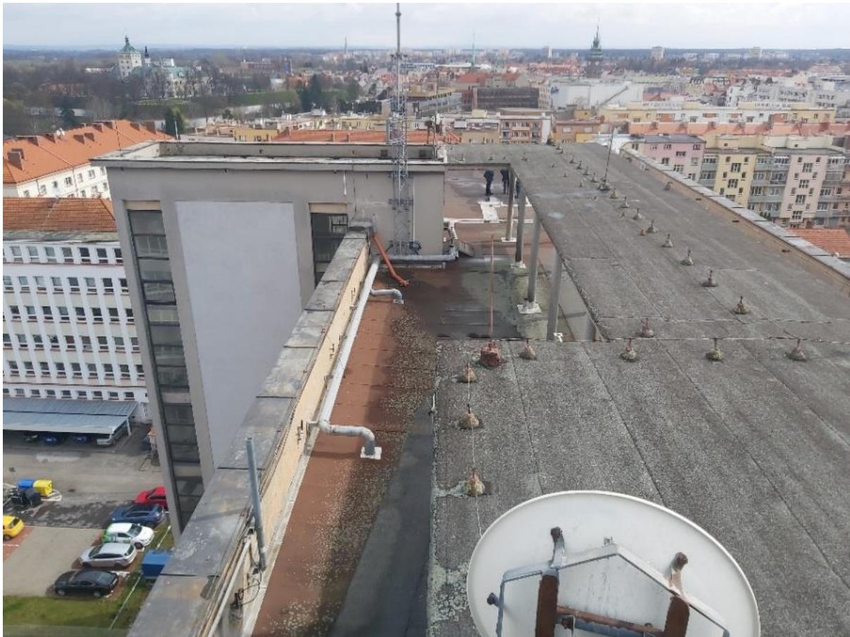
Obr. č. 4 - Střecha objektu (zdroj: vlastní fotodokumentace)
