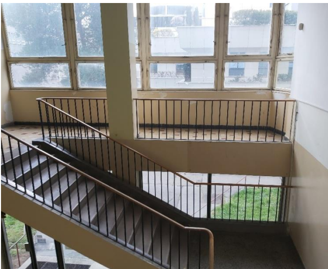
Obr. č. 11 - Zdvojená kyvná okna (zdroj: vlastní fotodokumentace)
