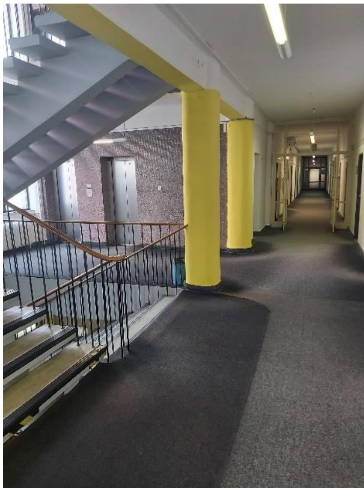
Obr. č. 9 - Část hlavního schodiště a chodba (zdroj: vlastní fotodokumentace)
