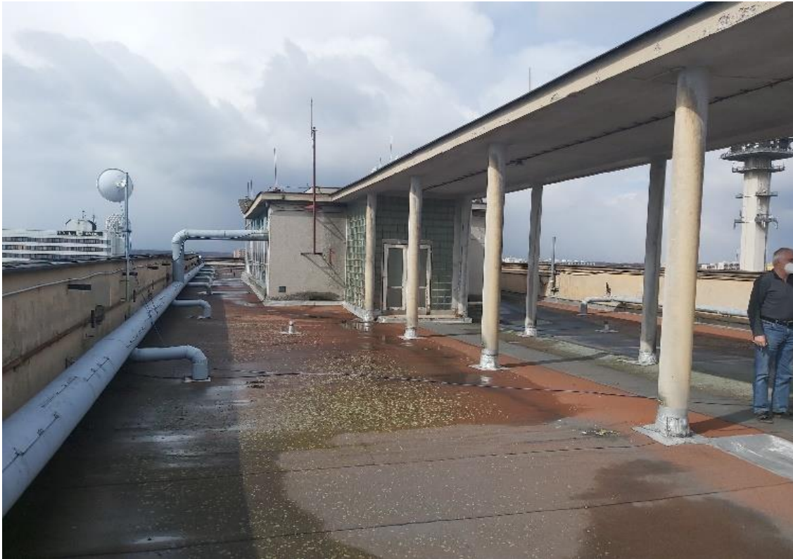
Obr. č. 5 - Terasa objektu 10.NP (zdroj: vlastní fotodokumentace)
