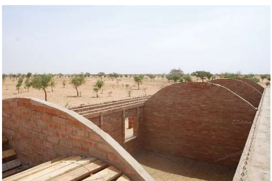
Obrázek 23 - Pohled na hrubou stavbu, zdroj: https://www.levs.nl/
