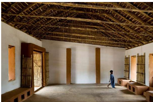
Obrázek 27 - Interiér budovy a pohled na bambusový krov, zdroj: https://www.zrs.berlin/
