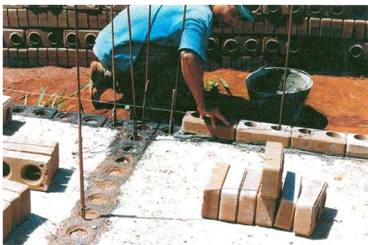
Obrázek 193 - Ukládání a vyztužování cihel, zdroj: https://www.jarfel.com.br/
