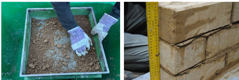
Obrázek 63 - Prosévání hlíny, foto: autor Obrázek 64 – Hl. malta v ložní spáře, foto: autor
