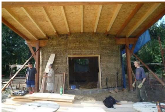
Obrázek 9 - Pohled na neomítnutou slaměnou stěnu, zdroj: https://www.idnes.cz/
