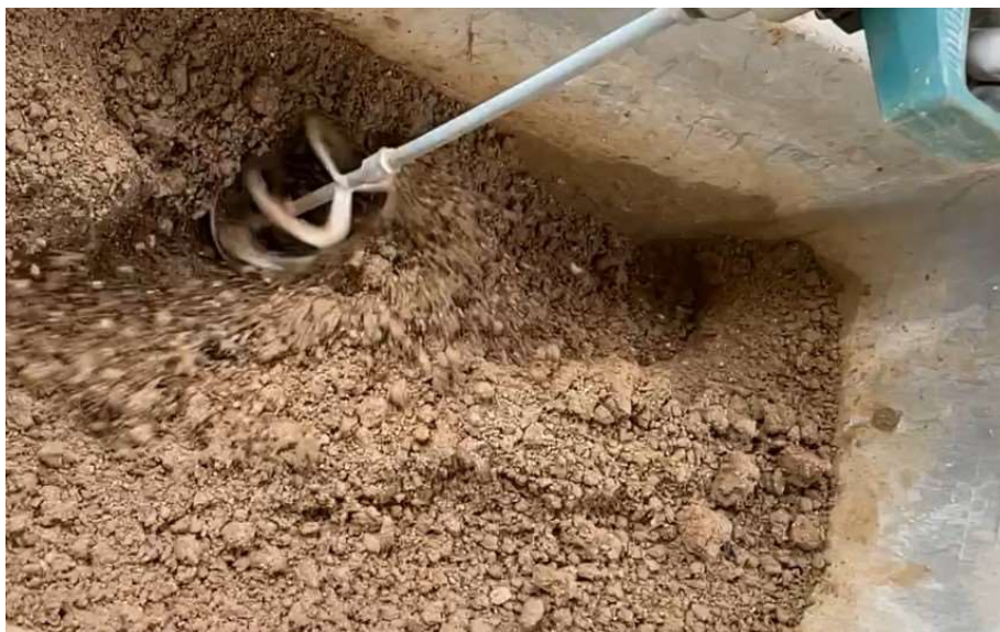
Obrázek 51 - Příprava hliněné směsi, foto: autor
