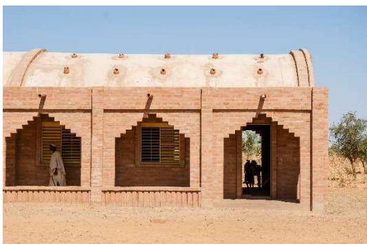
Obrázek 21 - Pohled na vstup do budovy, zdroj: https://www.levs.nl/
