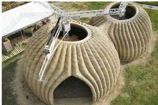
Obrázek 13 - 3D tisk domu, zdroj: https://www.mcarchitects.it/
