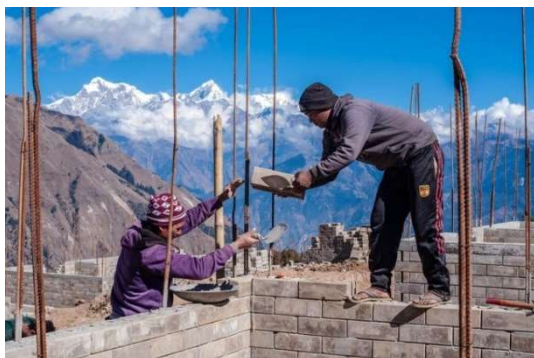
Obrázek 31 - Zdění vylisovaných cihel, zdroj: www.impactnepal.org
