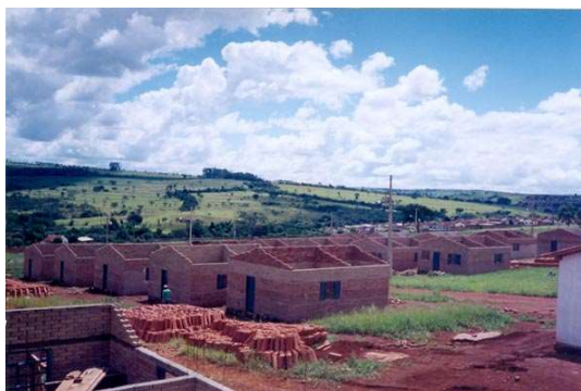
Obrázek 20 - Pohled na hrubou stavbu domů, zdroj: https://www.jarfel.com.br/
