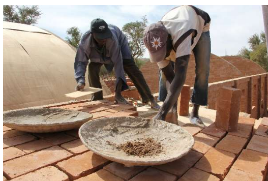
Obrázek 22 - Příprava hliněné směsi pro zastřešovací vrstvu, zdroj: https://www.levs.nl/
