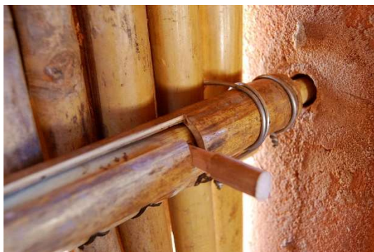
Obrázek 28 - Detail napojení bambusu a hliněné svislé konstrukce, zdroj: https://www.zrs.berlin/
