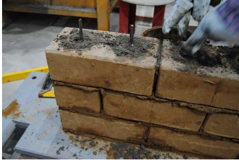
Obrázek 67 - Vyztužování pilíře, foto autor Obrázek 68 - Provazování výztuže, foto: autor
