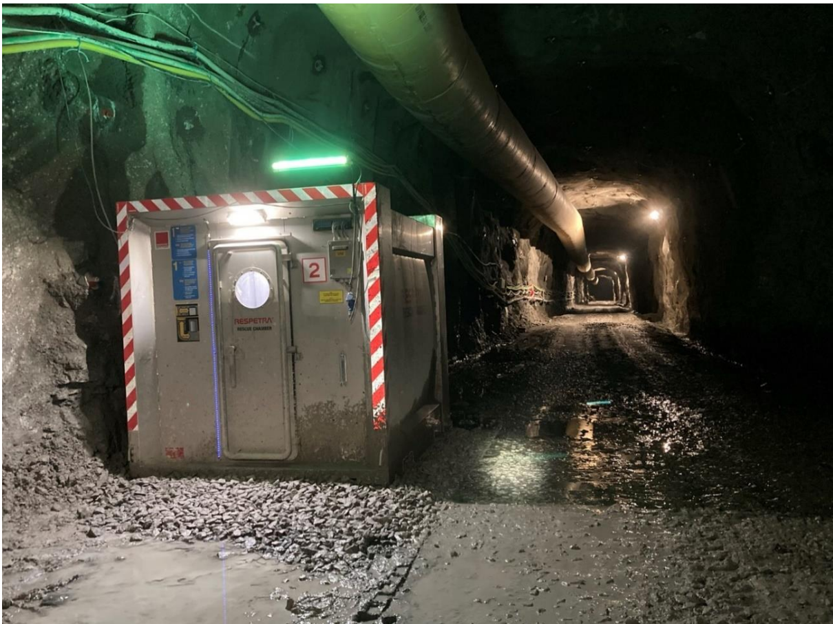
Obrázek 4 - Sebezáchraný kontejner na projektu Jarfalla ve Stockholmu, autorské foto
