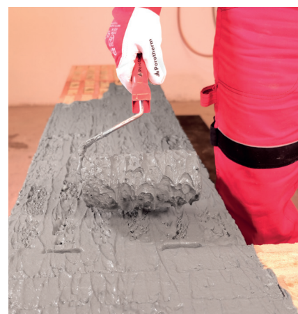
Nanášení celoplošné malty moltoprenovým válečkem Porotherm Easy na celou plochu ložné spáry cihel plněných minerální vatou
