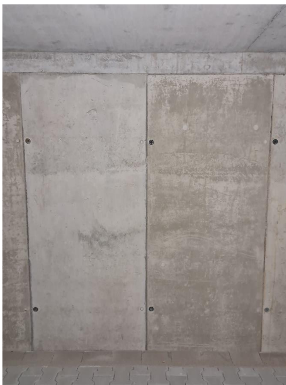
Obr. 50: Odchylka barevného odstínu vlivem nanesením špatného množství separačního postřiku, zdroj: vlastní
