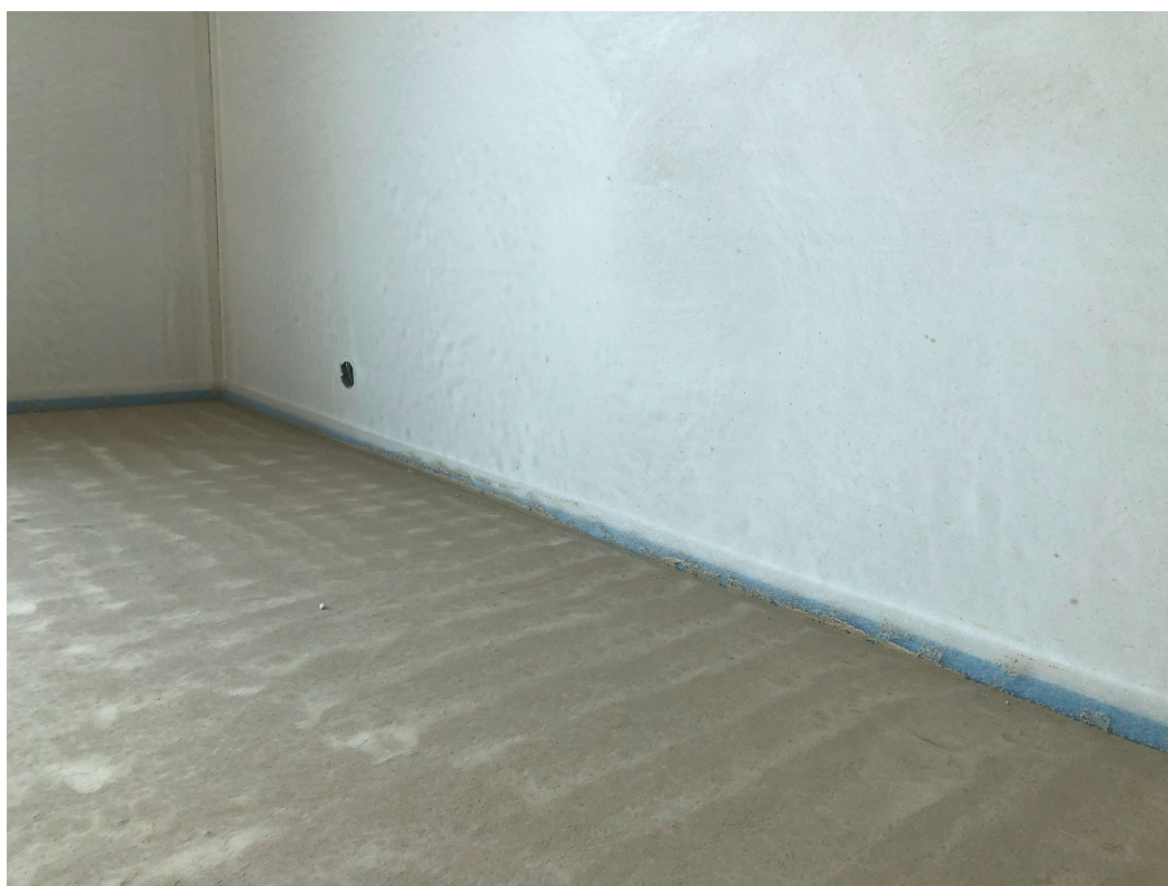
Obrázek 3.3: Okrajový dilatační pásek po obvodě místnosti [foto pořizeno autorem]
