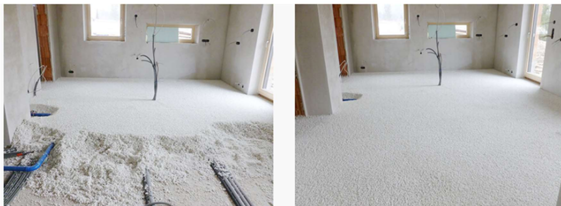
Obrázek 6.19: Pokládka systému a výsledná podoba izolační vrstvy po vyschnutí a zatvrdnutí [53]
