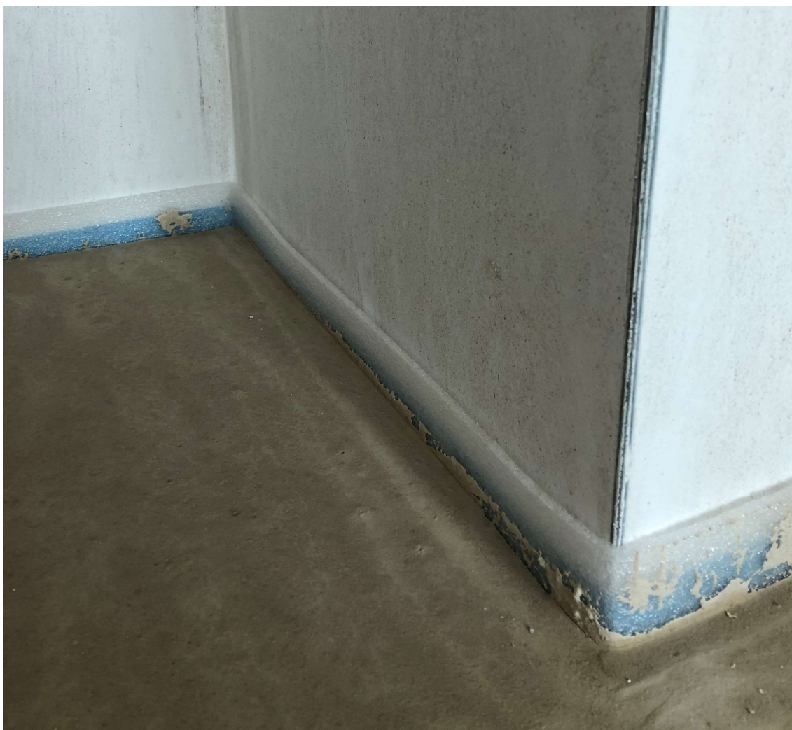
Obrázek 3.4: Okrajový dilatační pásek v detailu [foto pořízeno autorem]
