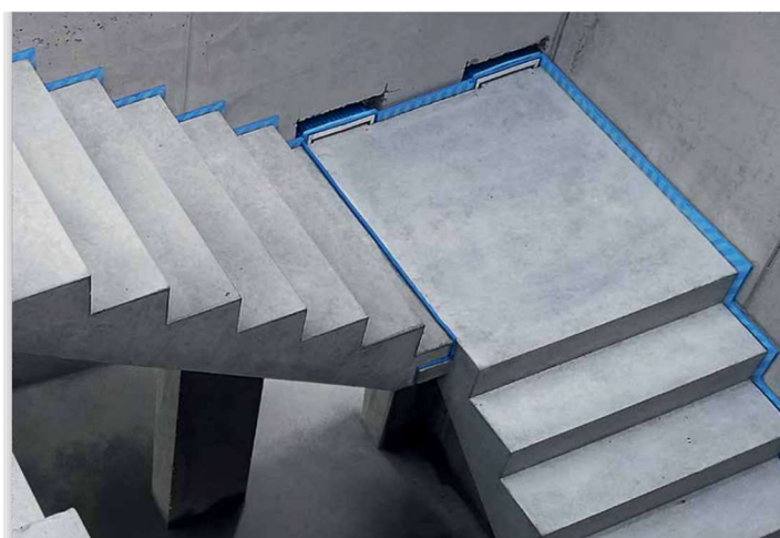
Obrázek 3.33: Ukázka řešení izolace schodiště na reálné stavbě [42]
