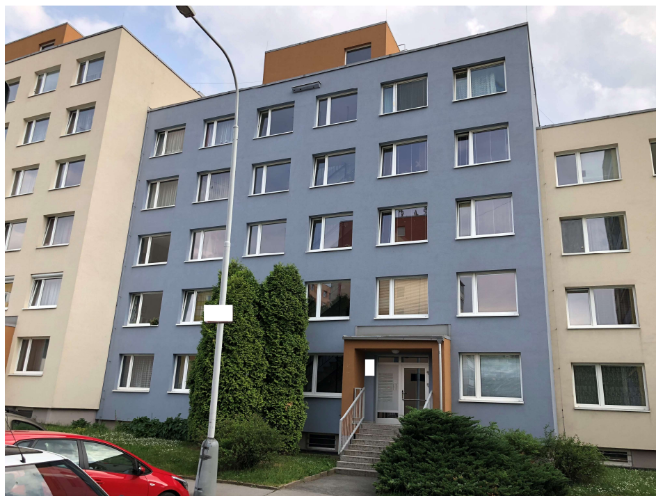
Obrázek 7.19: Objekt experimentálního měření 2 – panelový bytový dům typu VVÚ-ETA z roku 1986 [foto pořízeno autorem]
