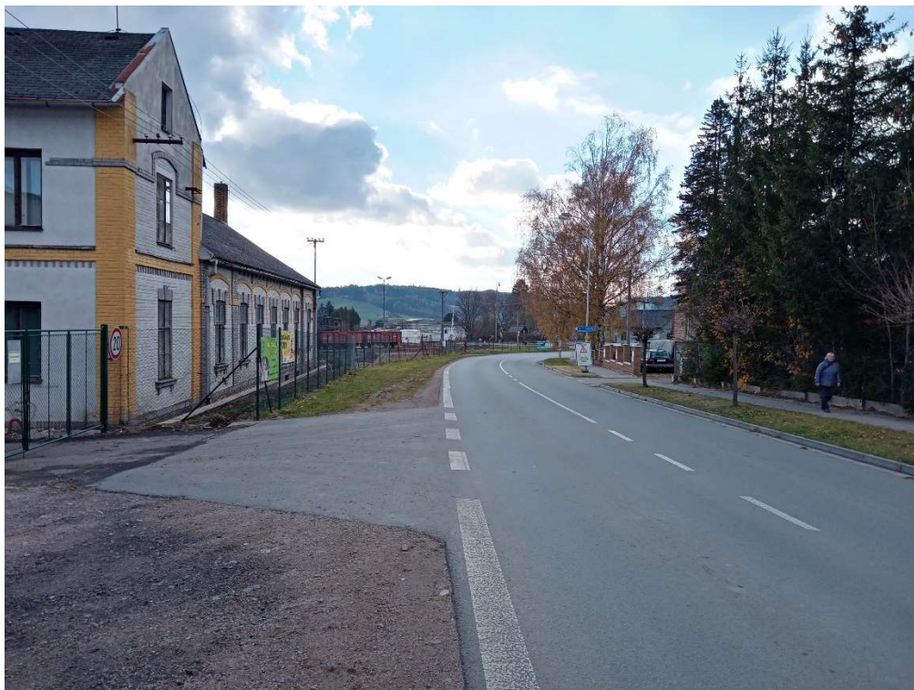
Obrázek 13: Pohled na Nádražní ulici, místo směrového vedení varianty 1
