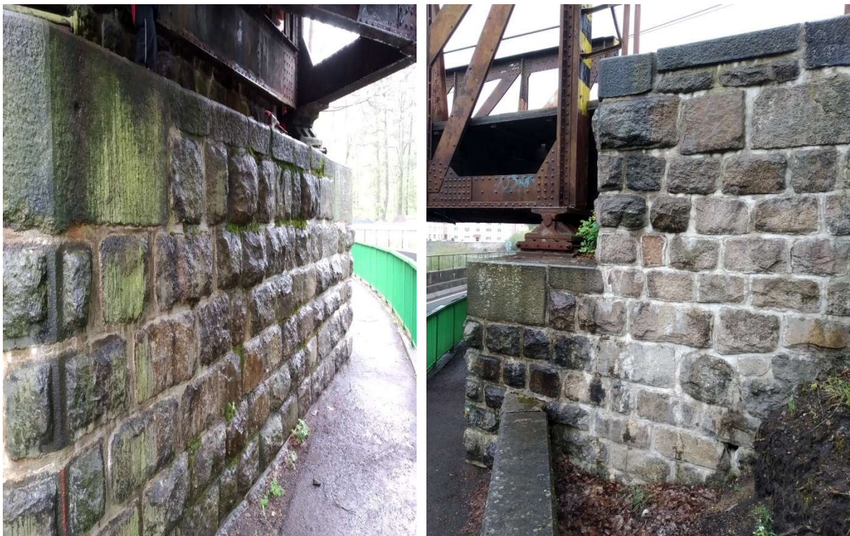
Obr. 49: Pohled na opěru OP1
