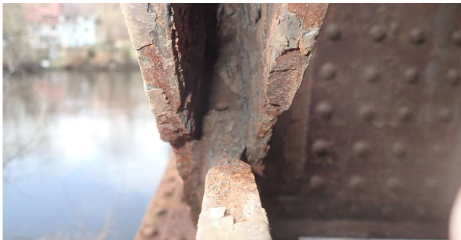
Obr. 29: Detail oslabení styku diagonály a dolního pasu
