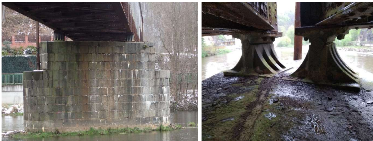
Obr. 51: Pohled na pilíř a pevná ložiska
