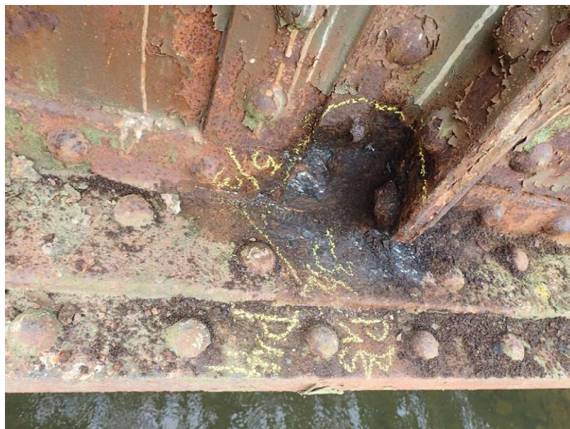
Obr. 33: Oslabení svislic v místě přípoje k dolnímu pasu (vnější strana)
