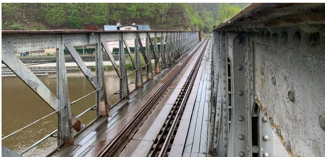
Obr. 22: Hlavní příhradové nosníky – K2 proti směru staničení
