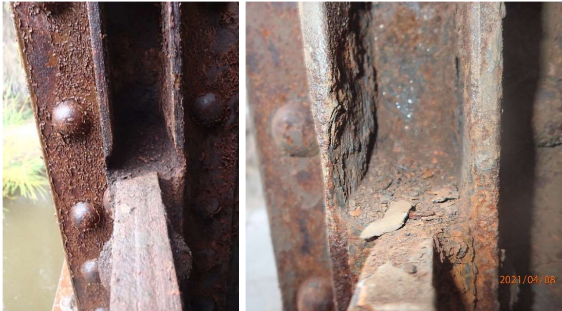
Obr. 32: Oslabení svislic u přípoje dolního pasu
