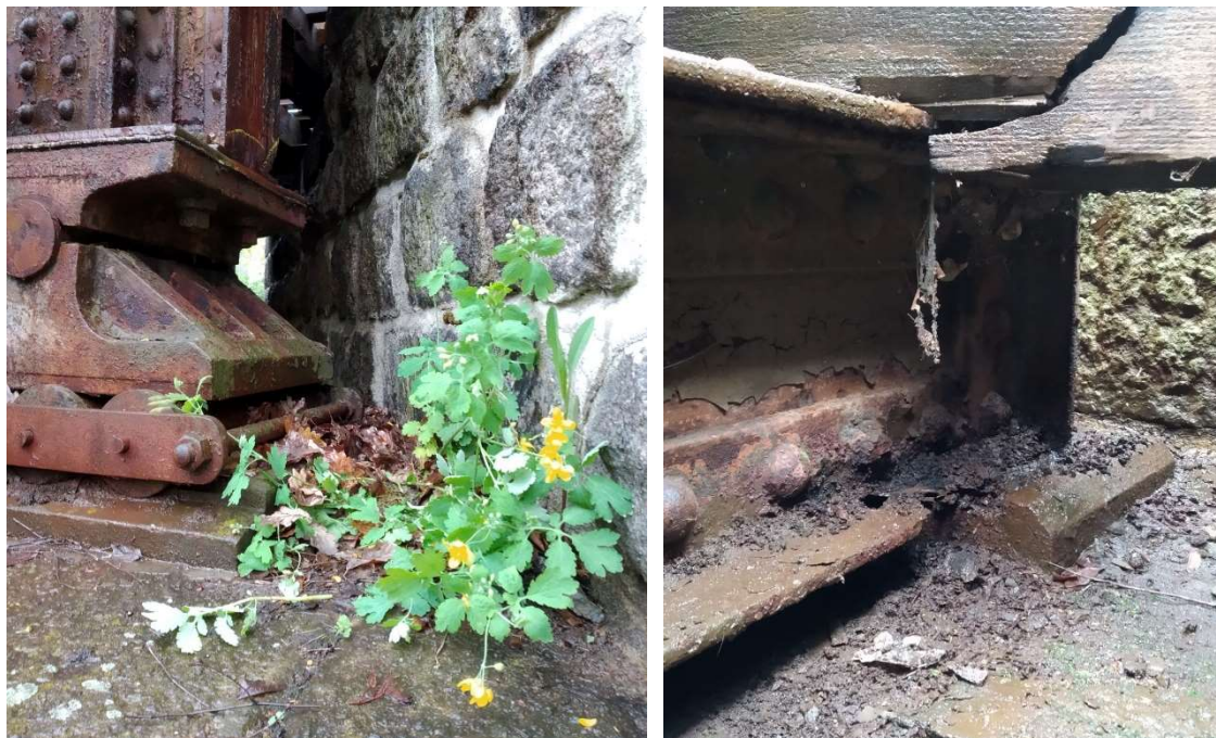
Obr. 50: Válečkové a podružné ložisko podélníku na OP1
