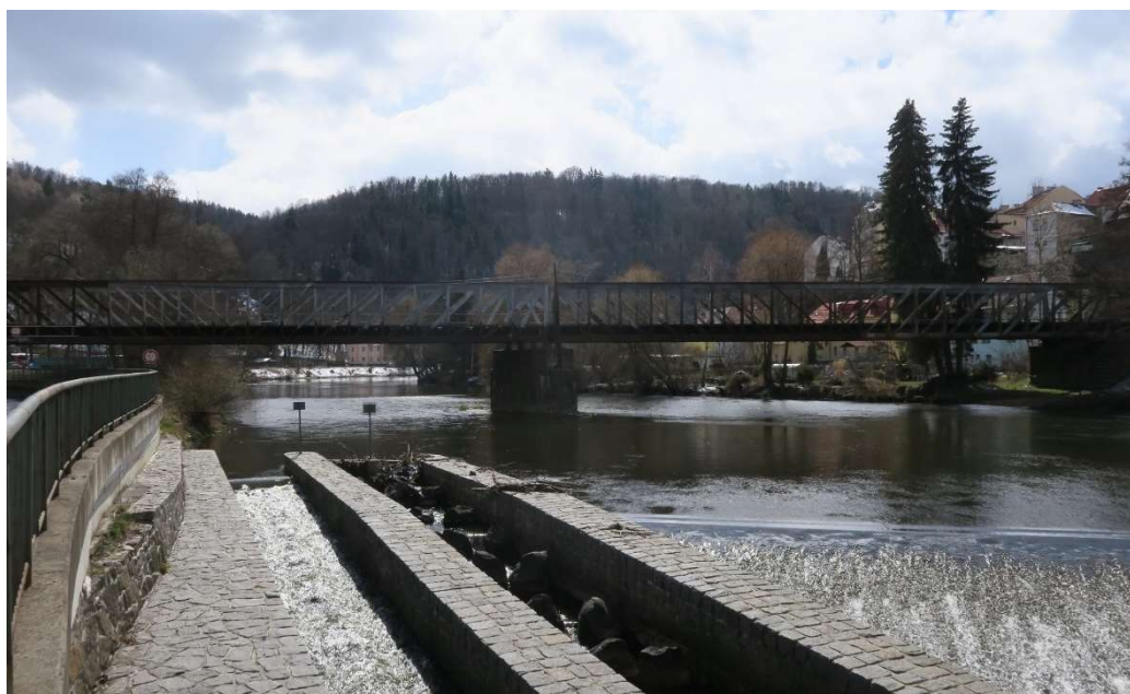
Obr. 1: Pohled na železniční most v Lokti
