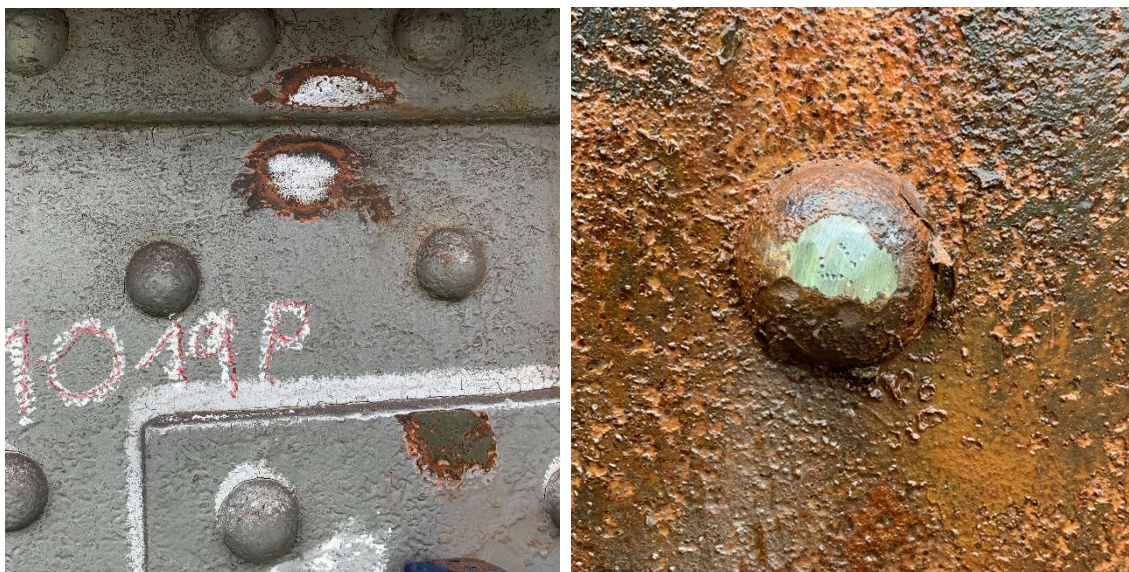
Obr. 59: Očištění konstrukce a provedení tvrdoměrné zkoušky
