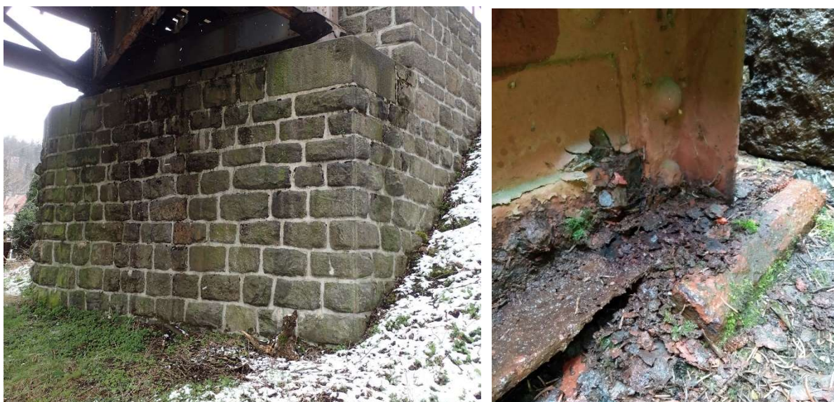
Obr. 52: Pohled na OP2 a podružné ložisko podélníku
