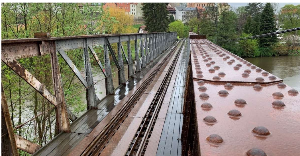
Obr. 21: Hlavní příhradové nosníky – K1 ve směru staničení
