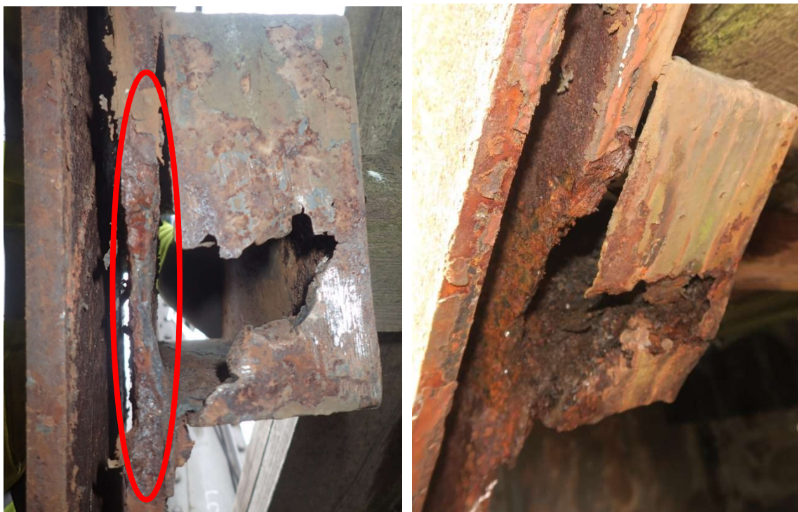
Obr. 31: Oslabení diagonál u stálého zařízení
