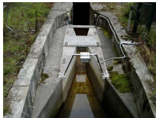
Obrázek 23 Parshallův žlab (35)
