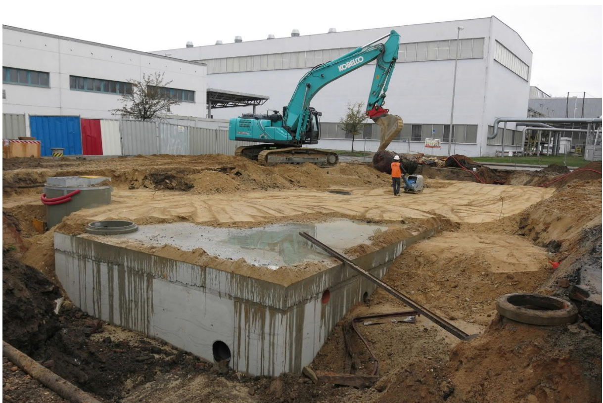
Obrázek 19 - Fotografie retenční nádrže M12L z realizace (zdroj: Škoda Auto, a.s.)
