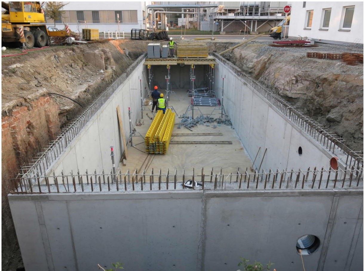
Obrázek 20 - Fotografie retenční nádrže M12L z realizace (zdroj: Škoda Auto, a.s.)
