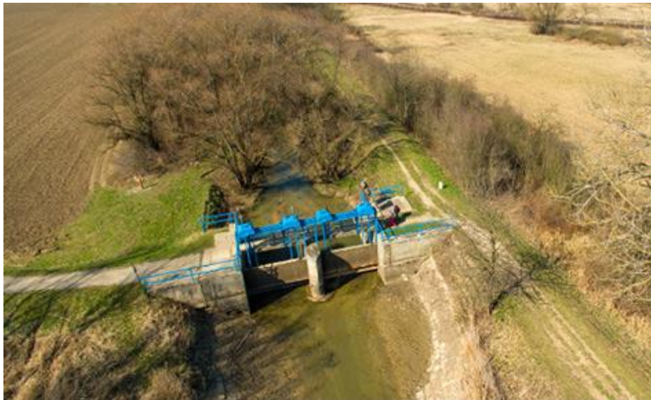
Obrázek 6 - Stávající stav jezu Sudoměřice (8)
