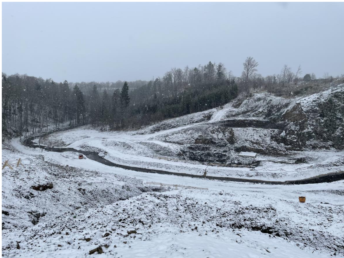
Obrázek 2: Stavba poldru Kutřín v prosinci 2021, Šilinkův důl. Autor DP.
