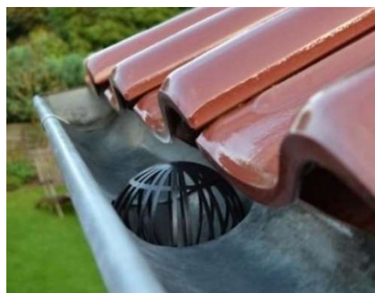
Obrázek 7 Lapač listí v hrdle svodu [12]
