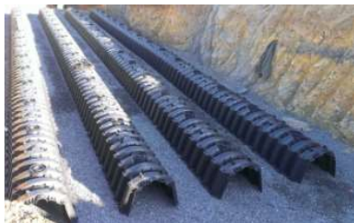
Obrázek 24 Založení systému vsakovacích tunelů [31]
